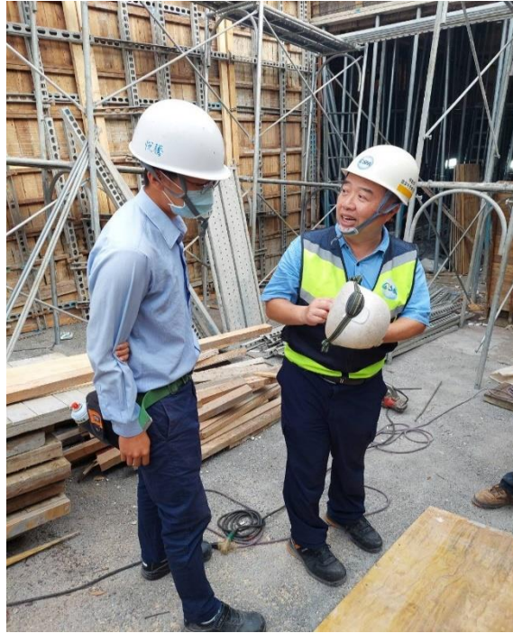
職安署中區職業安全衛生中心李文進主任率檢查員前往臺中市某建築工地實施勞動檢查。
