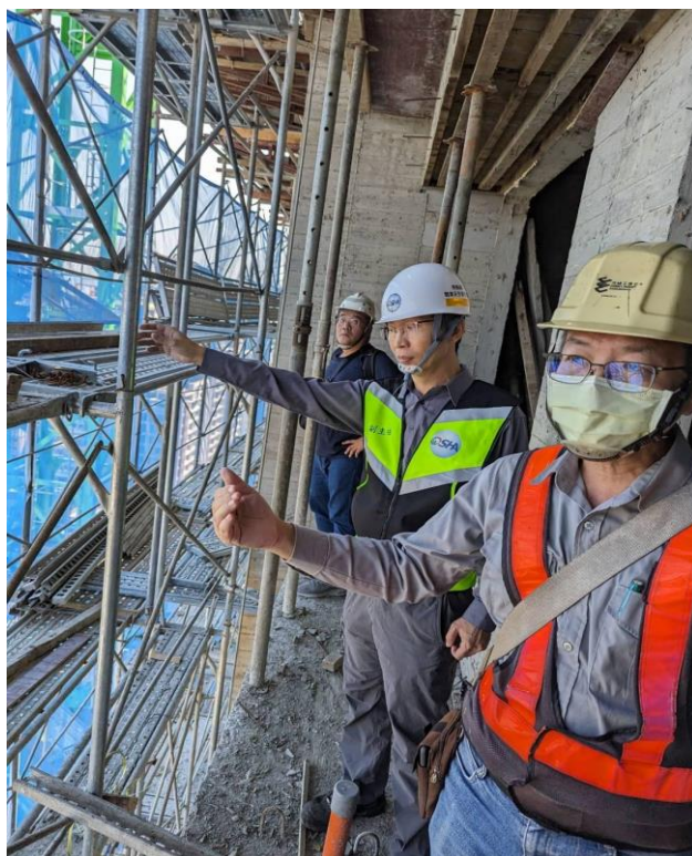
職安署北區職業安全衛生中心陳光輝副主任率檢查員前往桃園市某建築工地實施勞動檢查。
