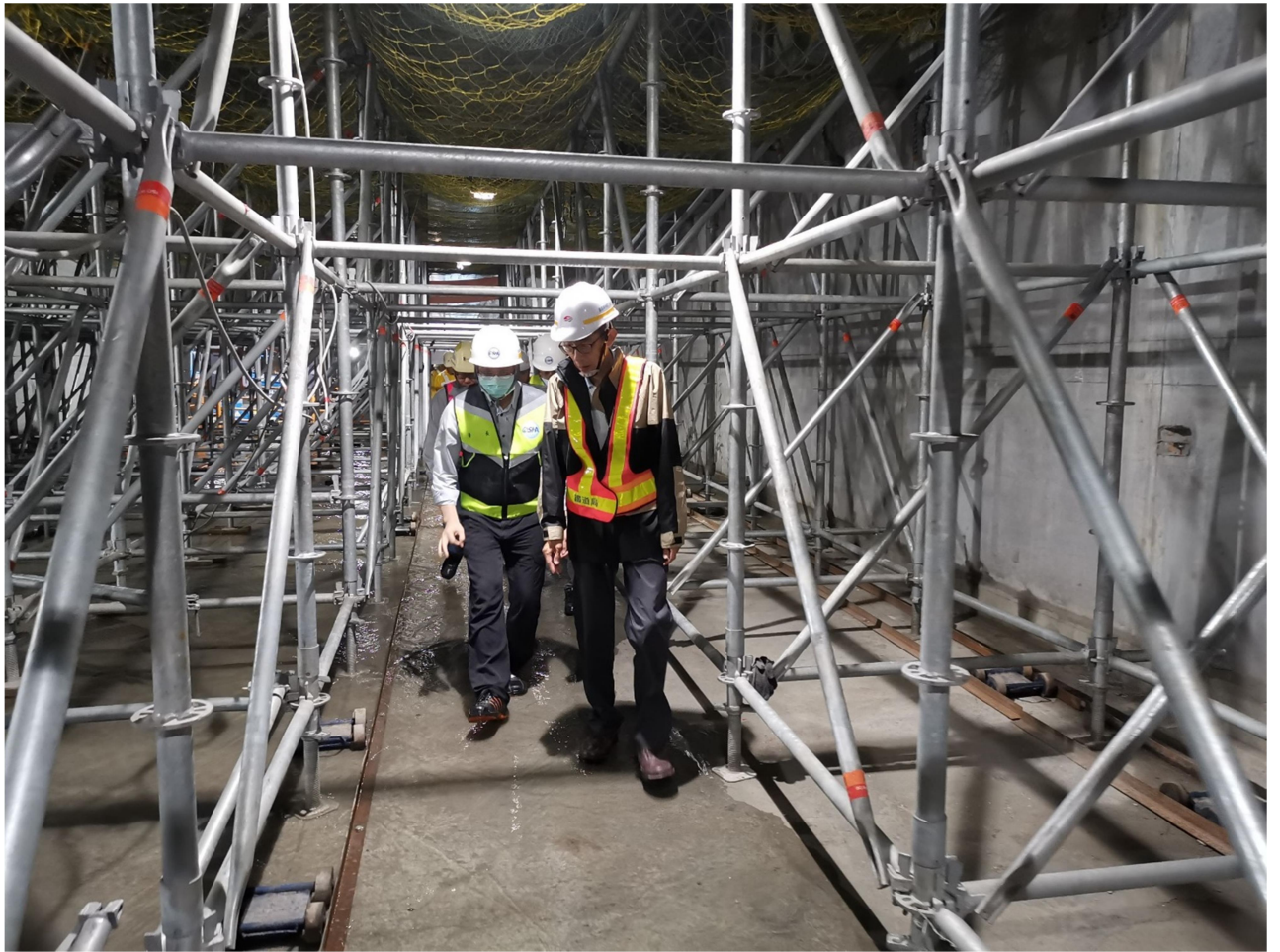
鄒子廉署長與黃鳳岡處長巡查隧道滑動模板組立情形
