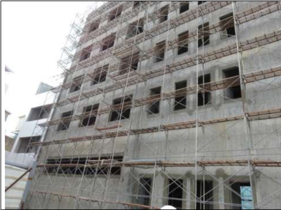
說明 照片一：災害發生於台南市永康區「○○新建工程」東側外牆施工架工作臺處。
