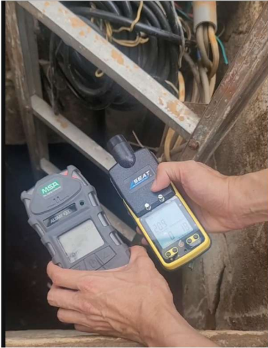
照片 1：化糞池內，以衍生管之空氣偵測器測得內部硫化氫濃度為 240 ppm。
