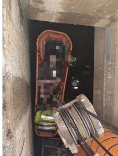
照片 2：於蓄水池內使用發電機，造成人員一氧化碳中毒後，緊急吊掛救援。
