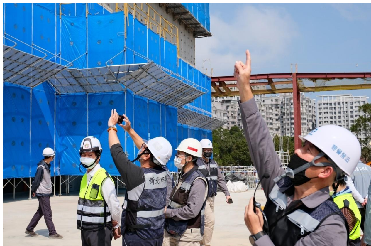
觀摩工地外牆施工架透過高程檢討，讓施工架踏面組立後能維持平整。
