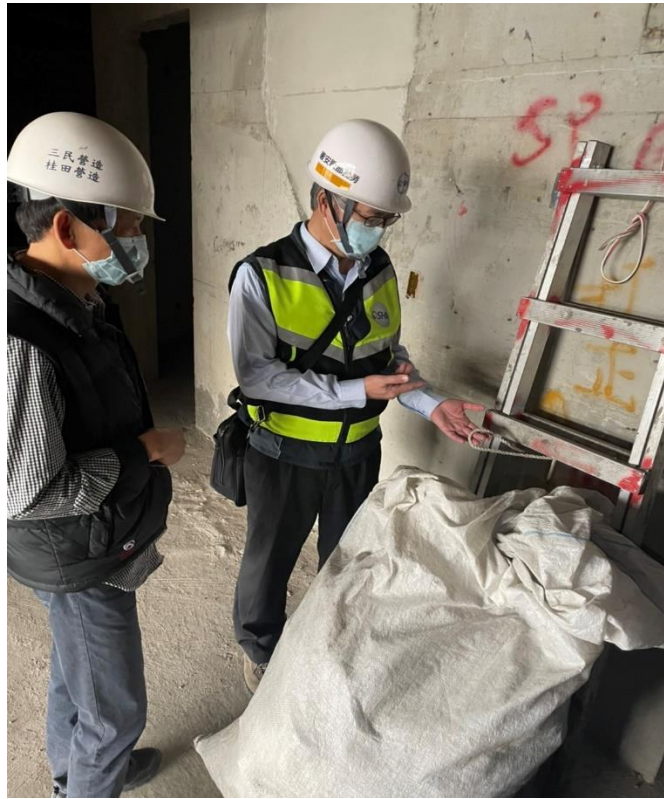
桃園市某營造工地使用不合格合梯。
