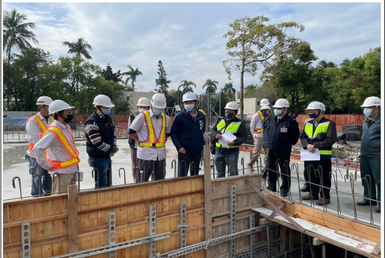
本署李柏昌副署長、高雄市政府勞工局周登春局長率檢查員前往高雄市某營造工地實施勞動檢查。
