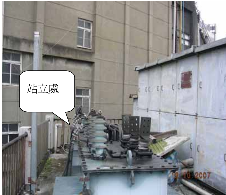
照片 1：現場情況
