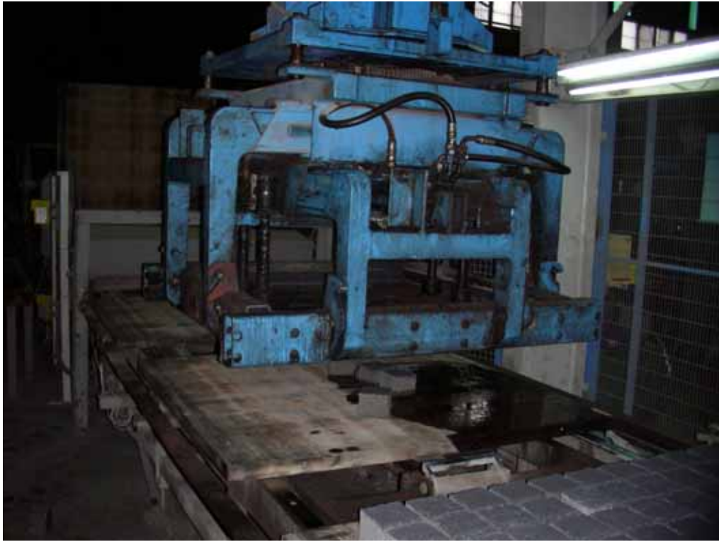
照片 1：災害現場
