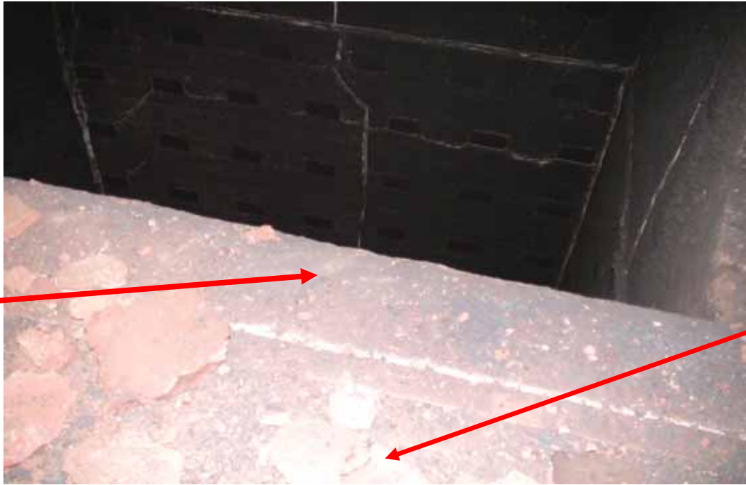
照片 1：欄杆至煙道口之地面散落耐火材，耐火材有踩踏及疑似人員墜落痕跡
