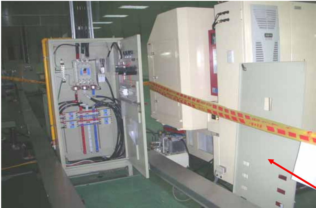
照片 1：配電箱之中隔板拆下放置於一旁
