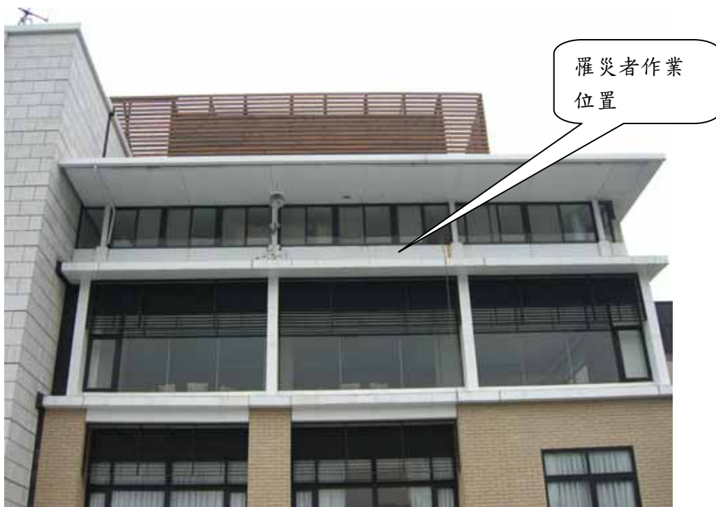
照片 1：罹災者作業現場外牆情形 (屋頂及各樓層設有屋凸無法架設一般移動式吊籠)
