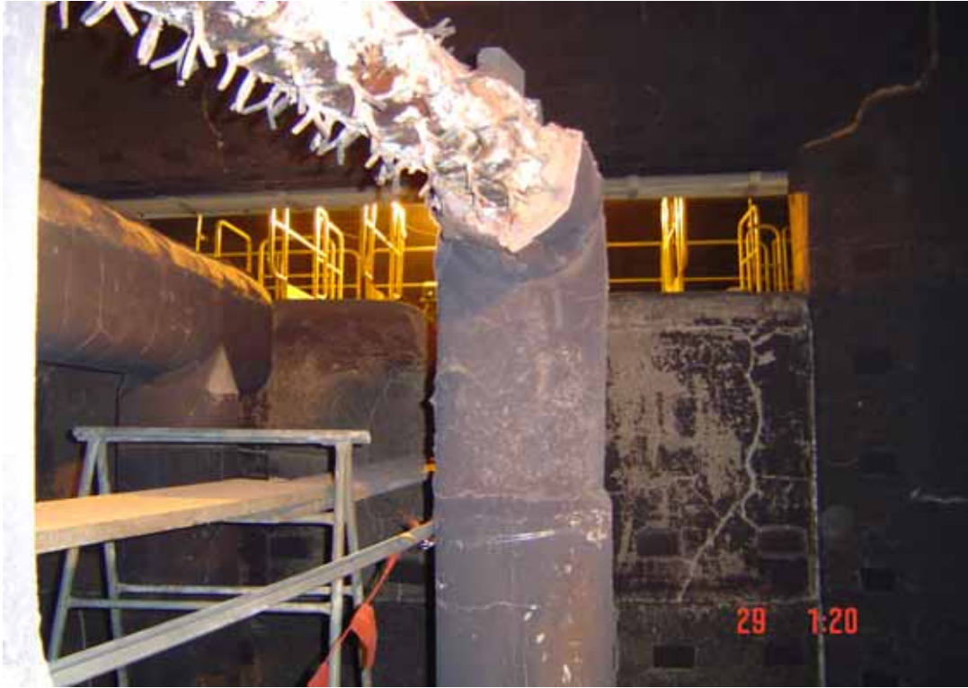
照片 3：欄杆間隙過大（寬 140 公分×高 70 公分），勞工可輕易穿越欄杆，未達防止進入之效果
