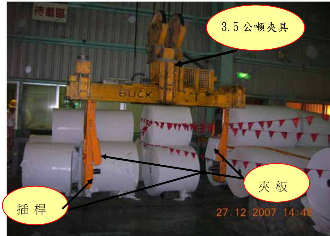
照片 1：肇事雙軌架空固定式起重機，桁架上配置 1 座吊升荷重 3.5 公噸夾具，夾具兩側各設有夾板及插桿
