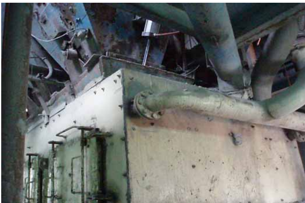
照片 2：拌合機為一四方形集料槽內設拌合器作為攪拌混凝土用
