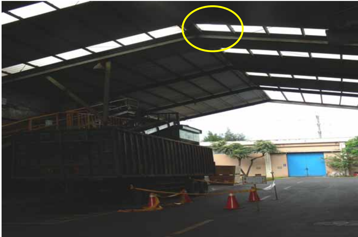
照片 1： 菲勞 Laxamana Jun Subaste 踏穿採光塑膠浪板墜落現場(一)
