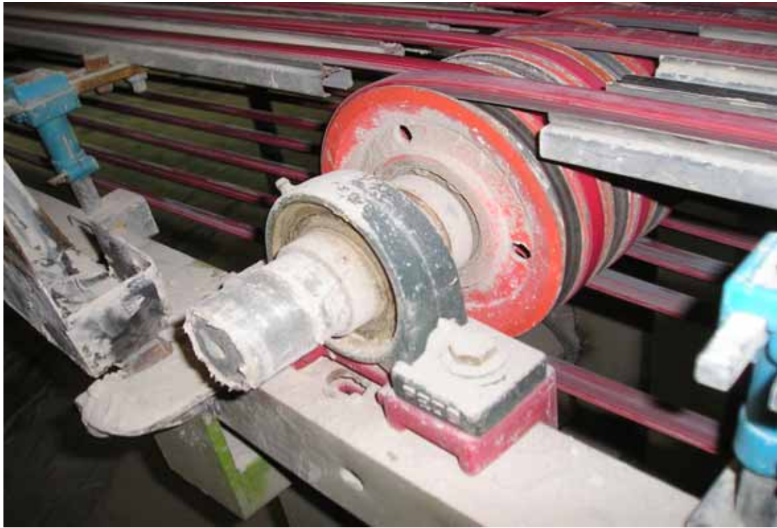
照片 1：災害現場—6 號成型機後之出料輸送帶
