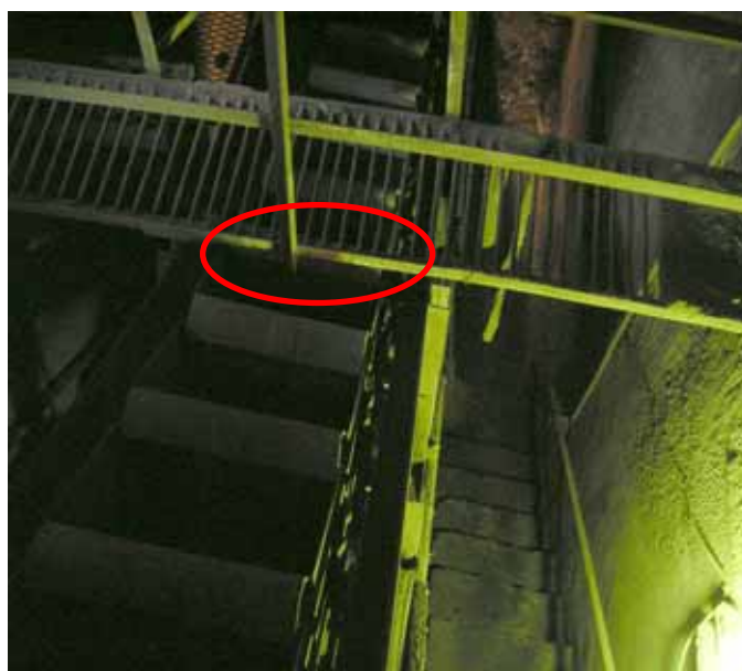
照片 1：由一樓平面往地下室發現輸送帶上之鐵架有血跡
