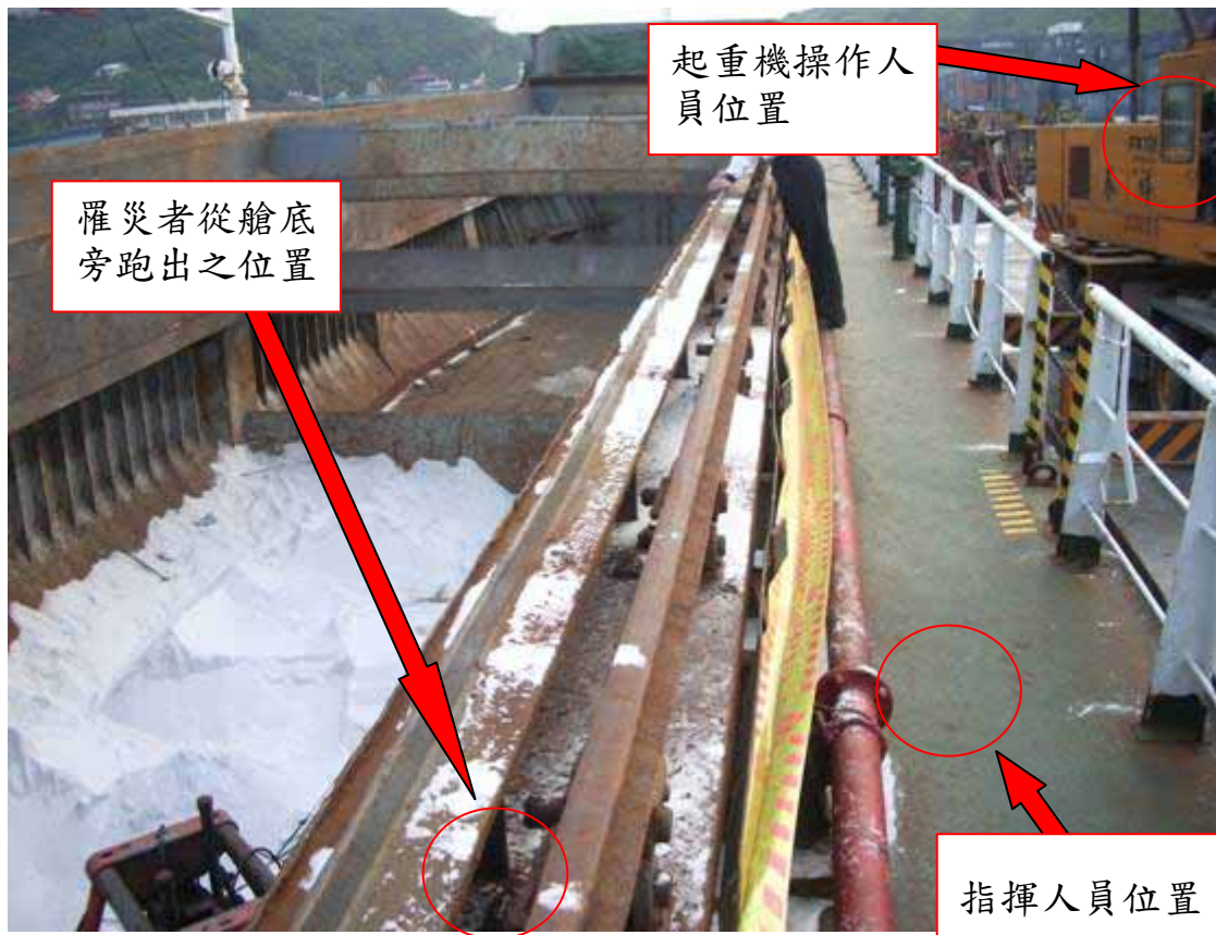
照片 2：事故當日以起重機吊掛抓斗從事矽砂卸貨作業，起重機下方未有人員管制措施
