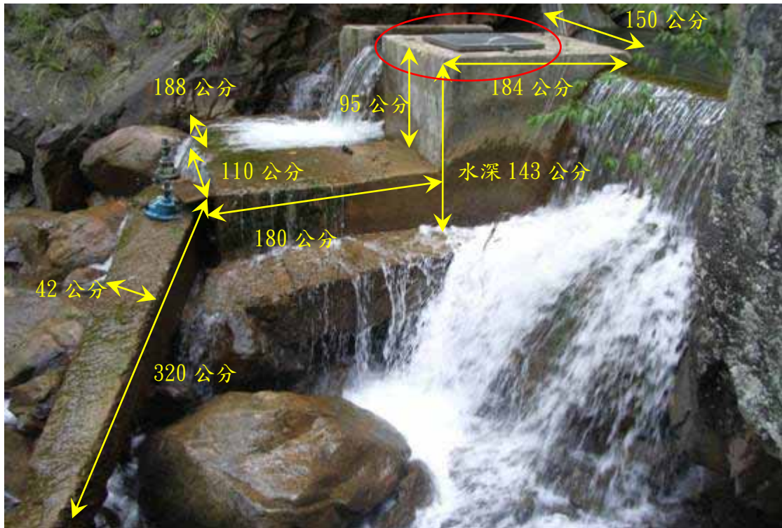
照片 1：事故當日罹災者疑似因把堵塞住直徑 15 公分之原水管上之雜草及樹枝拿掉後，就被水源之水流吸入取水口內，而溺斃死亡。(罹災者身高 167 公分，體重 64 公斤)
