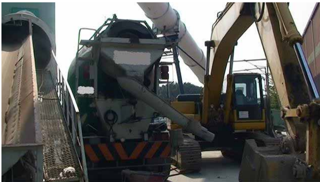
照片 1：罹災者使用之預拌混凝土車（入料槽已拔除）搶救時取出之入料槽
