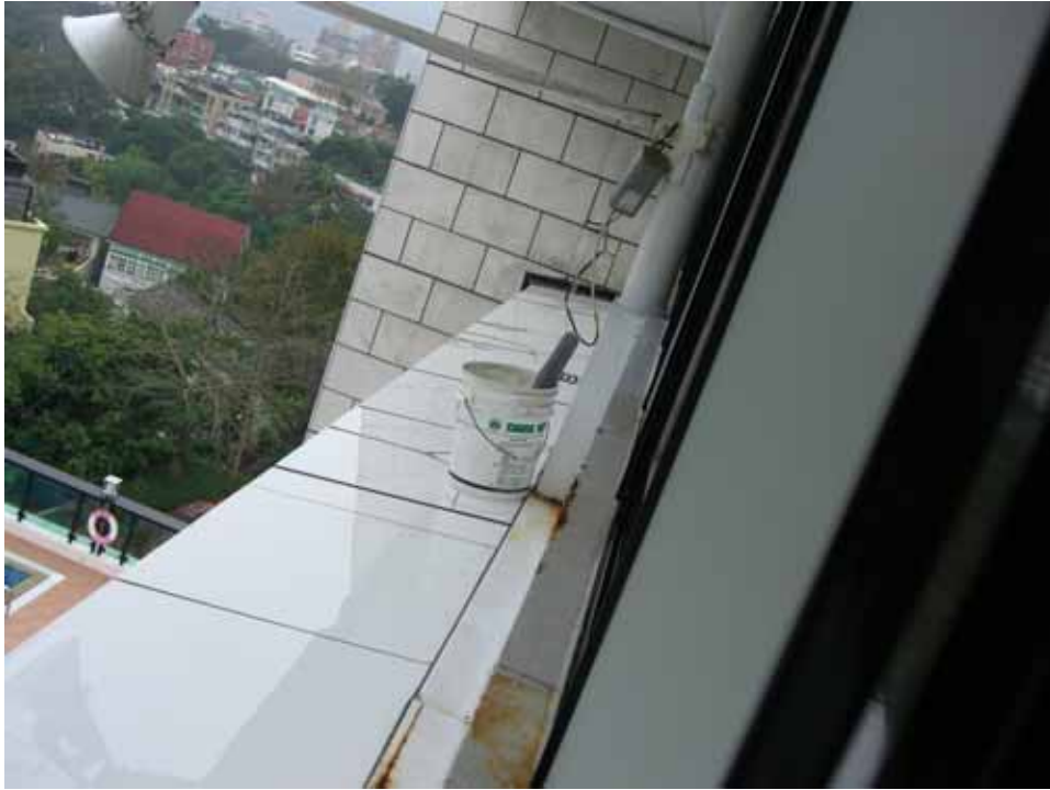
照片 2：6 樓屋凸作業現場
