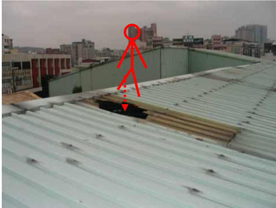
照片 4：由室外觀看罹災者踩破採光罩之破洞
