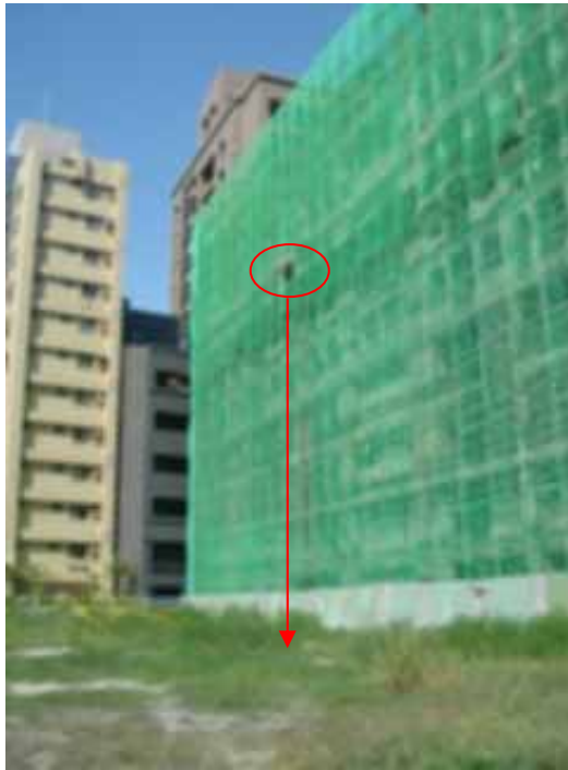
照片 1：罹災者自工地 6 樓墜落至地上
