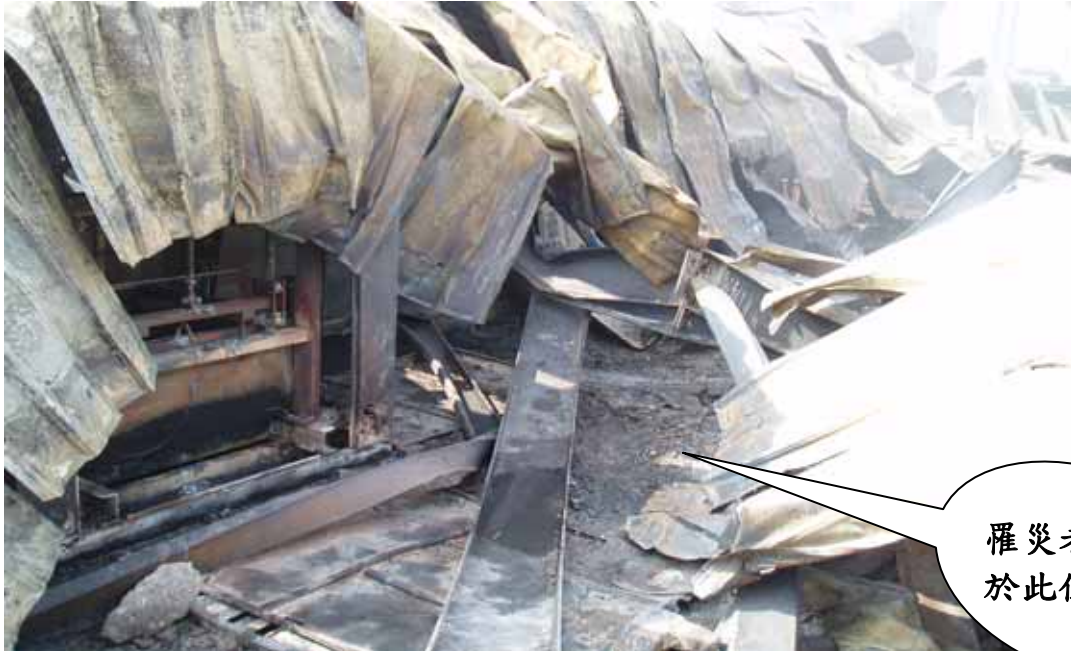
照片 1：肇災現場已燒毀，肇事之清洗機後側面之鐵板已遺落於地面，研判肇災時係報燃壓力推倒，其後廠房燃燒鋼樑再落下，罹災者劉員經發現陳屍於此位置
