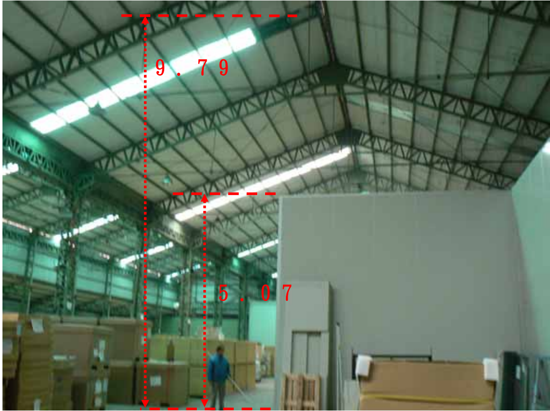
相片 2：罹災者墜落處 (單位：公尺)
