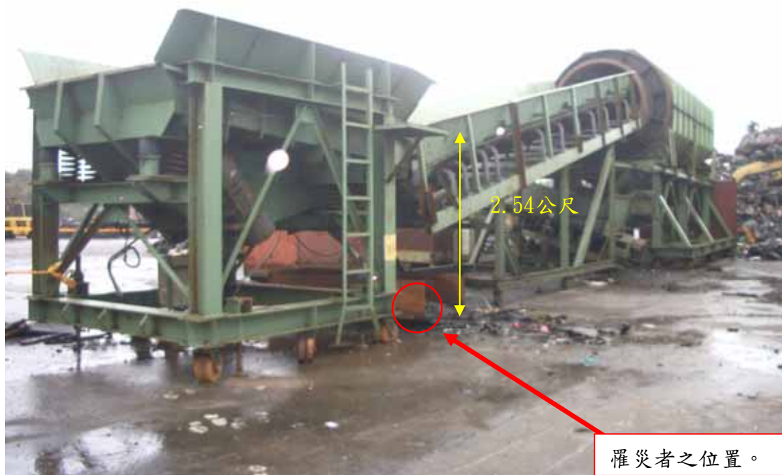
照片 2：罹災者爬上振動篩選機之爬梯，並站立於 2.54 公尺高之平台踏板上察看震動篩選機內之汽車玻璃廢料之篩選情形，不慎自平台上墜落至地面之位置
