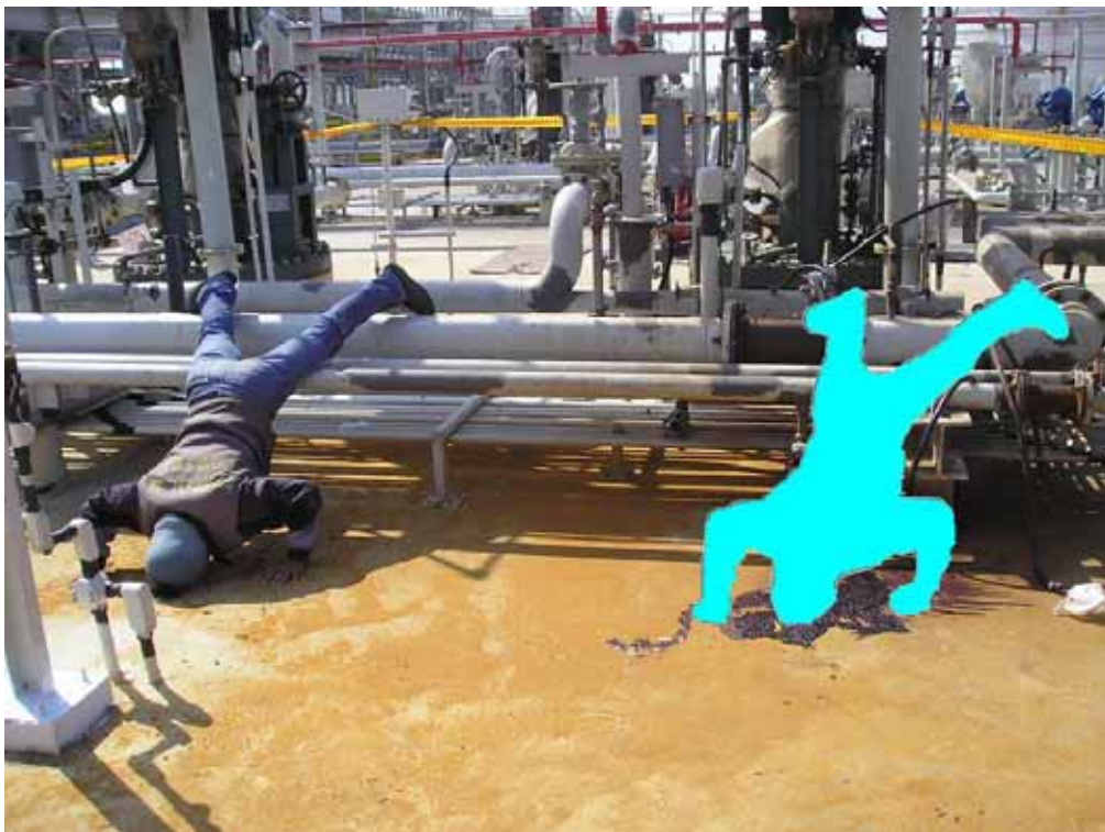
照片 2：罹災者遭衝吹至衝吹口對面管路（地面係罹災者血漬），罹災者遭高壓空氣衝吹至距衝吹口約 4.5 公尺對面管路處，頭朝北、雙腳朝南掛在管路上、上半身趴在地面上，臉部朝下。（阿○於災害發生處旁模擬罹災者罹災時姿勢。）
