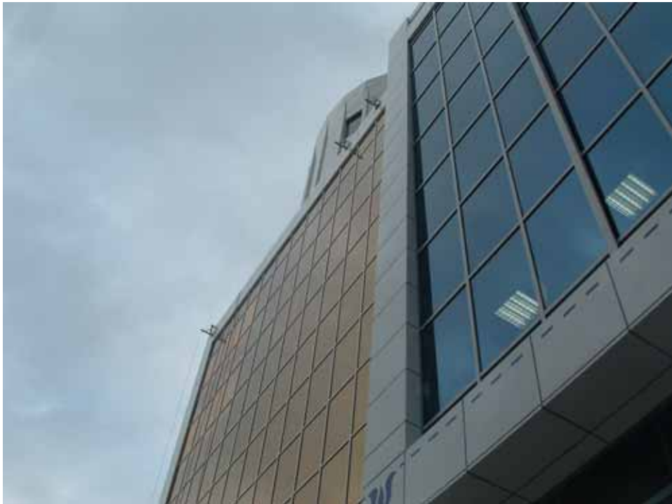
照片 1：大樓六樓頂女兒牆上架設吊籠支架
