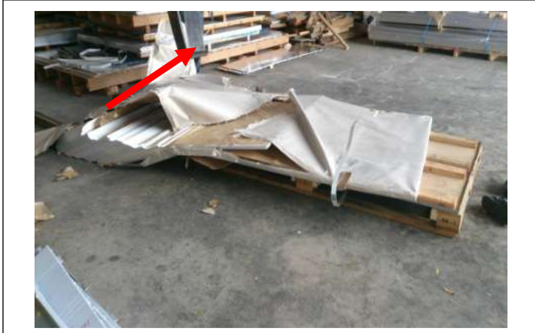
說 明 鋁板及棧板滑落地面之情形：箭頭所指處為吊具。
