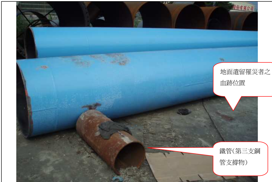
說明二 照片 2：肇災後第二支鋼管已倒塌至地面，滾落至撞及第三支鋼管下之支撐物(鐵管)。附近遺有罹災者之血跡
