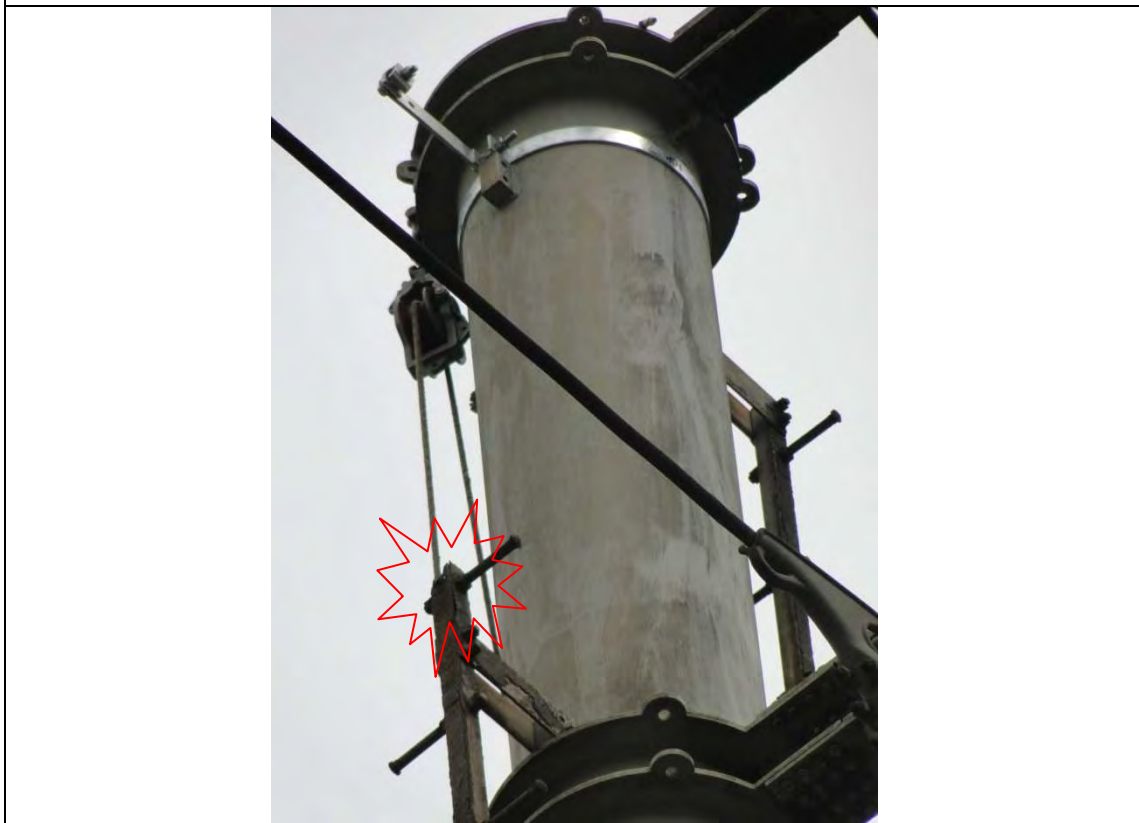
罹災者墜落處及已銹蝕斷裂之方鋼爬梯(最上一節)
