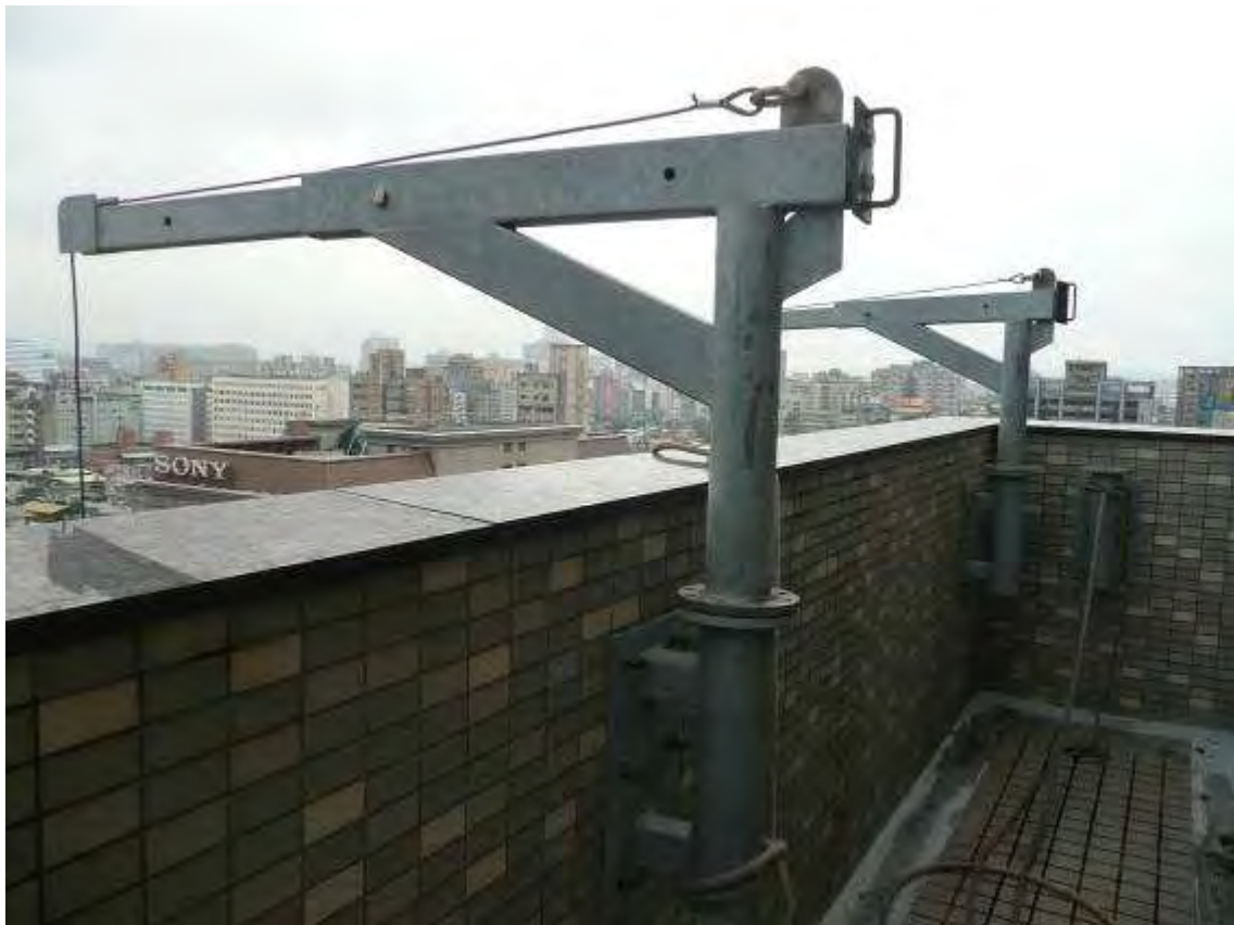
已完成清洗吊籠安裝架設位置
