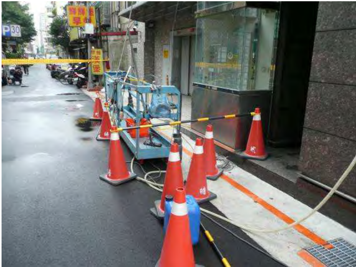
使用吊籠從事大樓外牆清洗作業（墜落於此巷中）
