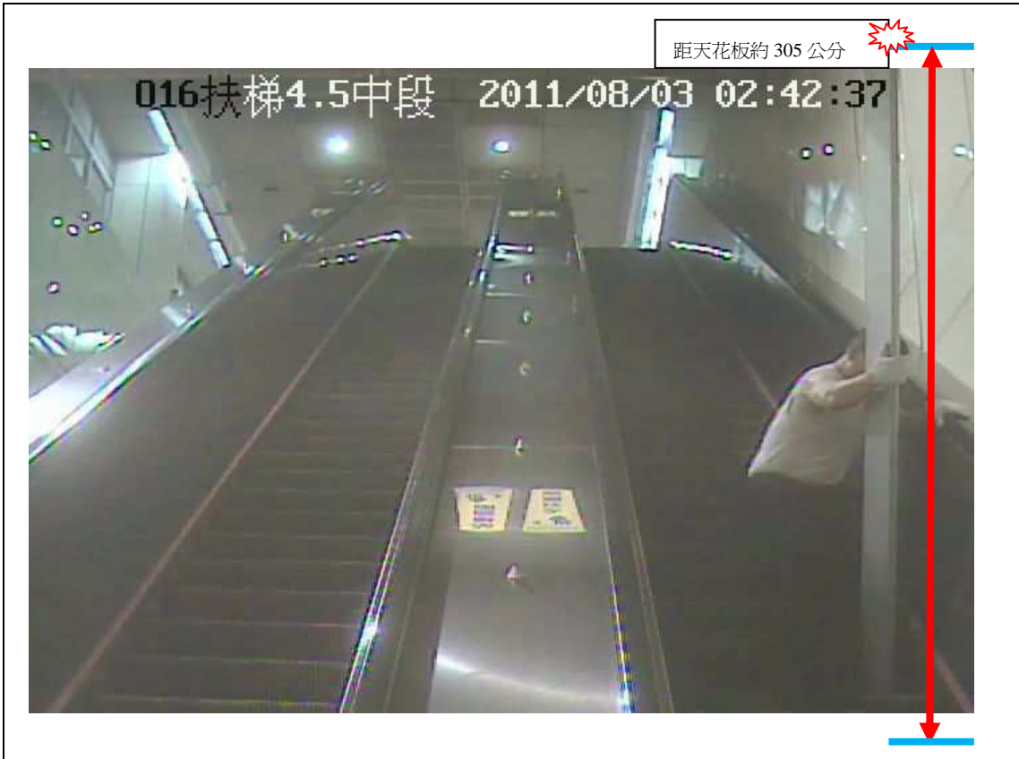
防洪板截取監視器畫面電扶梯遭防洪擋板頂住之情形
