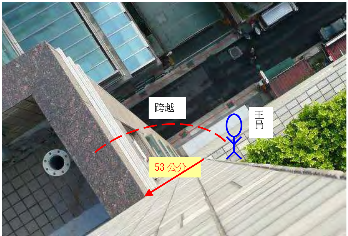
跨越橫隔 53 公分牆面發生墜落
