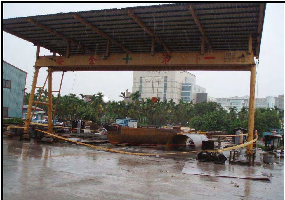
說明 照片 1：肇災鋼板係使用橋式起重機，吊升荷重 10.1 公噸固定式起重機從事吊掛作業。
