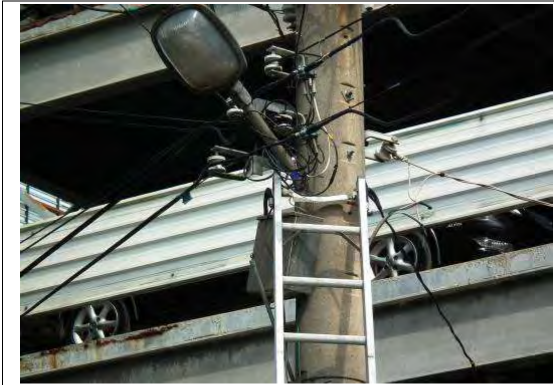
圖 2. 當時鋁梯與水銀燈電箱接觸
