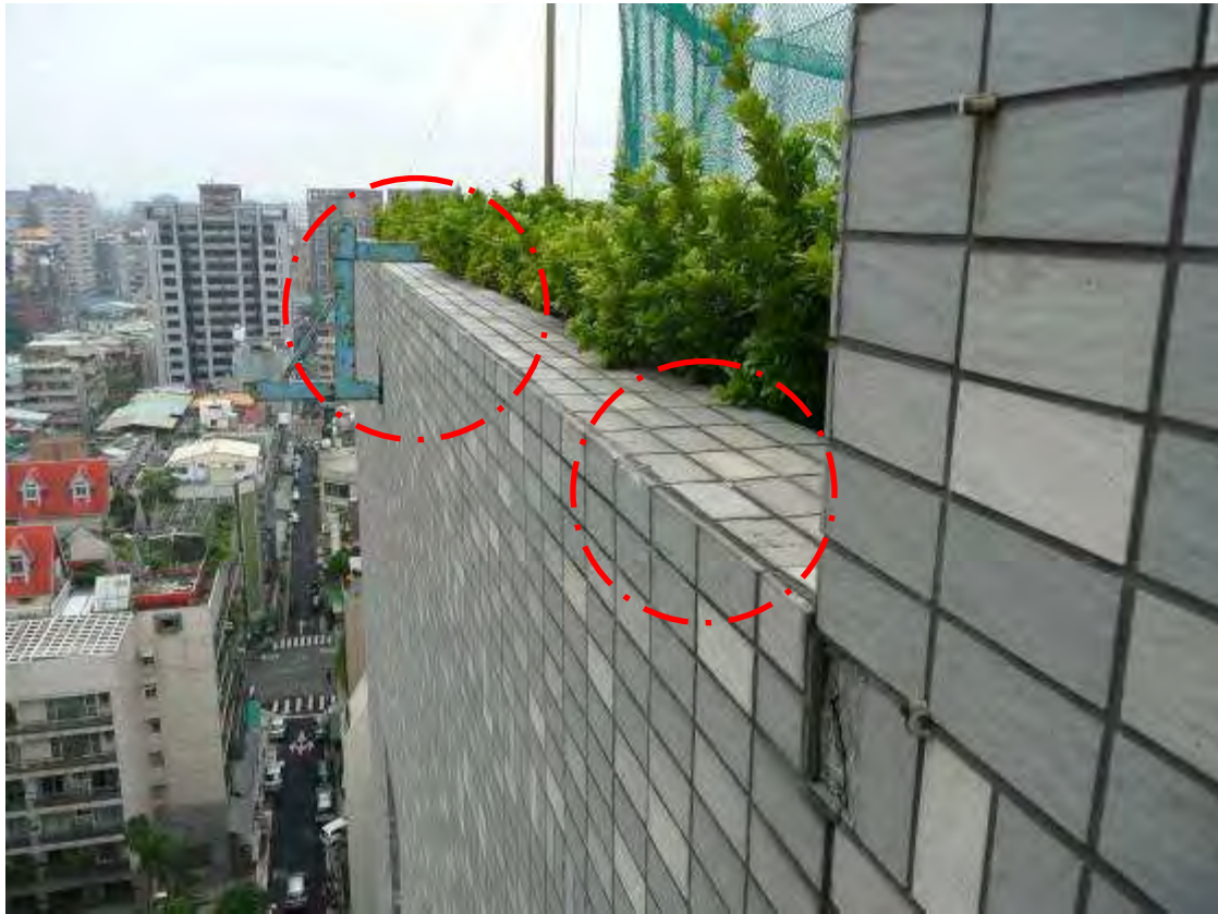
吊籠移機安裝架設F型支架位置（圈處）
