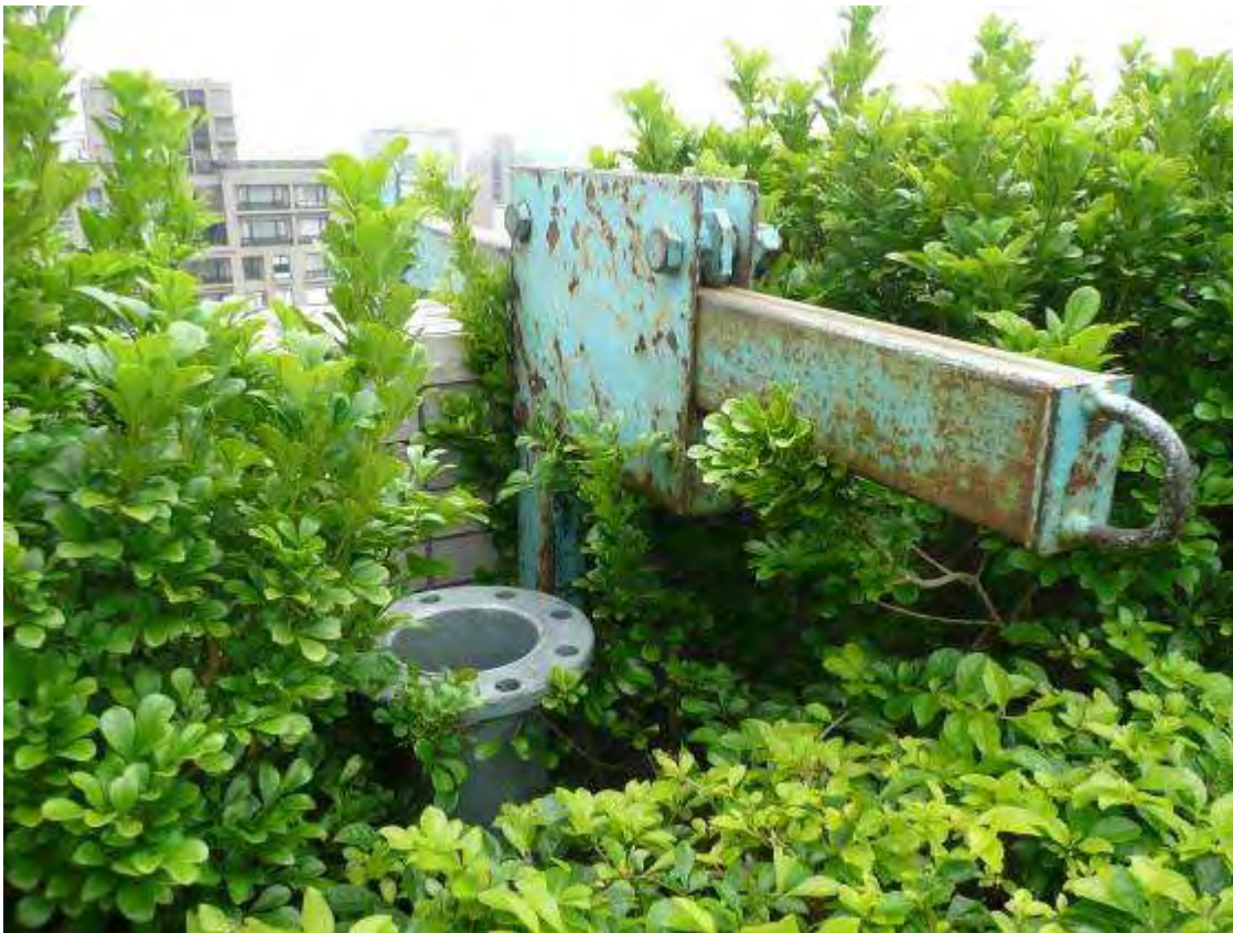
吊籠移機安裝架設F型支架位置（已架設好1支，另1支尚未架設完成）
