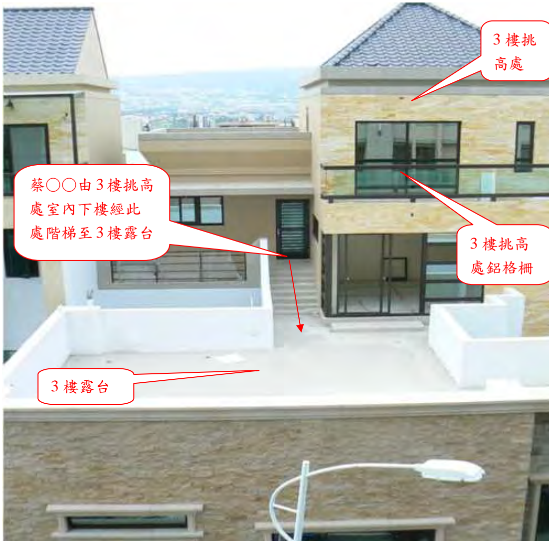
附照 1、災害發生在○○縣○○市○○三路○○號侯○○自宅
