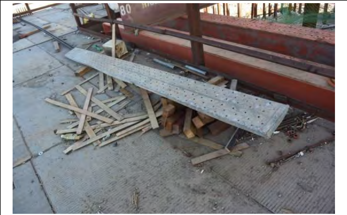
說明二 罹災者墜落點附近地面仍留有當時掉落之踏板，尺寸為長 400cm*寬 25cm*厚度 4.5mm。
