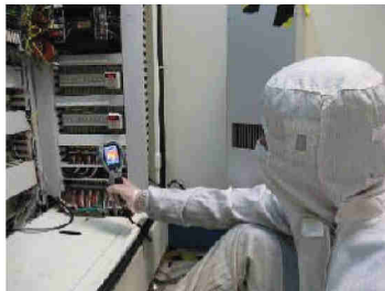
人員進行設備機台紅外線熱影像測試
