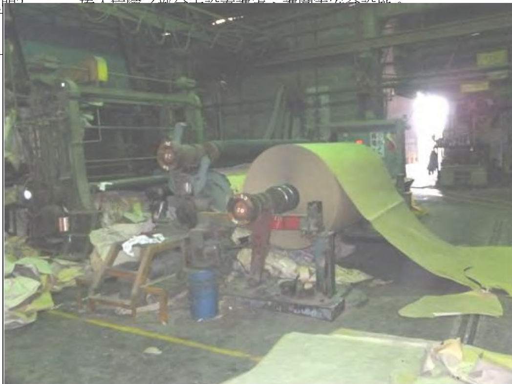
照片3 操作者伸手可及之處無緊急制動裝置。
