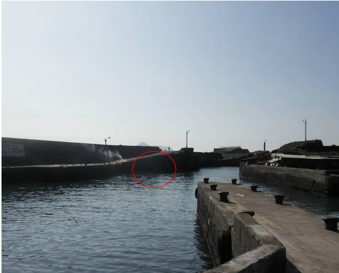
災害發生之現場，災害發生現場於大溪漁港港口，漁船正航行進港(紅圈處)
