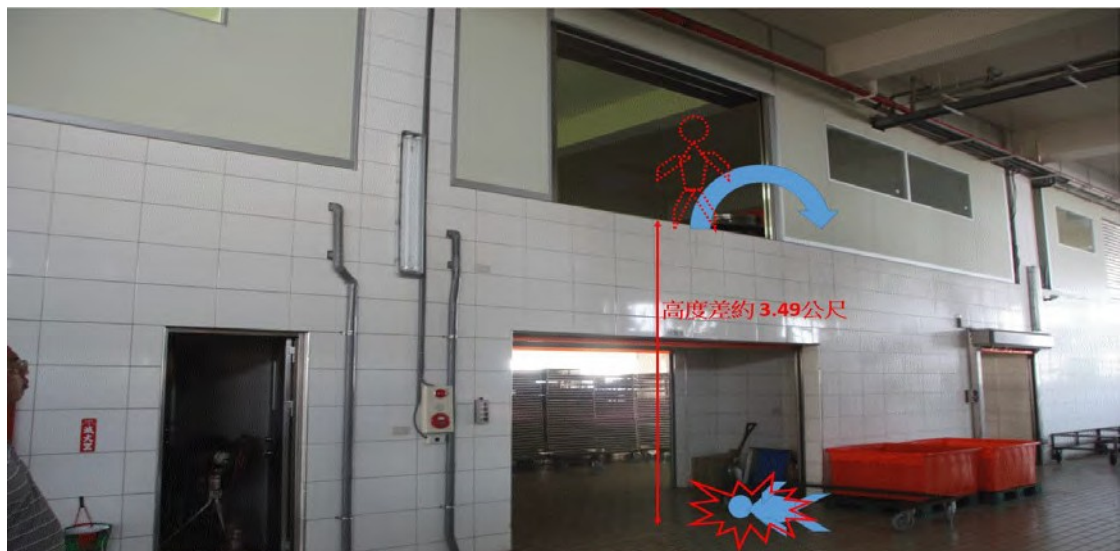
照片 2 罹災者薛郭○○自高度差約 3.49 公尺處墜落至 3 樓樓版(示意圖)。
