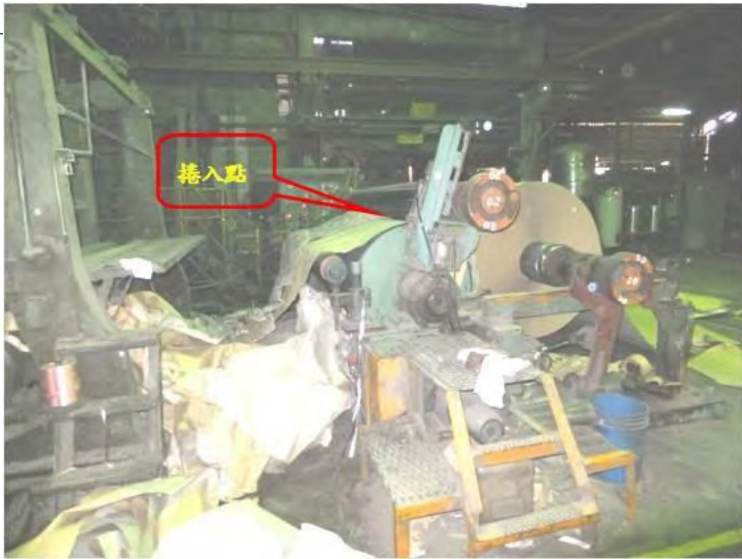
說明2 捲入危險之部分未設置護罩、護圍等安全設施。
