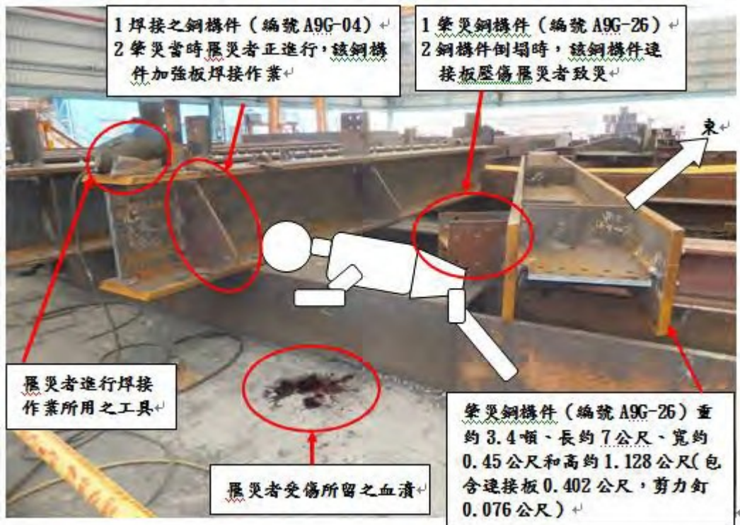
照片 2 罹災者林○○遭肇災鋼構件倒塌壓傷致死相關位置情形(示意圖)。
