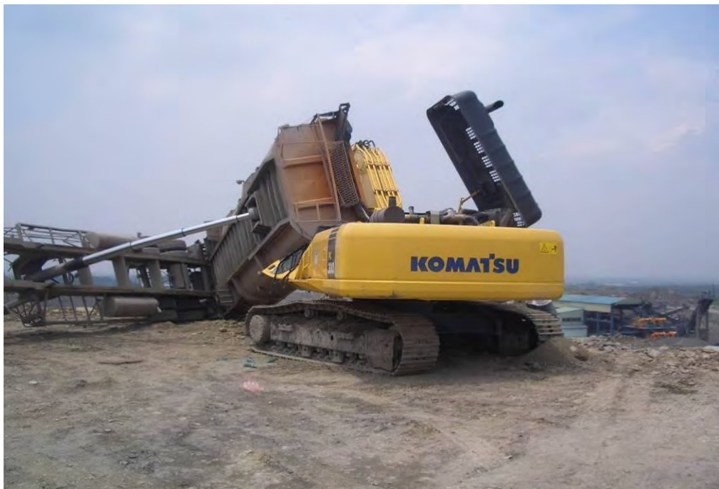
說明 照片二：災害發生當時曳引車與挖土機停放之相關位置(事故發生當時之照片)-由高樹派出所提供。
