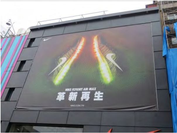
廣告布幕外框修繕作業。
