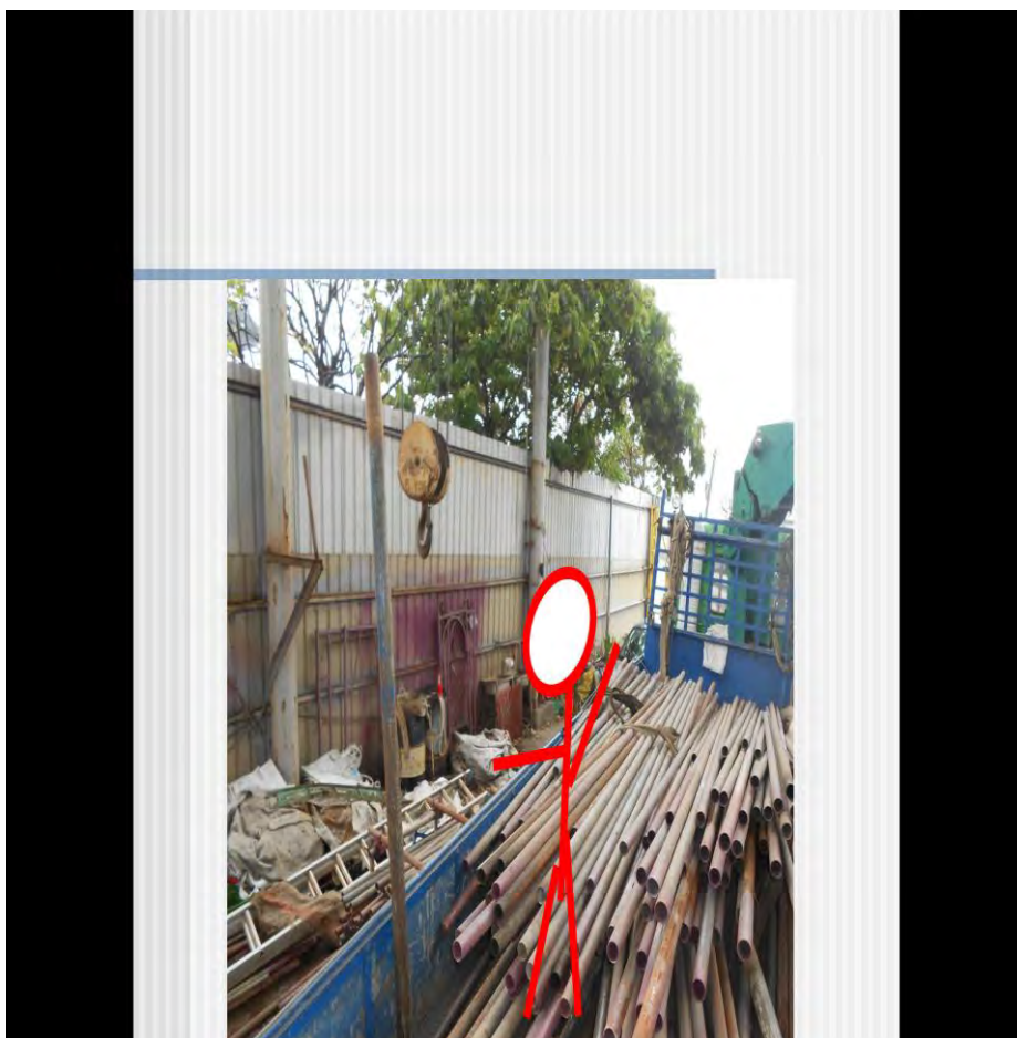
照片 1 罹災者模擬站立位置，遭吊掛施工架飛落擊砸（示意圖）。
