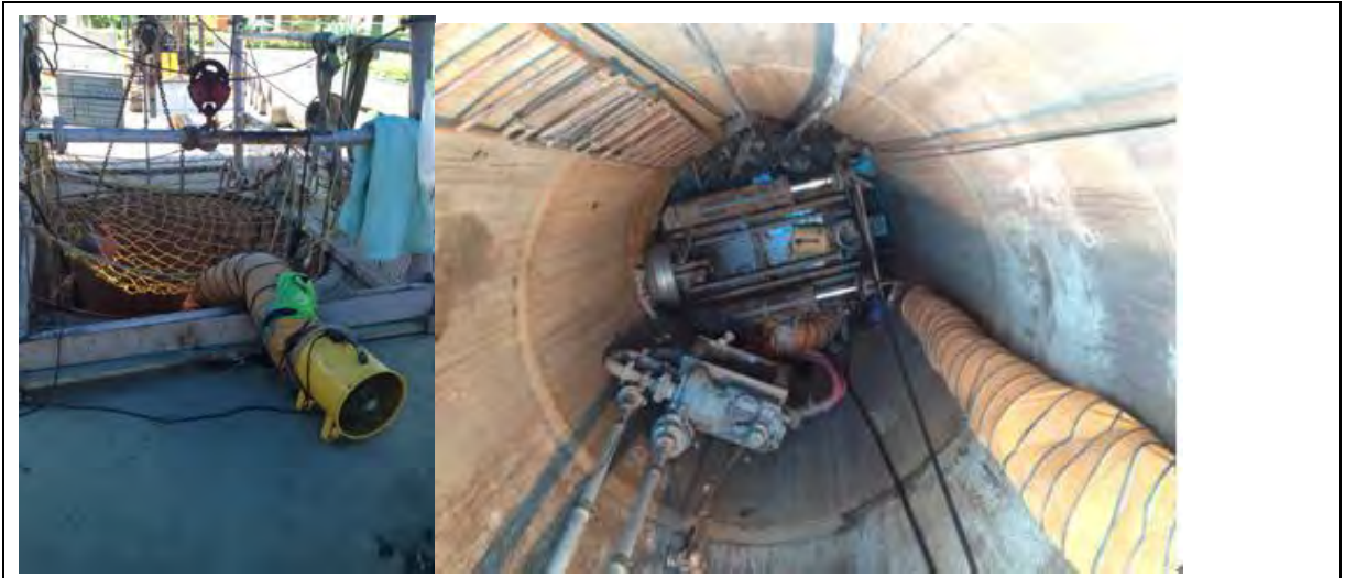
說明一：本工○○路與○○路交叉處 AB12 工作井
