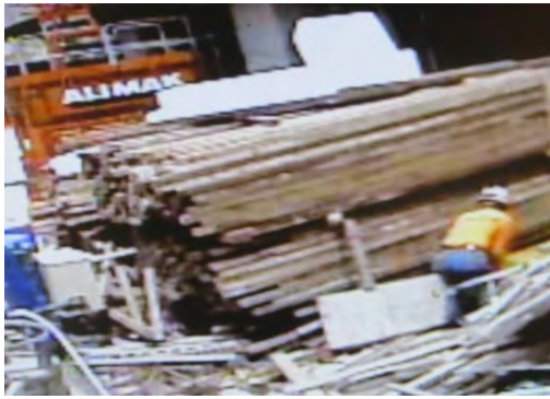
勞工郭○○於工地1樓模板材料堆置區清理通道並傳遞置於地面的板材。
