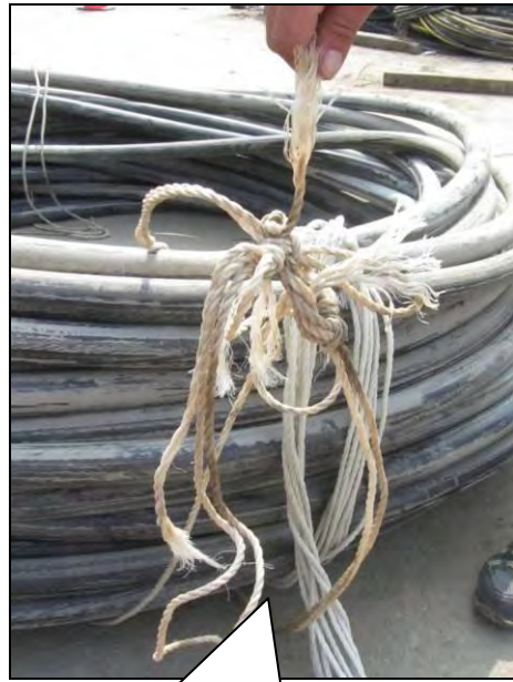
吊運電纜線之尼龍線斷裂情形。
