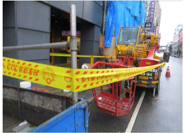
使用移動式起重機搭乘設備搭載人員作業。
