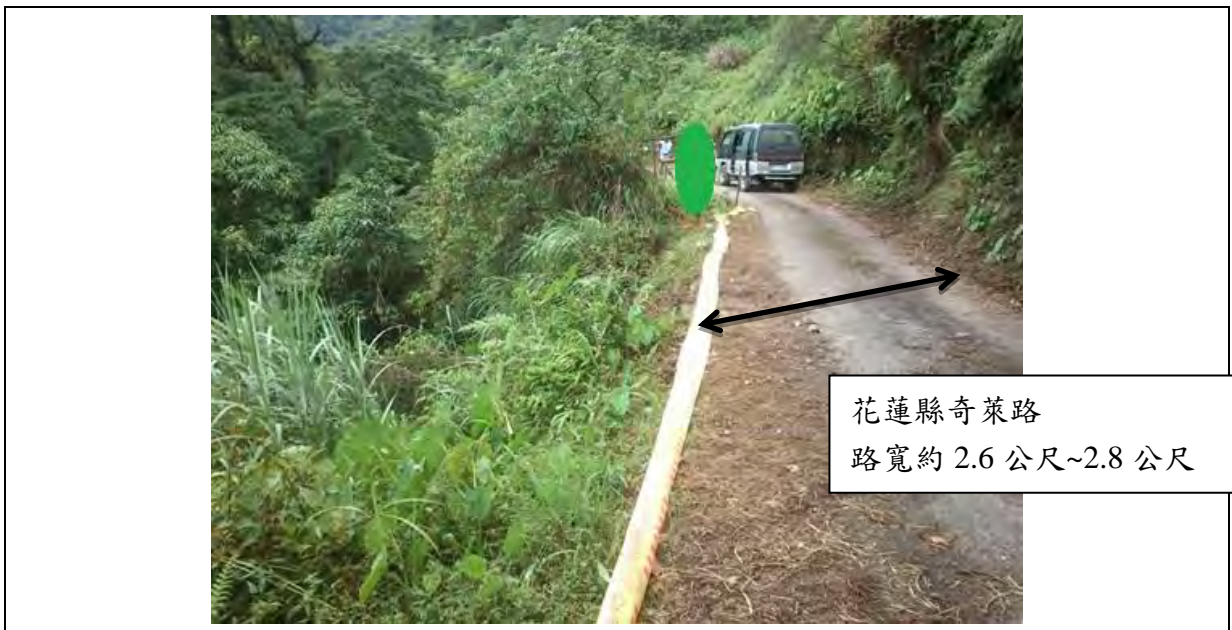
說明照片1 事故車輛衝出路面位置(奇萊路約3K處)路寬約2.6~2.8公尺。
