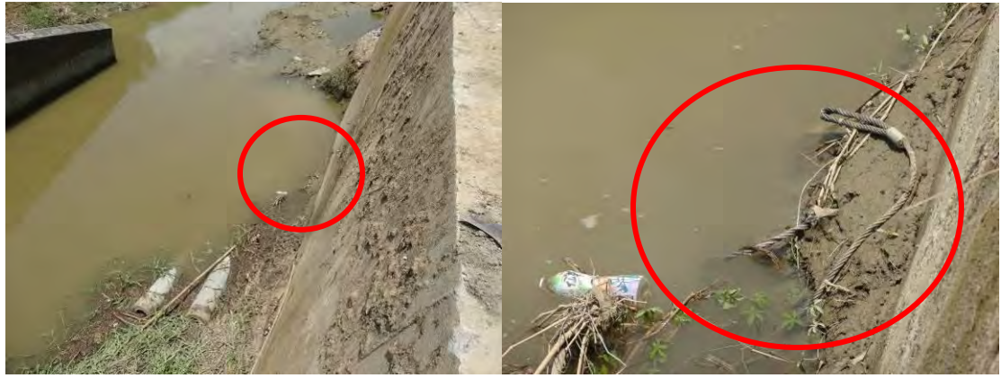
照片4 說明：在滑落於馬稠後大排中的2根基樁，鋼索仍位於兩根基樁長向之中間位置。
