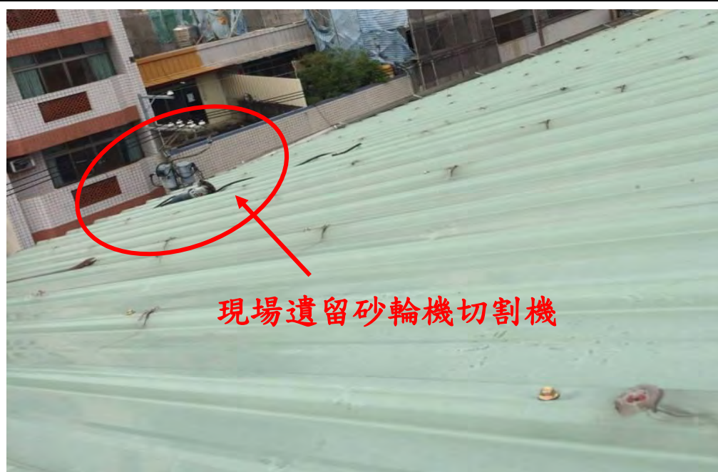
附照 2 依現場遺留砂輪切割機，研判災害發生時作業為切割維修孔
