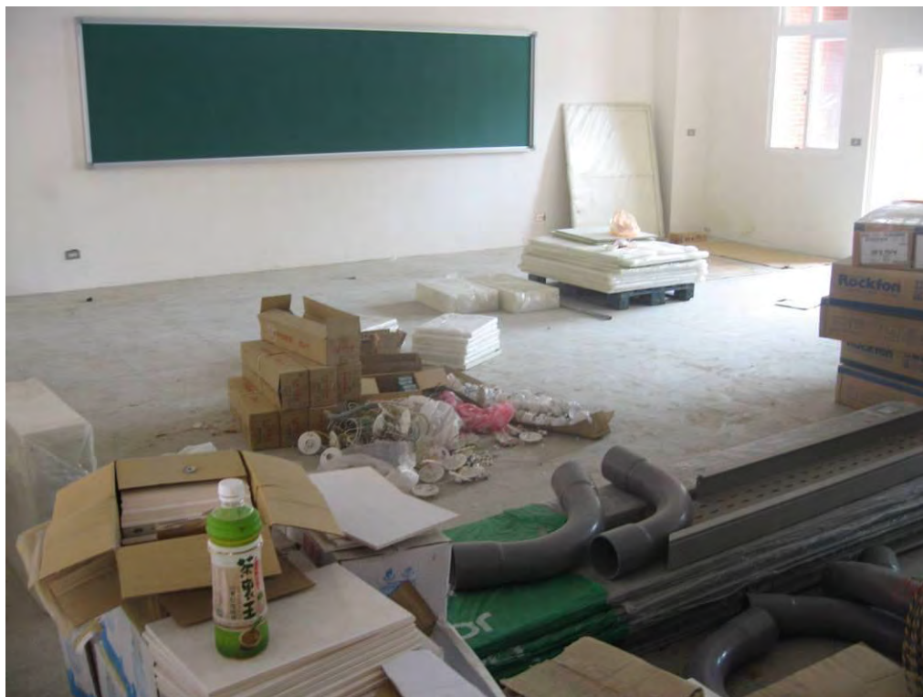
罹災者倒臥處（黑板左前方通路地板上）。
