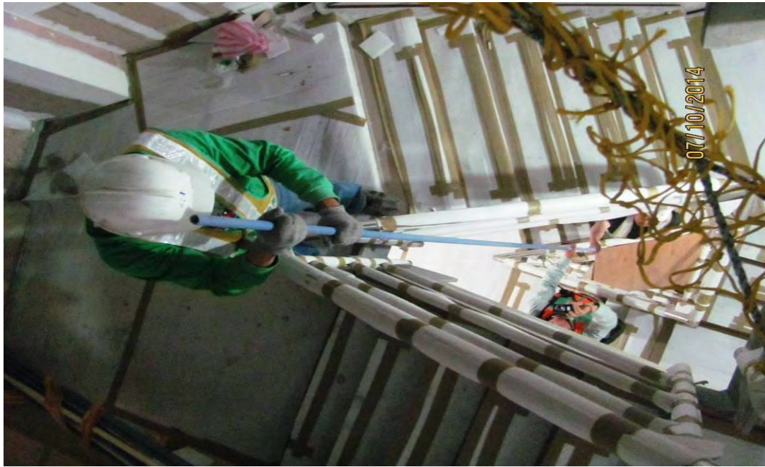
模擬當時 16 樓以人力傳送管料之狀況
