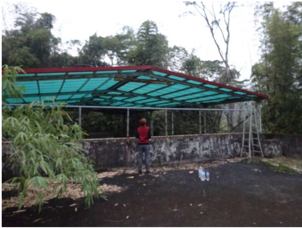
說明 3 「屋頂採光罩更新工程」屋頂。
