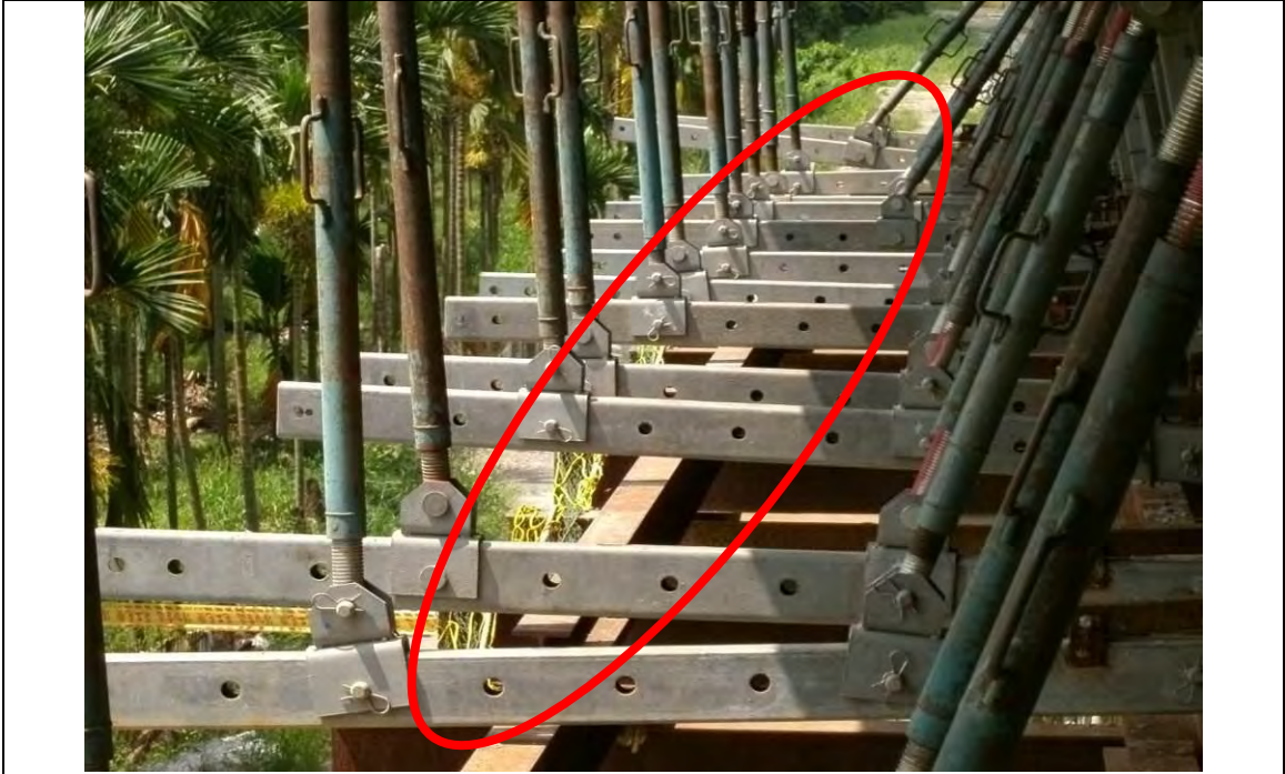
說明 照片六：事故發生當時系統模板之對拉螺桿均已拆除，且其支撐已經解壓，導致系統模板已和箱型樑之混凝土及底座下方之 H 型鋼脫離而產生間隙，呈不穩定狀態。
