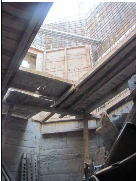
說明 15 樓之樓梯
