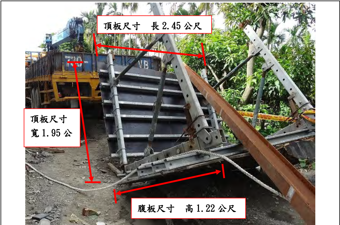
說明 照片五：系統模板之頂板尺寸為長 2.45 公尺、寬 1.95 公尺，腹板尺寸為長 2.45 公尺高 1.22 公尺，模板厚度均為 2 公分（重量約 800 公斤）。
