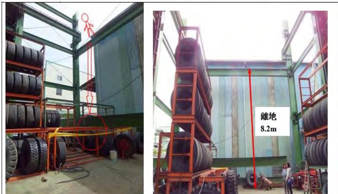
照片說明 2 罹災者 作業位置距離地面 8.2 公尺，現場未設置護欄或安全網等防護設備。
