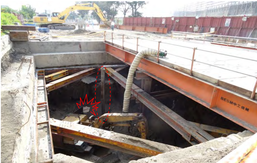
照片5： 災害發生後照片，內燃機側版爆開，抽水管正對內燃機側版爆開處明顯燒焦
