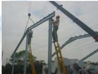
圖二、以吊車吊掛基礎柱及大樑組合
