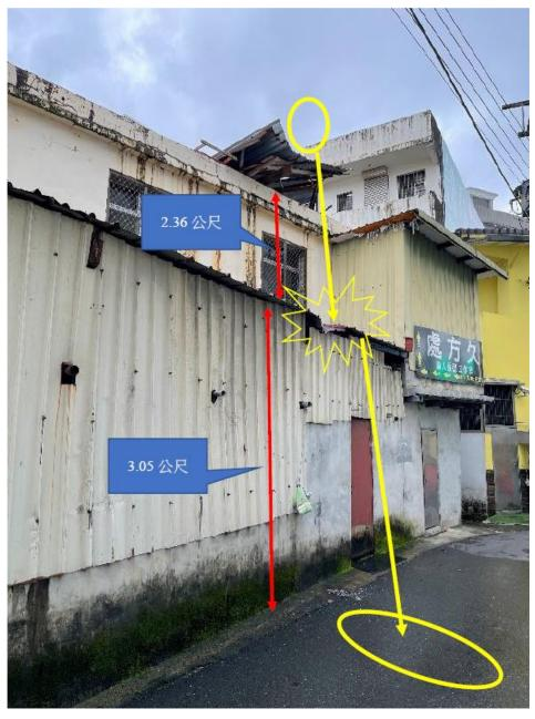
罹災者從距地面高度 7.31 公尺之鐵皮屋頂墜落,先撞擊高度 3.05 公尺 1 樓外推 鐵皮屋頂後,頭部撞擊地面致死。
