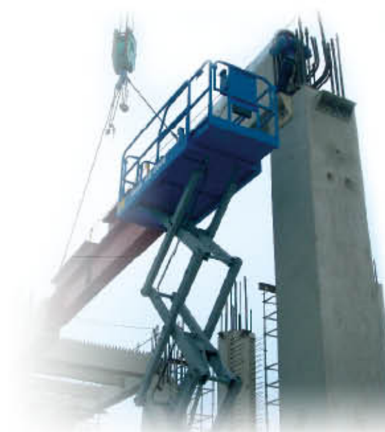
獨立柱大樑吊裝，採高空作業車進行作業
