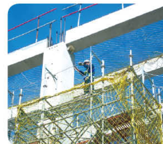
預鑄樑吊裝前即於地面好安裝安全欄杆，並設置上下設備，確保施工安全
