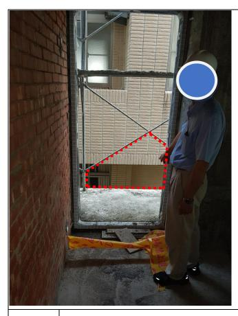
說明 呂 00 從 2 樓施工架交叉拉桿下方墜落
