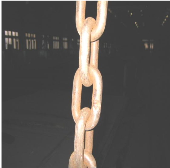
吊鏈不良例--焊補
