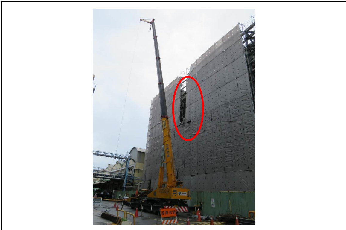
說明 照片一：災害發生於台南市○○區「永康○○大樓暨綜合大型會議廳新建工程」之南側外部施工架處。
