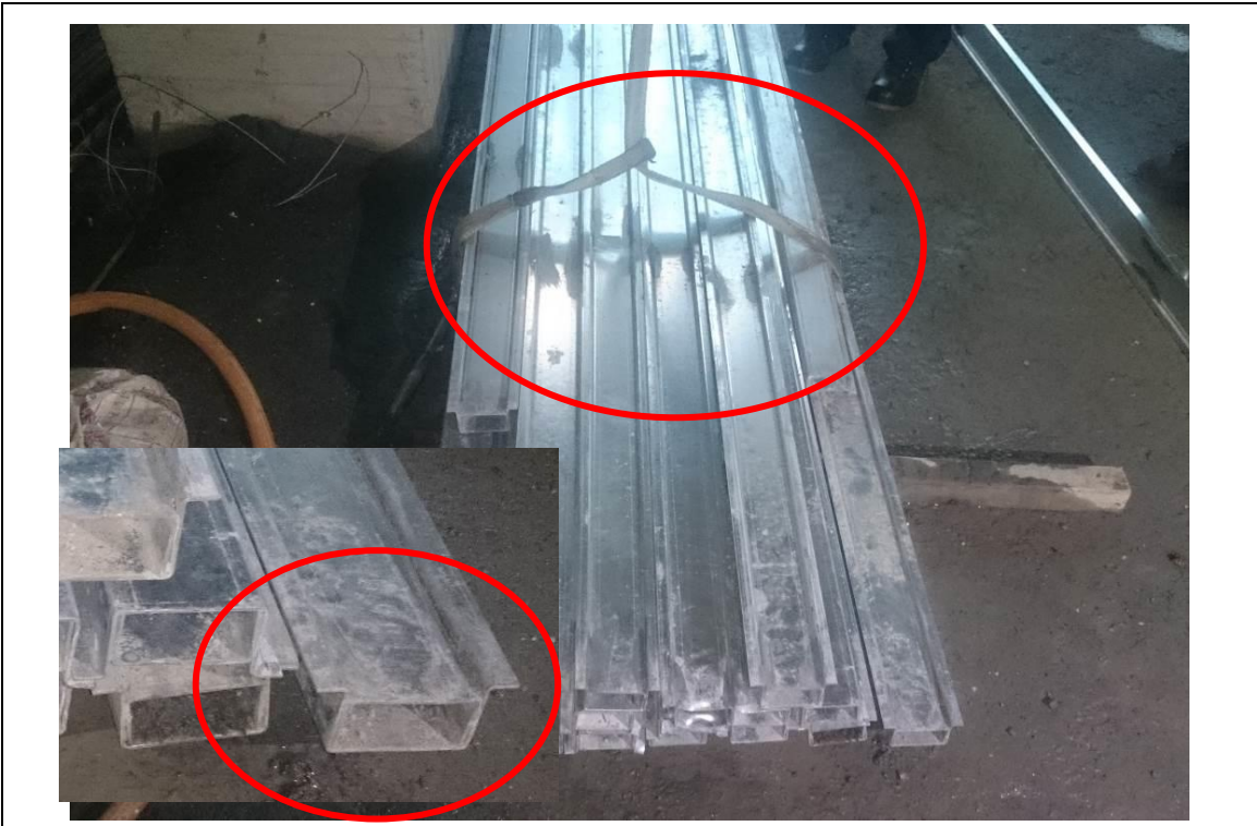
說明 照片四：當次吊運之保水骨架其吊掛係以纖維帶一頭穿過另一頭之套環方式網紮保水骨架，採2點吊掛方式吊運，惟保水骨架邊緣銳利而未加保護。(由○○營造有限公司模擬及提供)
