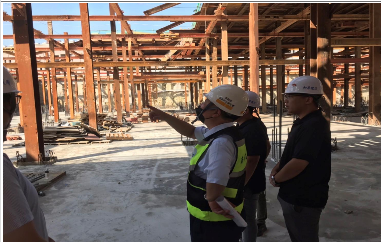
本署中區職業安全衛生中心李文進主任率檢查員前往中部營造工地實施區域巡檢。
