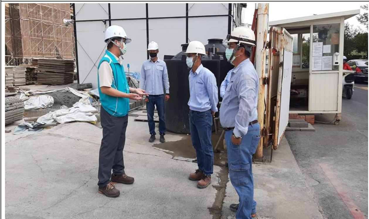
高雄市政府勞工局勞動檢查處郭清吉處長率檢查員前往高雄市營造工地實施區域巡檢。
