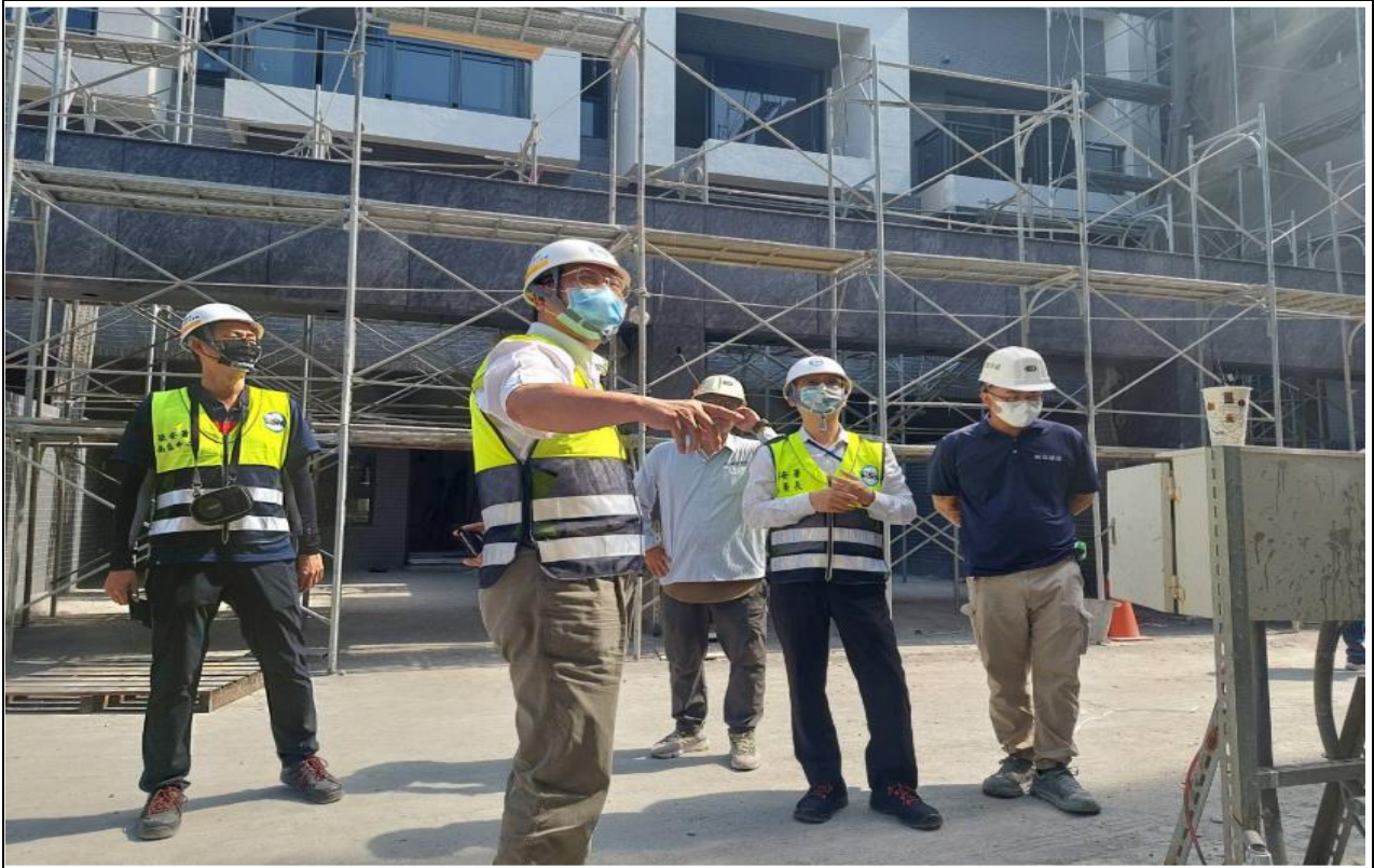
本署李柏昌副署長率檢查員前往南部營造工地實施區域巡檢。
