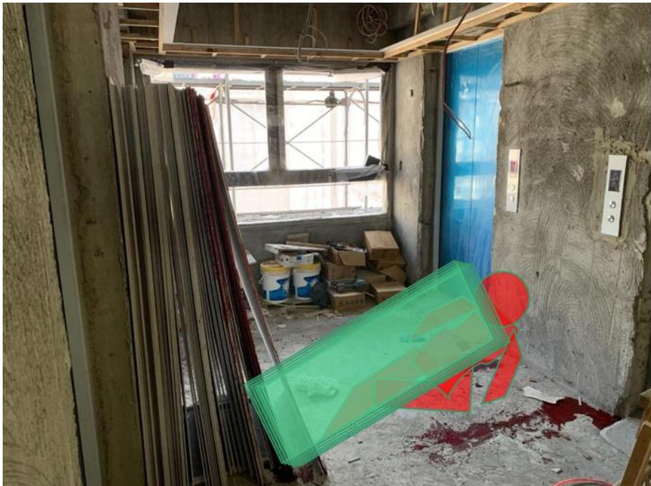
罹災者為排除安裝作業障礙，將部分矽酸鈣板撥動豎直後扶住，豎直的矽酸鈣板擠壓剩餘的矽酸鈣板後往扶住方向傾倒，致遭倒塌之矽酸鈣板撞擊頭部後倒地，造成頭部外傷及嚴重腦挫傷，經送醫急救仍因傷重不治死亡。
