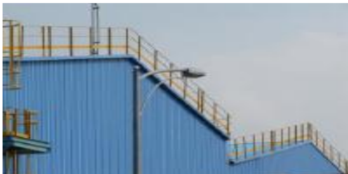
【屋頂開放邊緣設置永久性護欄】
