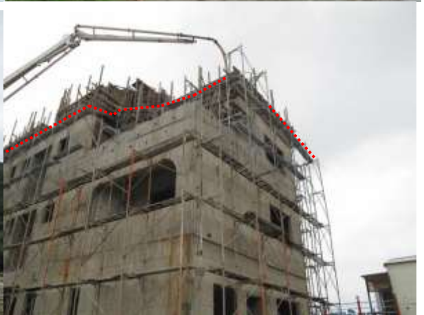
說明 照片 3. 外牆施工架由 1F 地面往上搭設至第 6 層，其高度約至 3F 頂層樓板(距地面高約 10.2 公尺)，而 3F 頂層樓板上高 1.20 公尺之女兒牆開口未設護欄
