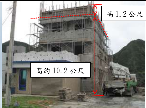
說明 照片 2. 陳○○當時站立於 3F 頂層西南側女兒牆模板上，女兒牆模板高 1.20 公尺，牆厚 0.12 公尺(含模板時牆厚為 0.24 公尺)
