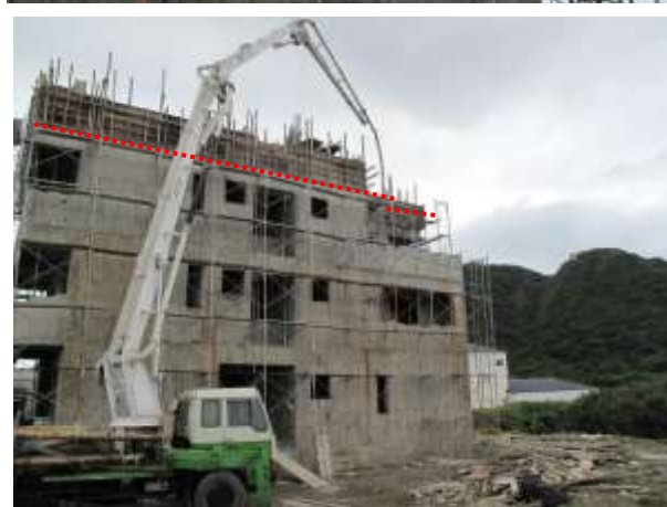
說明 照片 3. 外牆施工架由 1F 地面往上搭設至第 6 層，其高度約至 3F 頂層樓板(距地面高約 10.2 公尺)，而 3F 頂層樓板上高 1.20 公尺之女兒牆開口未設護欄
