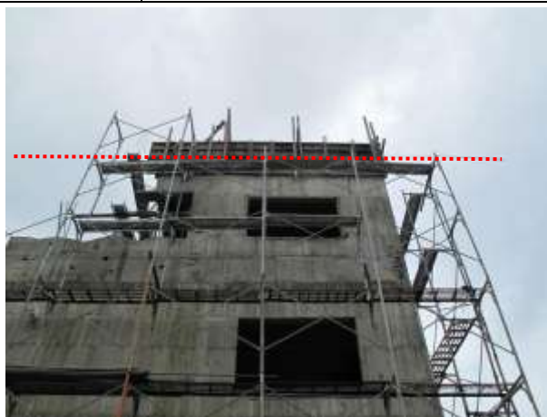
說明 照片 2. 陳○○當時站立於 3F 頂層西南側女兒牆模板上，女兒牆模板高 1.20 公尺，牆厚 0.12 公尺(含模板時牆厚為 0.24 公尺)
