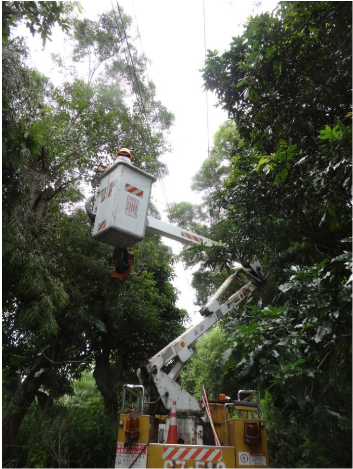
附照1 高壓電線距地高度794公分，中性線距地高度630公分，路燈線距地高度550公分。
