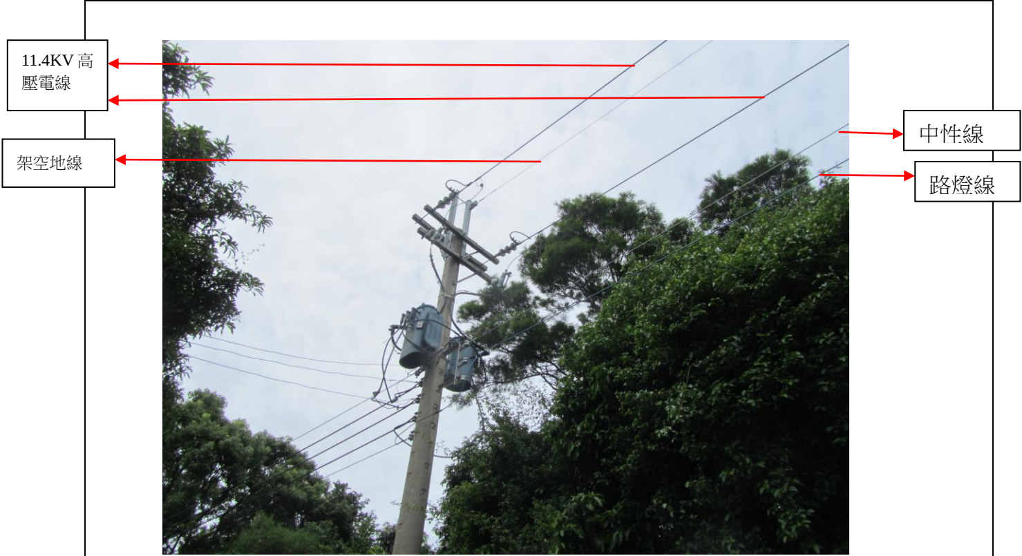
附照1 高壓電線距地高度794公分，中性線距地高度630公分，路燈線距地高度550公分。
