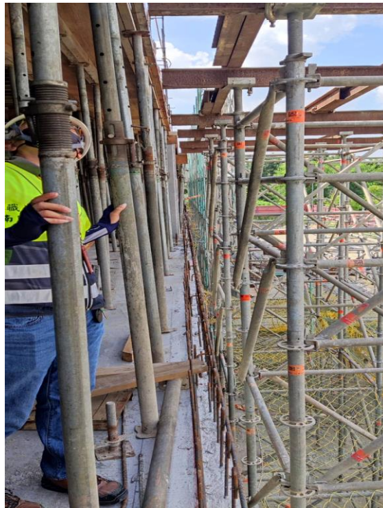
職安署南區職業安全衛生中心陳明財簡任技正會同南科檢查員前往臺南市某廠辦工程實施勞動檢查。
