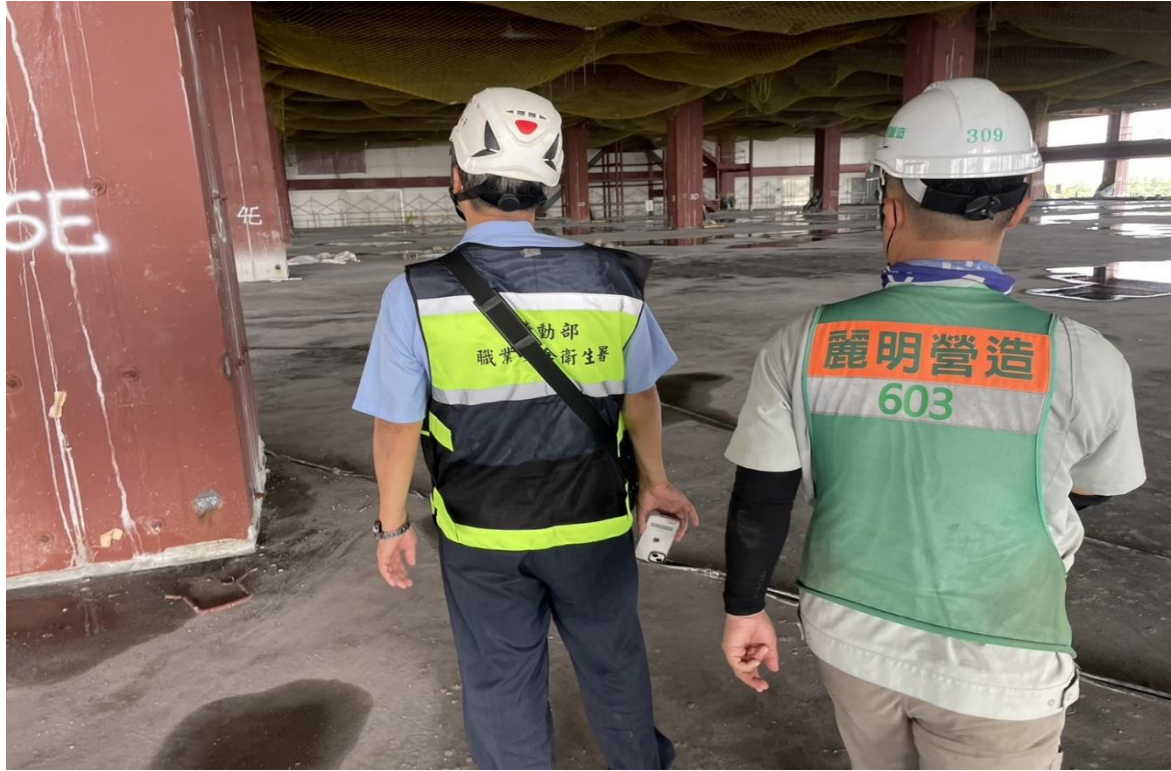
職安署中區職業安全衛生中心羅惠元簡任技正會同中科檢查員前往彰化縣某廠房工程實施勞動檢查。
