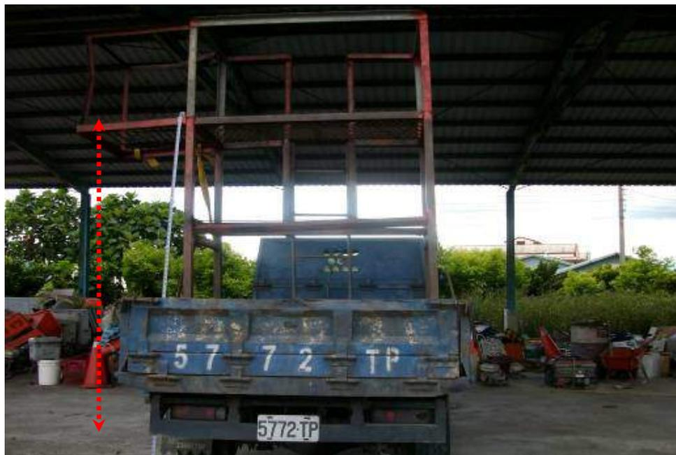
照片四：事發後請事業單位回復災害發生時施工架架設情形，其中施工架本體長寬各約 150 cm 及 90 cm、高約 230 cm，架旁另燒製一 50 cm×50 cm×50 cm 之鐵架，後車斗底部離地面約 80 cm，故腳踏板處離地面高度為  $230-50+80=260$  cm（虛線所示）。
