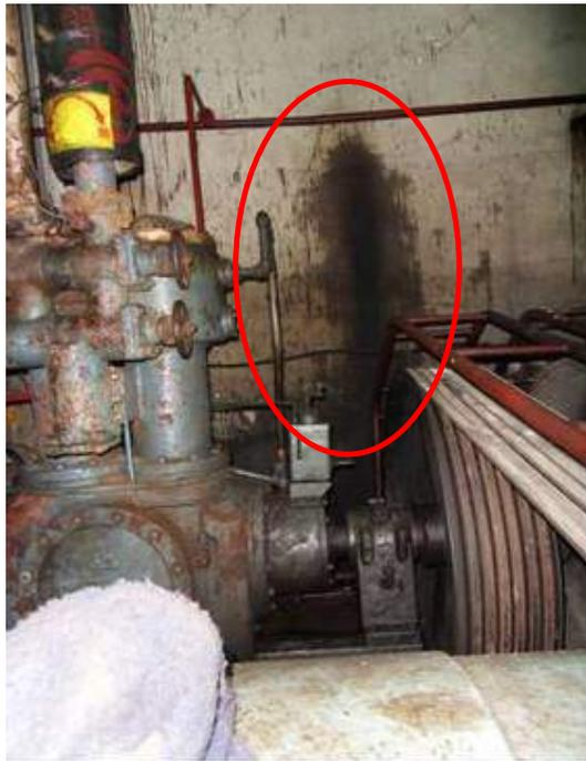
照片二 4號冷凍壓縮機機頭油封鬆弛，冷凍油噴濺
