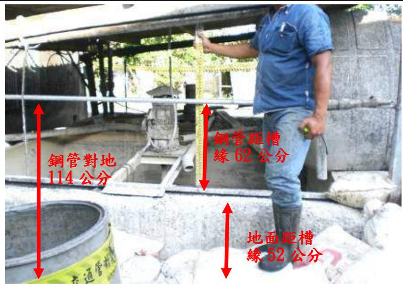
圖一 鋼管對地約 114 公分，鋼管距槽緣約 62 公分，地面距槽緣約 52 公分。
