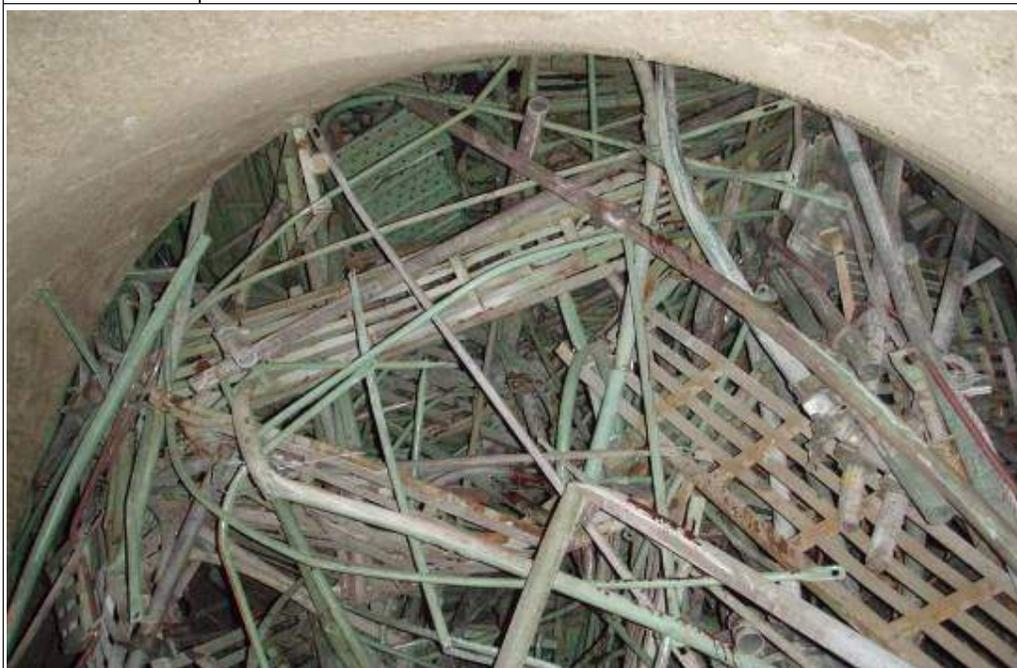
說明二 肇災後煙囪內部搭設施工架已倒塌於煙道底部。
