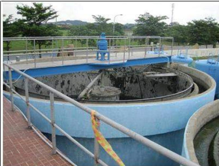
照片一 浮除池直徑 8 米、深度 3.5 米，集水溝為傾斜施工，故寬度為 30 至 60 公分寬，集水溝底部至 RC 結構體高度約為 65 公分高；至浮除池溢流口高度約 55 公分高。
