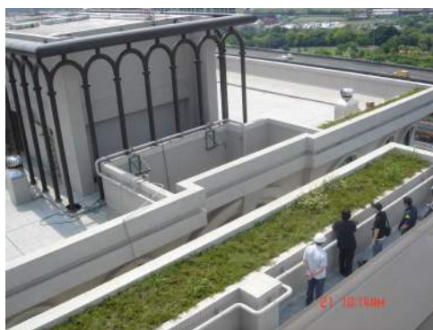
圖 1:自 A 棟 11 樓東側花台墜落(墜落高度為 37.1 公尺)
