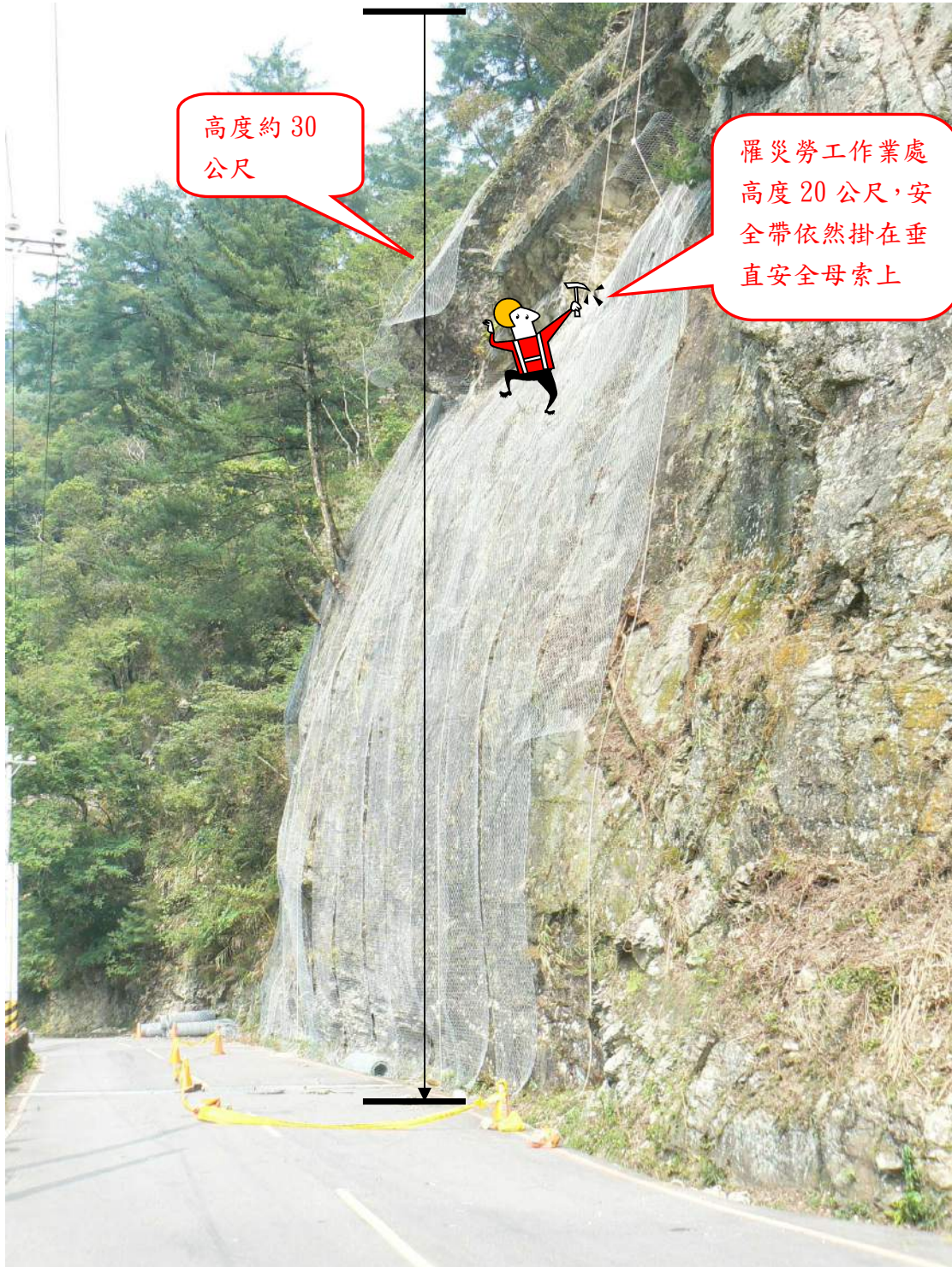
附照 1 ○○市○○區○○山林道 0k+200 處之施工現場
