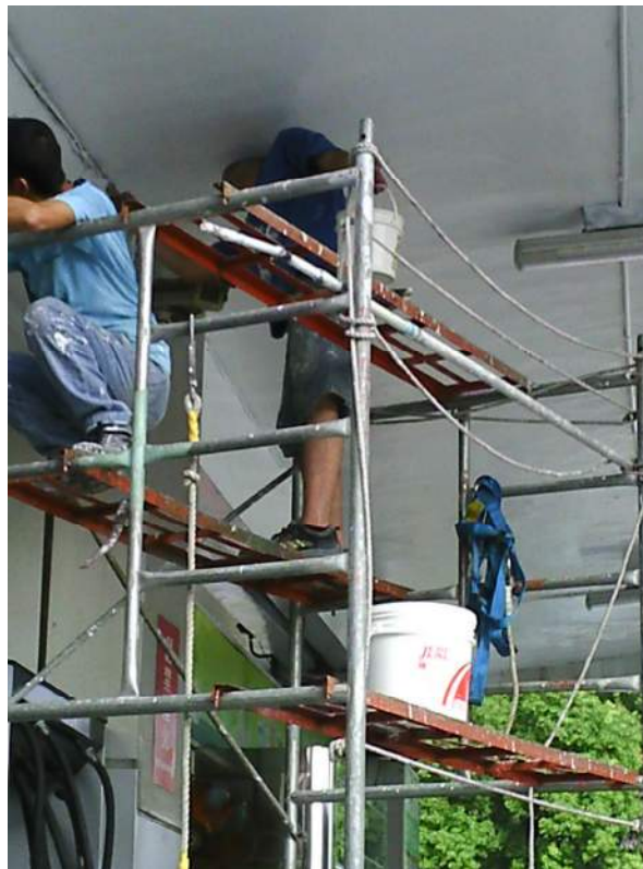
肇災當日施工情形(中油提供)
