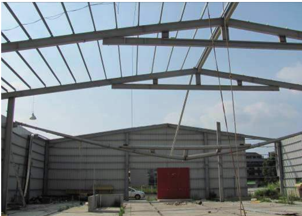
說明 災害現場立面照片
