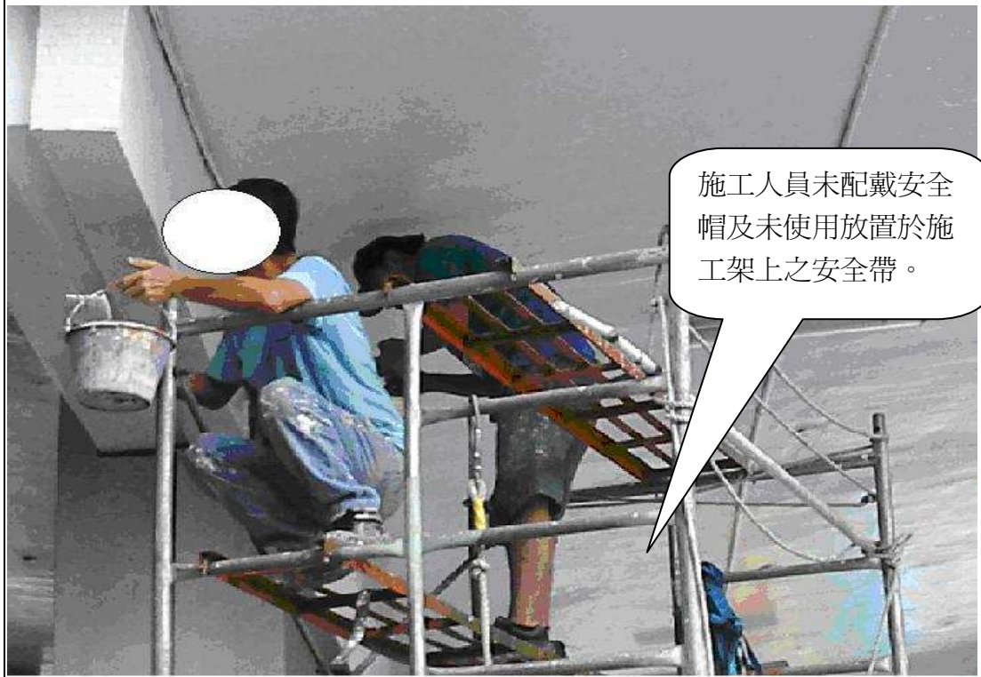
肇災當日施工情形(中油提供)
