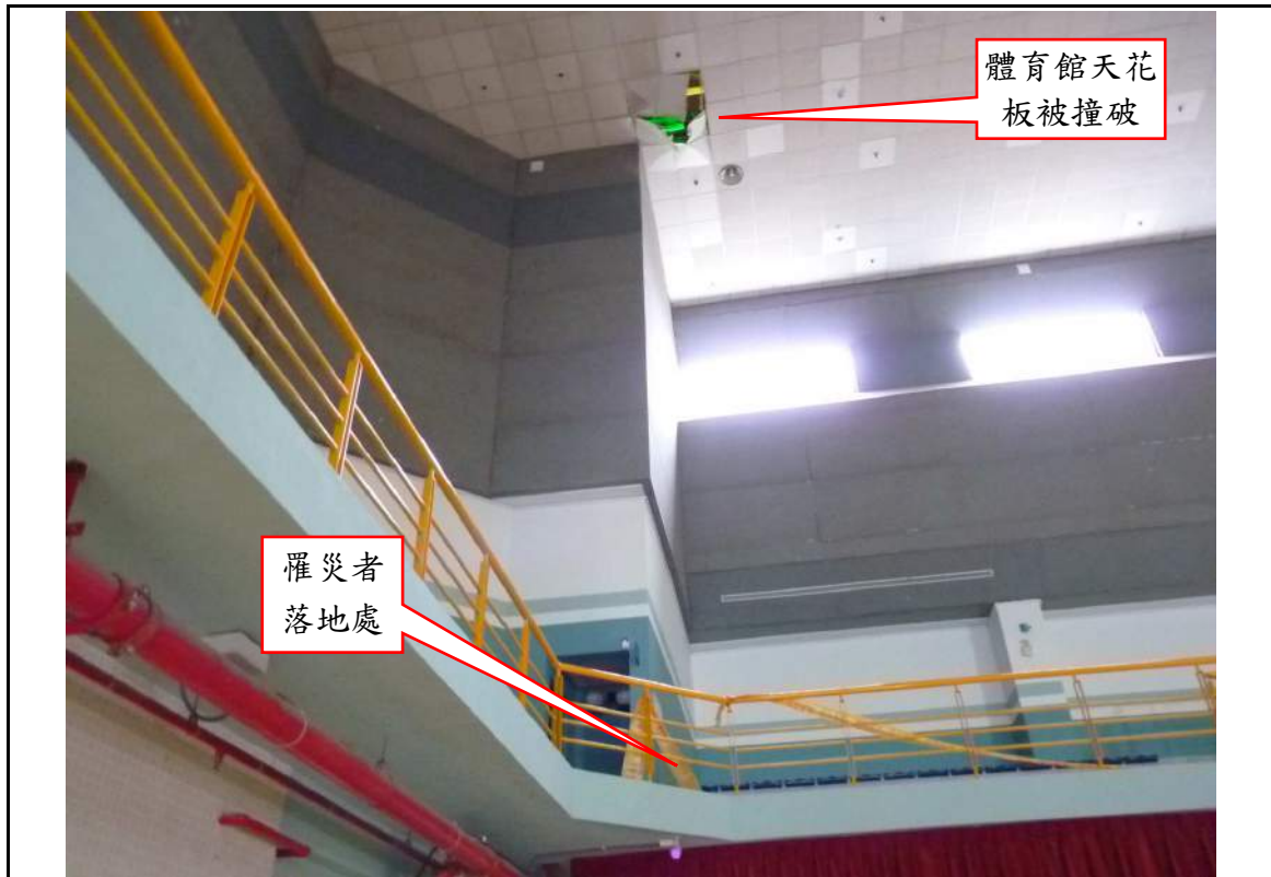
說明 附照 1，災害發生現場，可見體育館天花板被撞破，破洞處呈綠光物為體育館屋頂。
