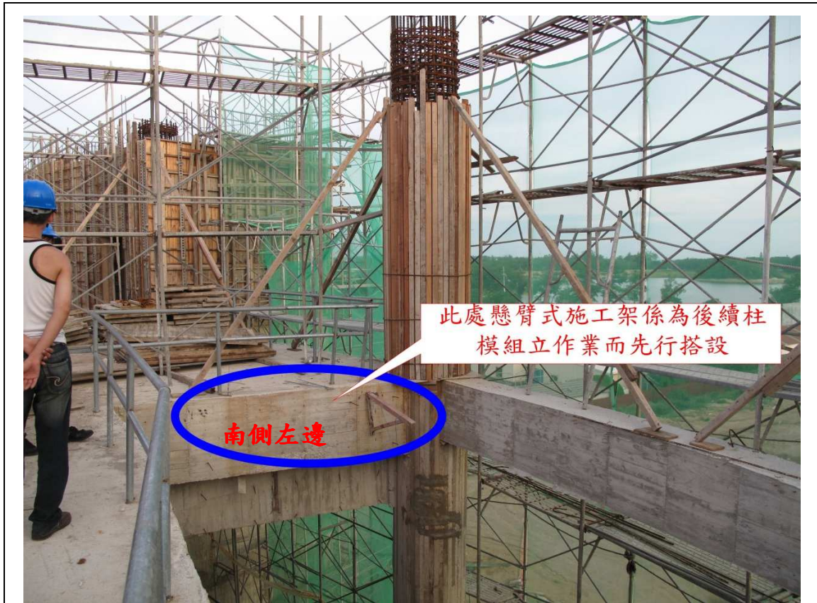
照片 1 | 罹災者李○○欲搭設A棟3樓南側樓板挑空處懸臂式施工架之基座(構件包含2支三角托架,3根鋼管及1塊木夾板)。
