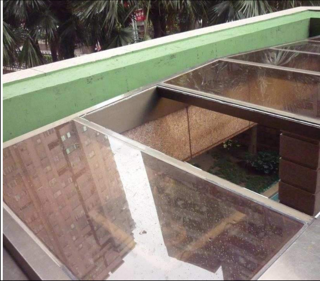
照片說明 1：玻璃雨遮之開口部分
