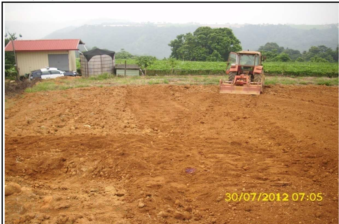
照片 災害現場
