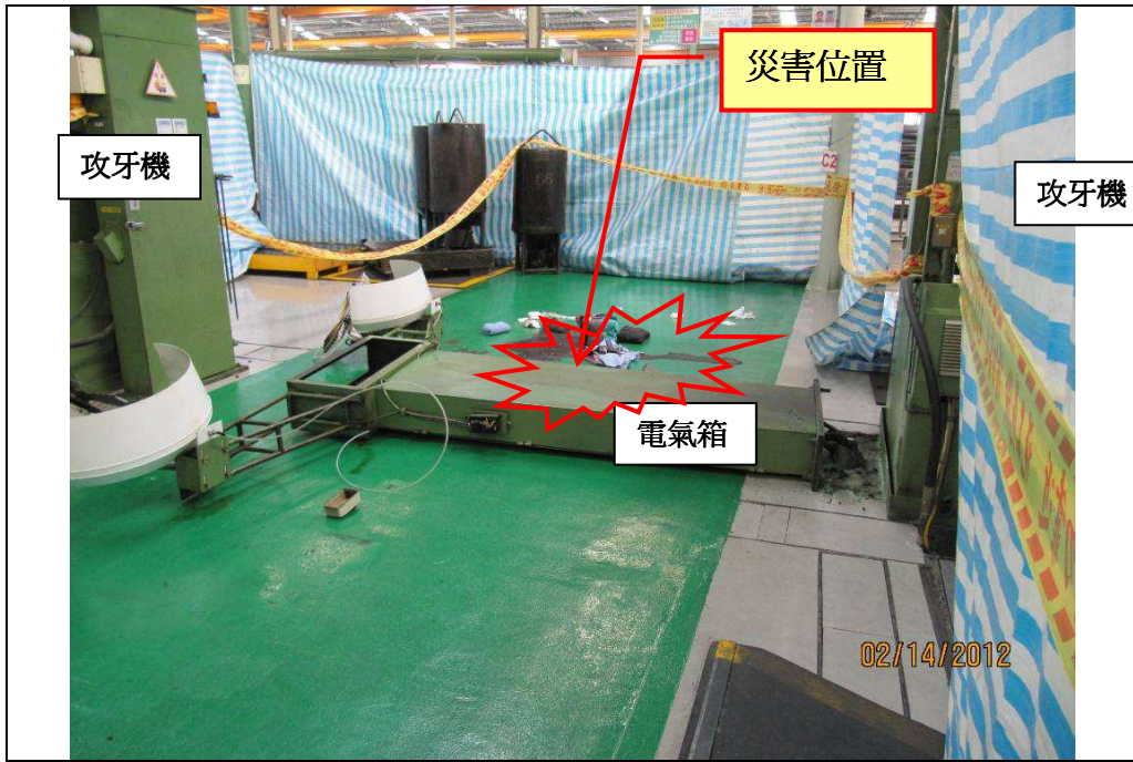
照片說明：災害發生處攻牙機電氣箱倒在中央通道上。
