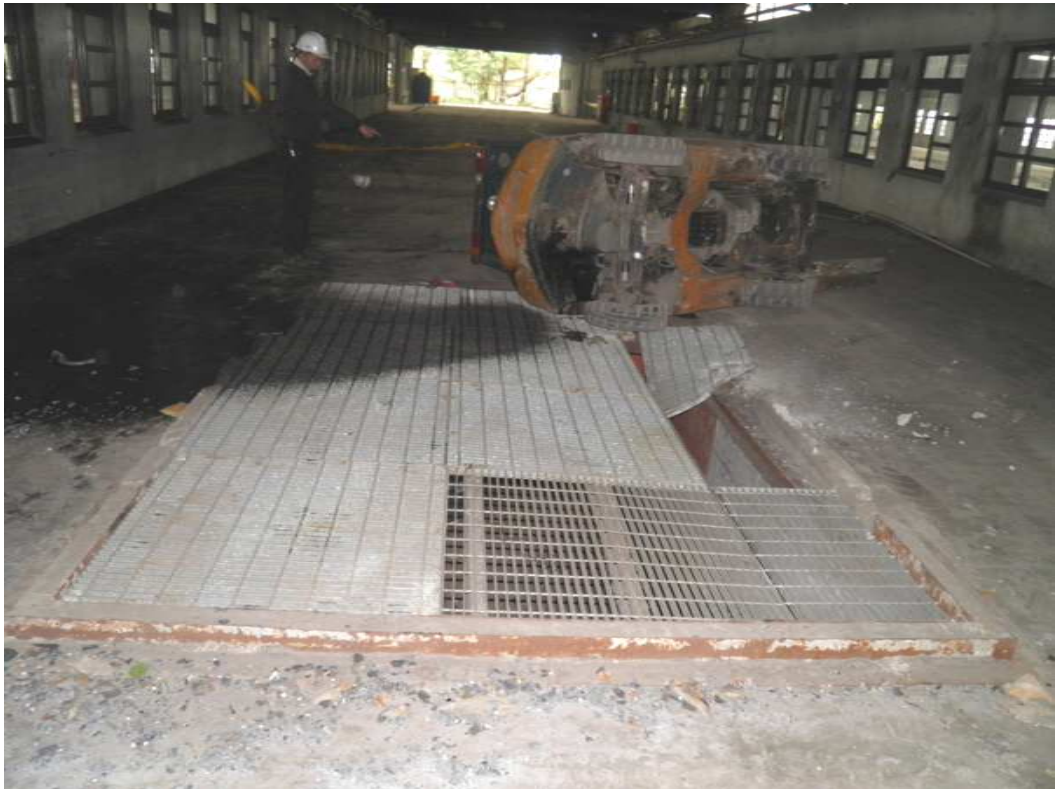
照片：災害發生現場
