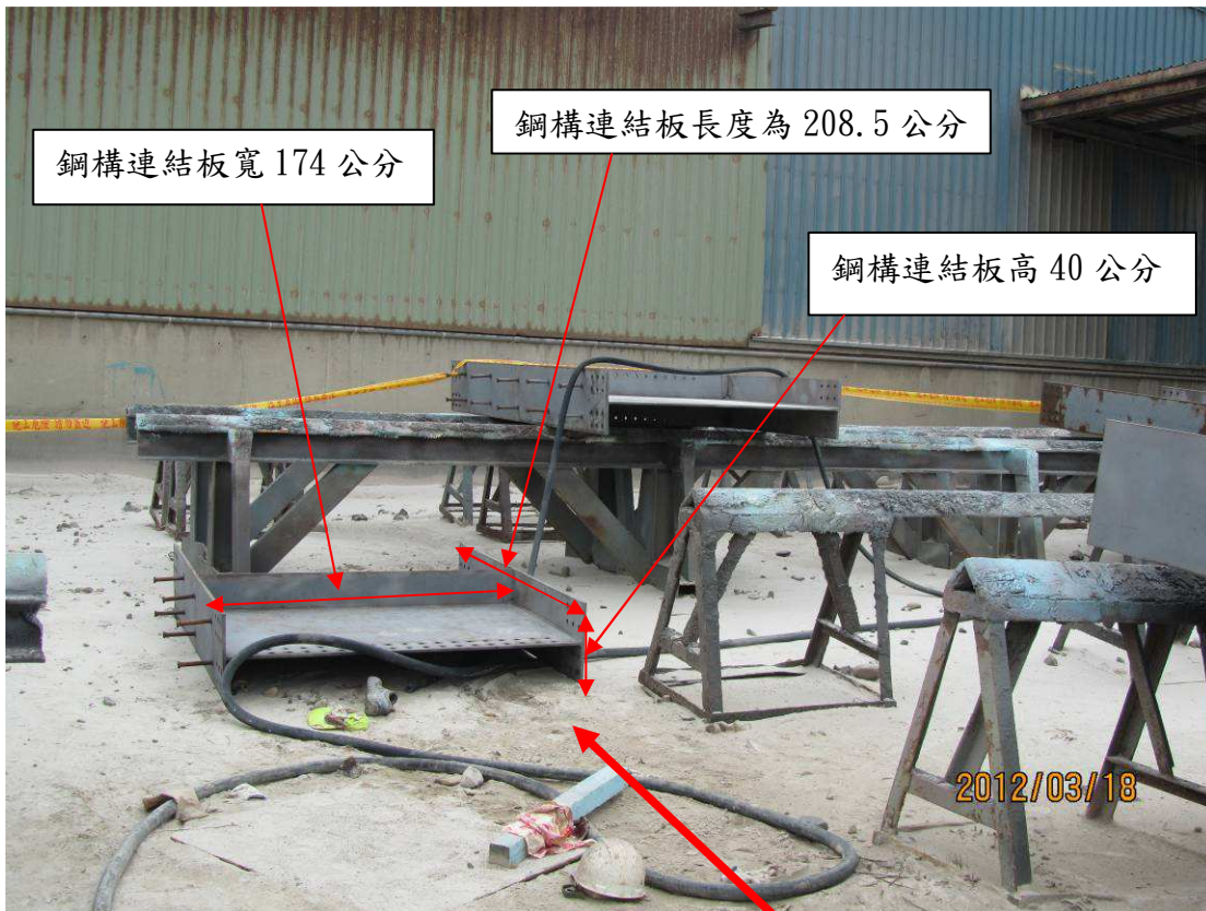
附照 1：噴砂除鏽作業現場。
