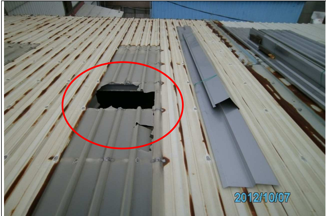
照片說明 1： 葉 00 踏穿塑膠採光浪板處(破裂處約 60 公分 X 60 公分)
