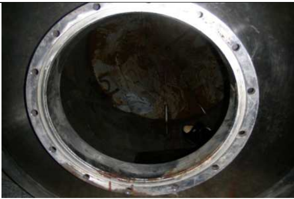
發生災害桶槽人孔
