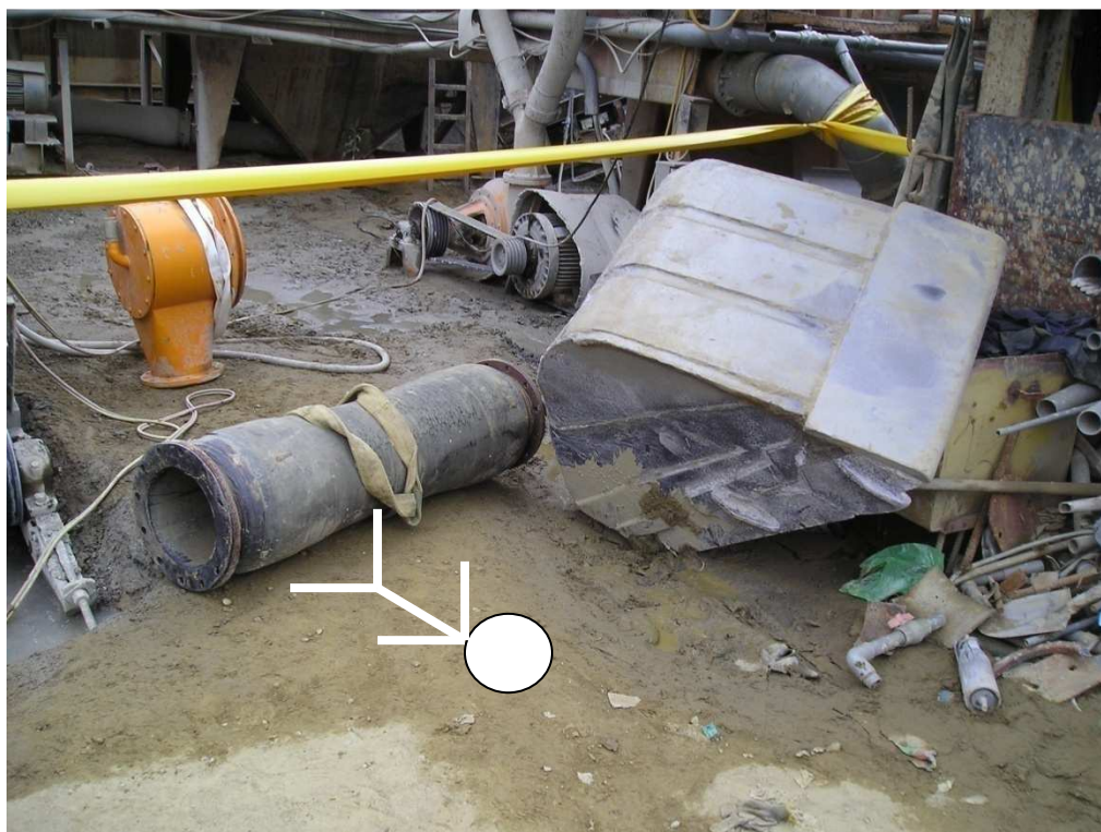
以纖維索為吊掛用具鉤掛於掛耳吊舉肇災之 皮管
