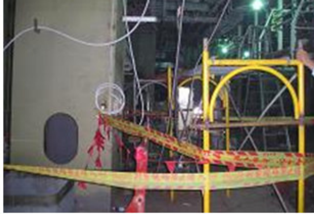
管路支撐架與施工架。↵
