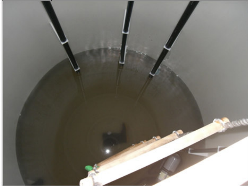
說明二 災害現場：廠區5樓鹼性化學房顯影液桶槽內面。
