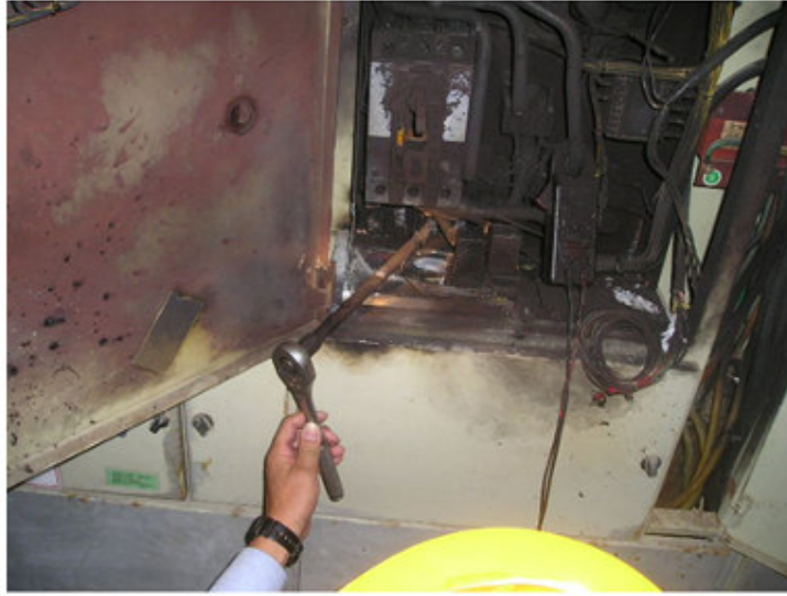
延長桿造成短路之接觸點痕跡與電氣箱外殼至電源一次側之距離吻合。
