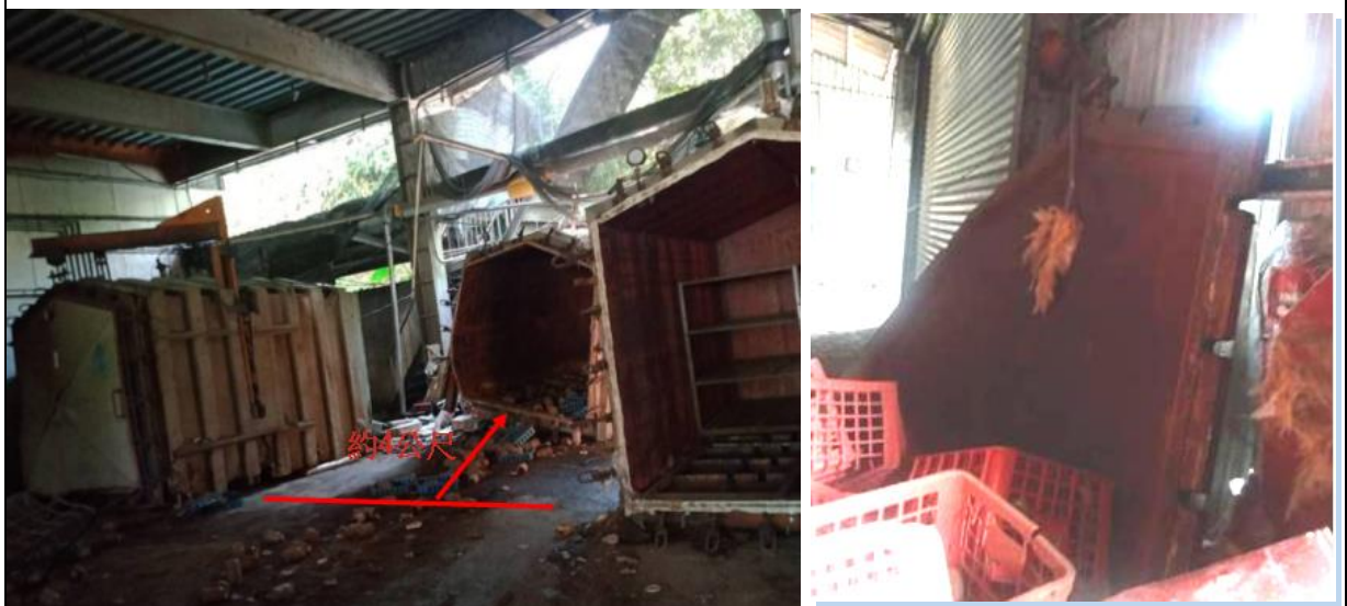
說明：現場災害概況，本體往後位移約 4 公尺，蓋板(門)噴飛約 20 公尺。
