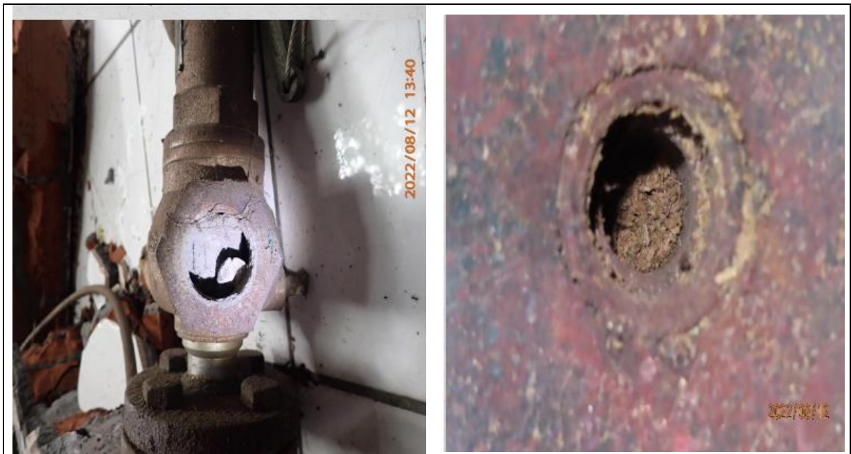
說明：殺菌蒸氣鍋本體安全閥入口處堵塞、安全閥閥體內部堵塞
