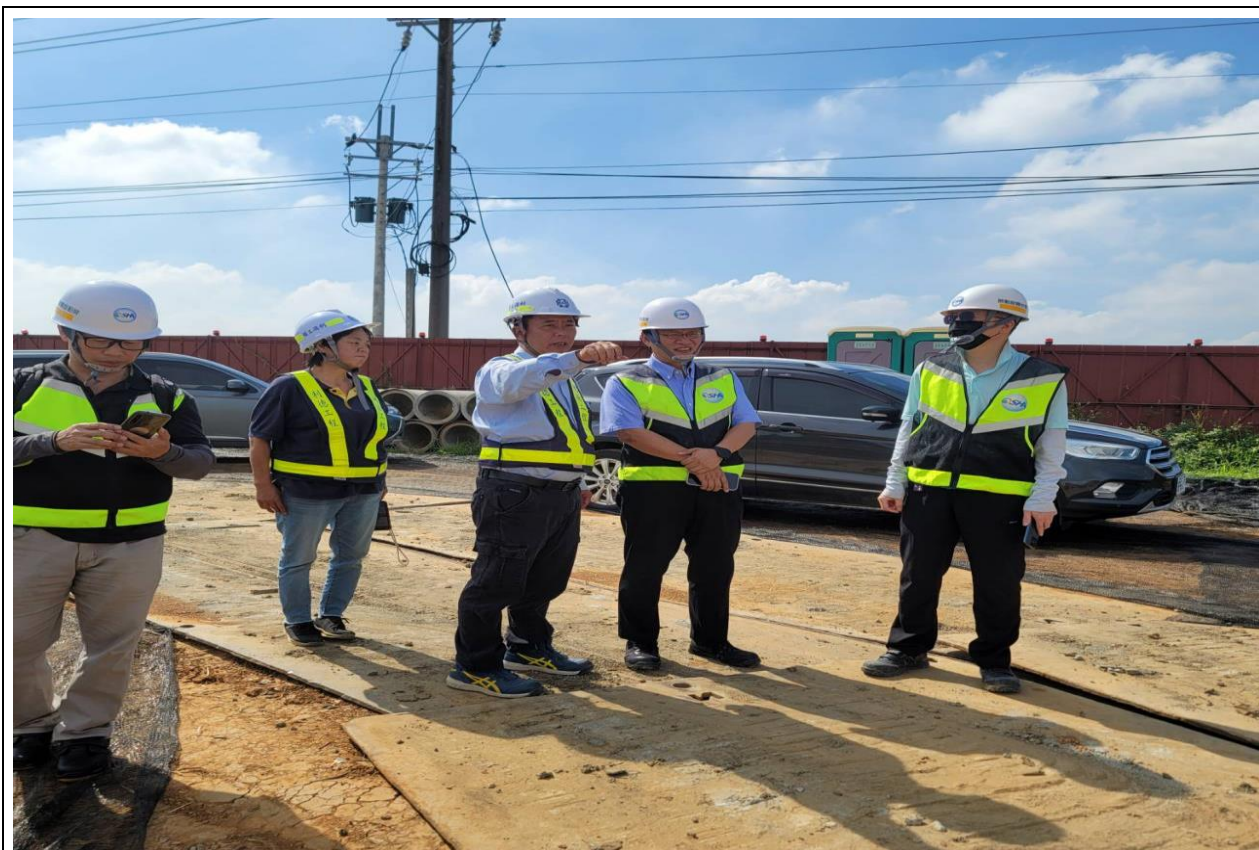
職安署北區職業安全衛生中心曹常成主任率檢查員前往桃園航空城計畫區段徵收工程 C1 分標統包工程實施勞動檢查。
