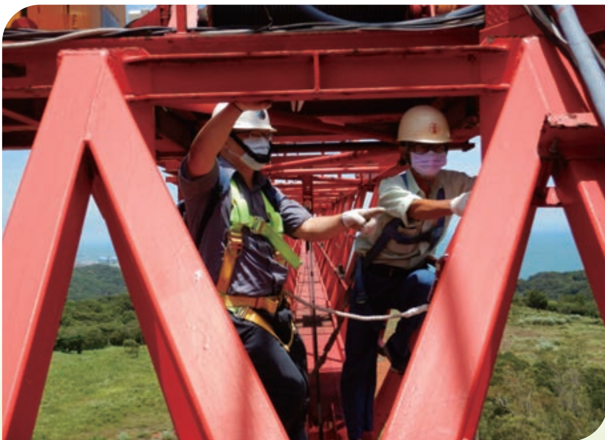
◎ 代檢員對塔式起重機之起重臂以目視檢查確認其焊道及主結構的狀況
