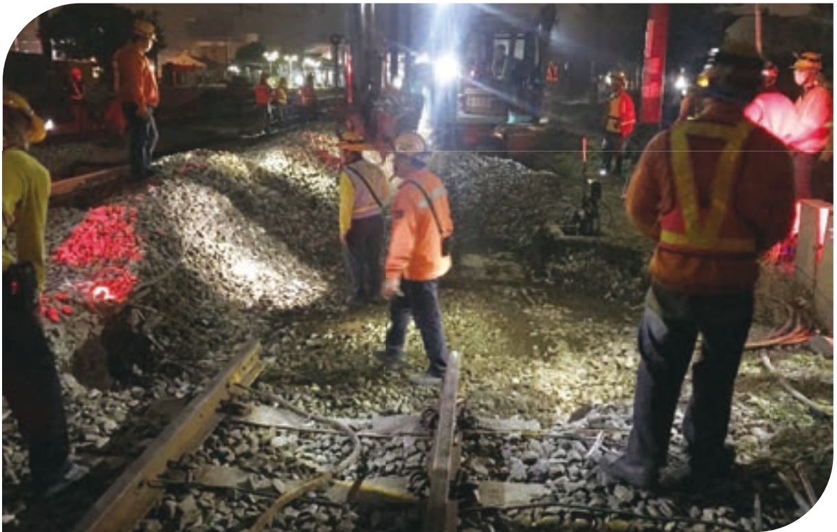
◎ 針對臺鐵夜間工程實施勞動檢查
