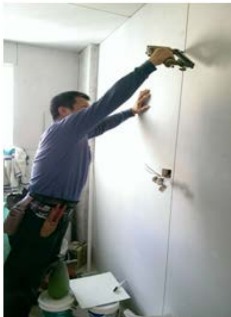
壁板約 20 坪（有鐵皮的部分才需要裝訂壁板），工期約 7 天
