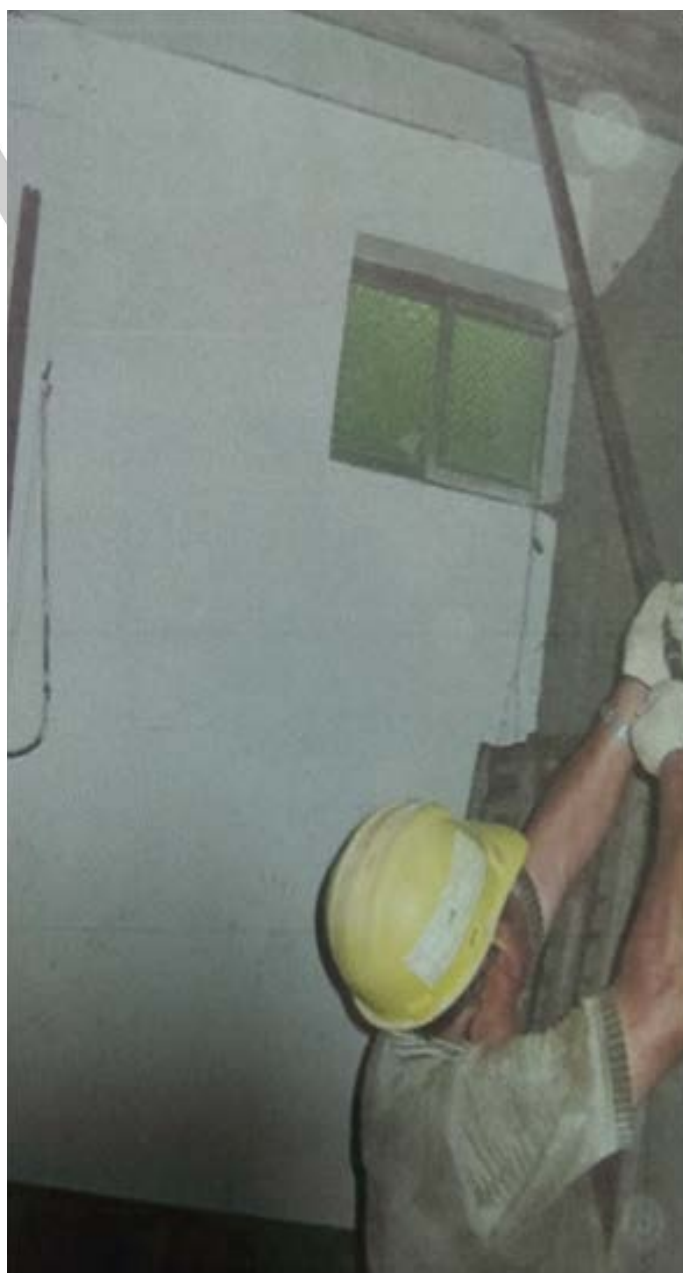
天花板支撐作業
