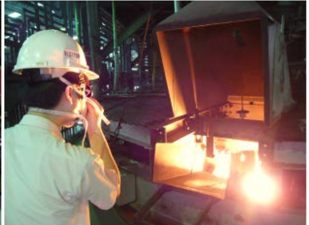
電熔爐另一個入料口，用來將集塵處的粉塵，與乾燥過篩處篩出較細的鎳粉，再倒回電熔爐，旁邊無集塵設備，可能造成粉塵外洩。（三樓爐頂區）
