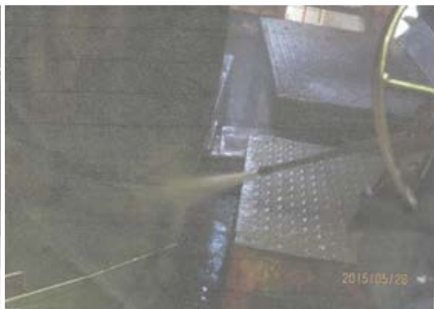
高壓水槍有後座力，故操作時需抵抗其阻力
