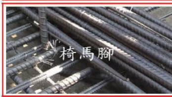
▶ #10椅馬架共計15支，椅馬腳因支撐力不足倒塌嚴重變形。椅馬架設置間距、斜撐筋綁紮之高度及角度，皆由券工以工作經驗自行設置。
