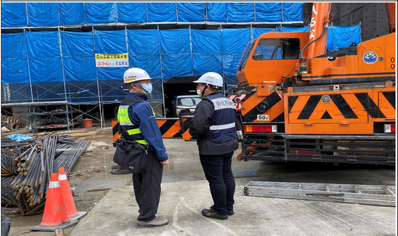
本署朱文勇組長及新北市政府勞動檢查處王喧豐科長率檢查員前往新北市某建築工地實施勞動檢查。
