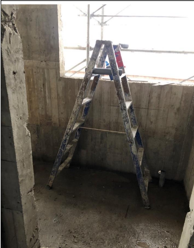
桃園市某建築工地使用不符合規定之合梯(未有固定繫條);另現場使用之電線未架高。
