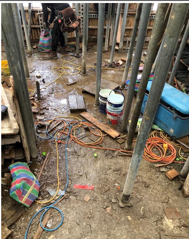
桃園市某建築工地使用不符合規定之合梯(未有固定繫條);另現場使用之電線未架高。
