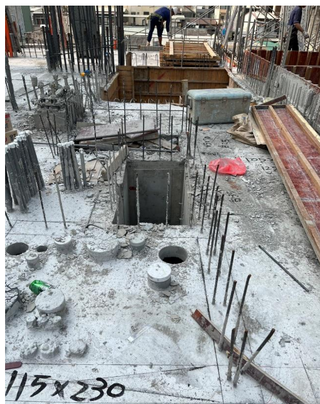
高雄市某建築工地之模板支撐架，未設置使人員安全上下設備；另暴露之鋼筋，未採取彎曲尖端、加蓋或加裝護套等防護設施。
