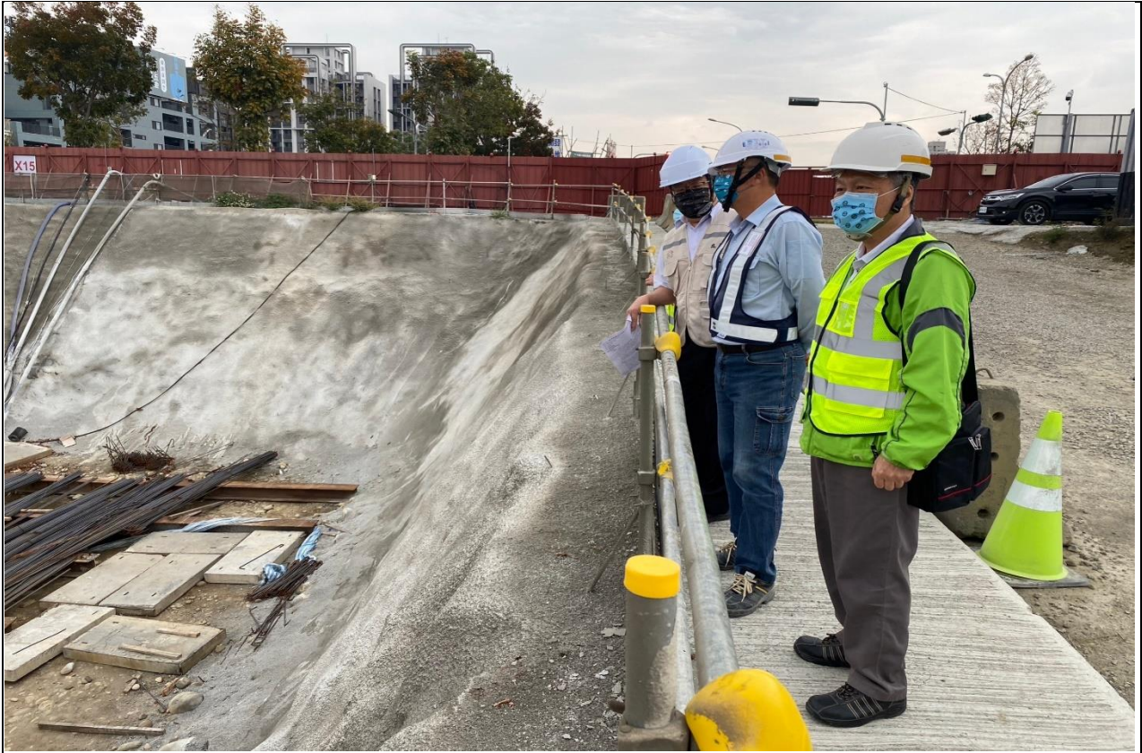
本署林志展副組長及臺中市勞動檢查處邱怡川處長率檢查員前往臺中市某大型公共工程實施勞動檢查。
