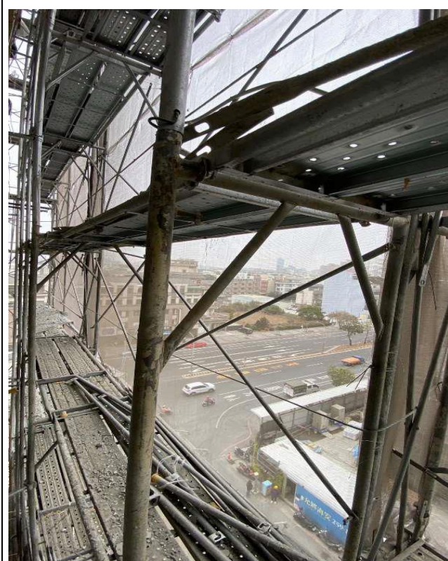
臺南市某建築工地外牆施工架開口部分未有防墜設施，外牆施工架與混凝土模板支撐連接。
