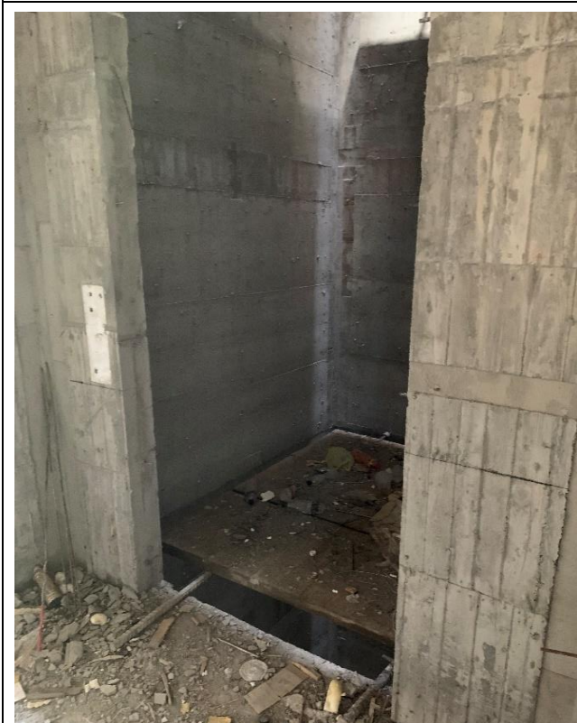
高雄市某建築工地電梯井工作臺未置備施工圖說及強度計算書，外牆吊料平臺未設護欄。
