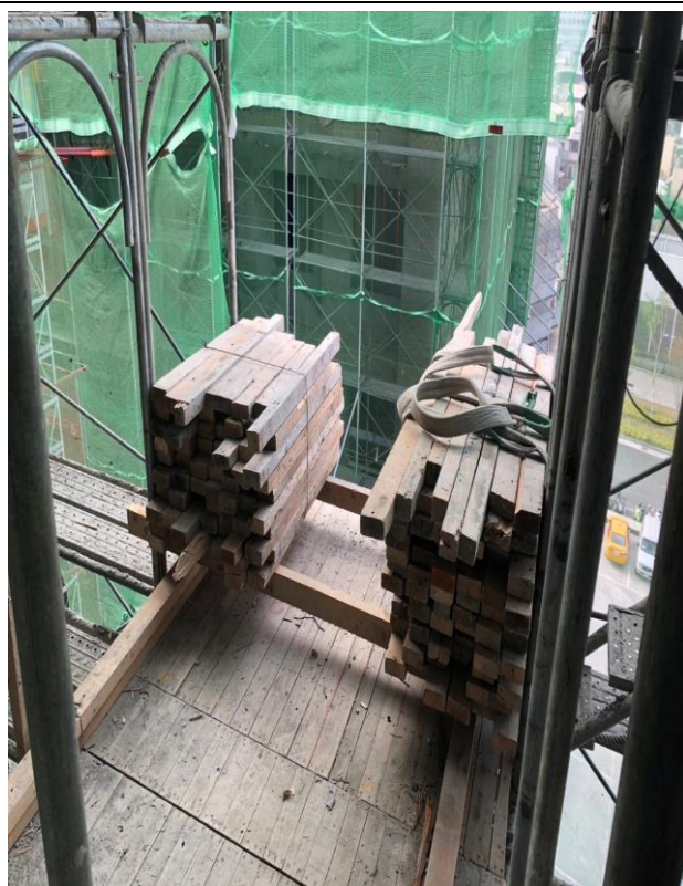
高雄市某建築工地電梯井工作臺未置備施工圖說及強度計算書，外牆吊料平臺未設護欄。
