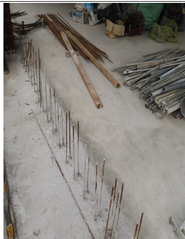
臺北市某建築工地外牆施工架開口未設安全防墜設施，樓板預留鋼筋未加裝護套。
