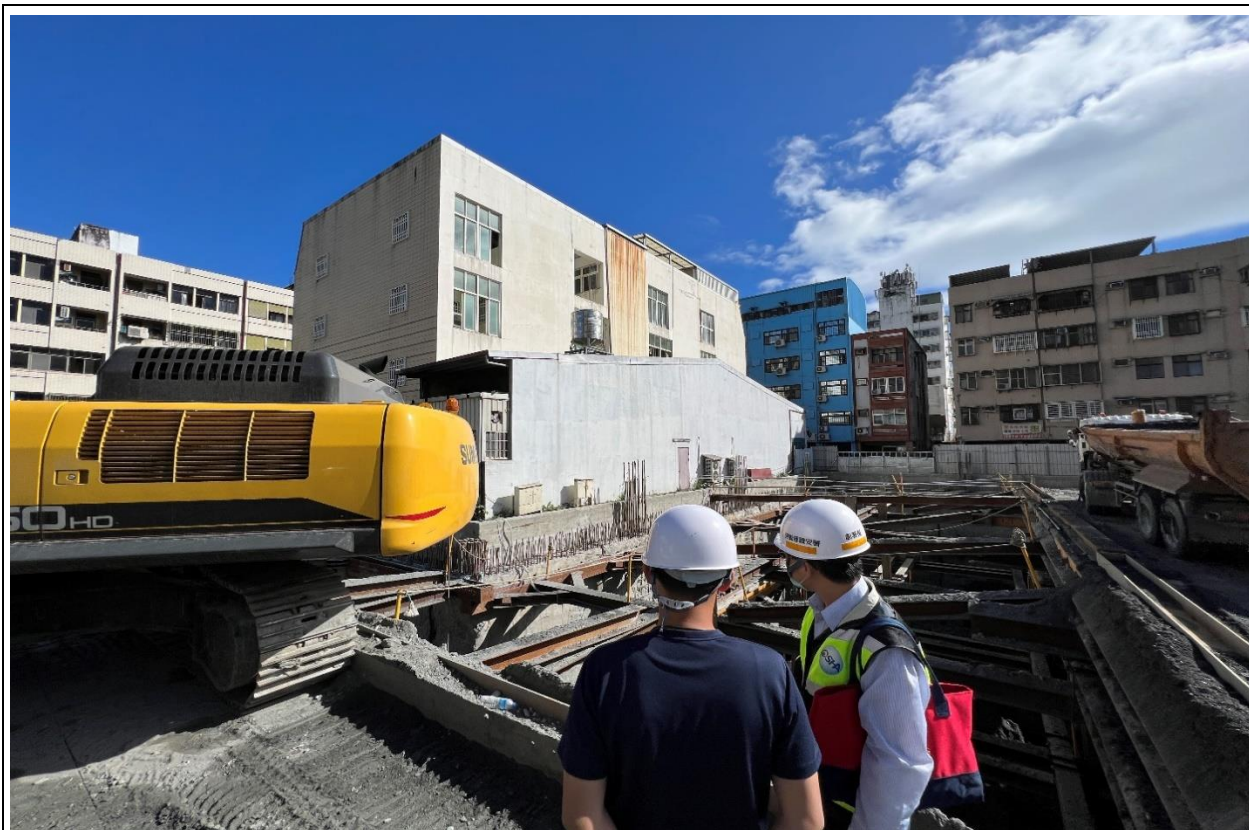
本署朱金龍副署長率檢查員前往東部某建築工地實施勞動檢查。
