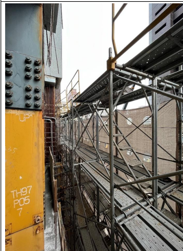
臺北市某建築工地外牆施工架開口未設安全防墜設施，樓板預留鋼筋未加裝護套。
