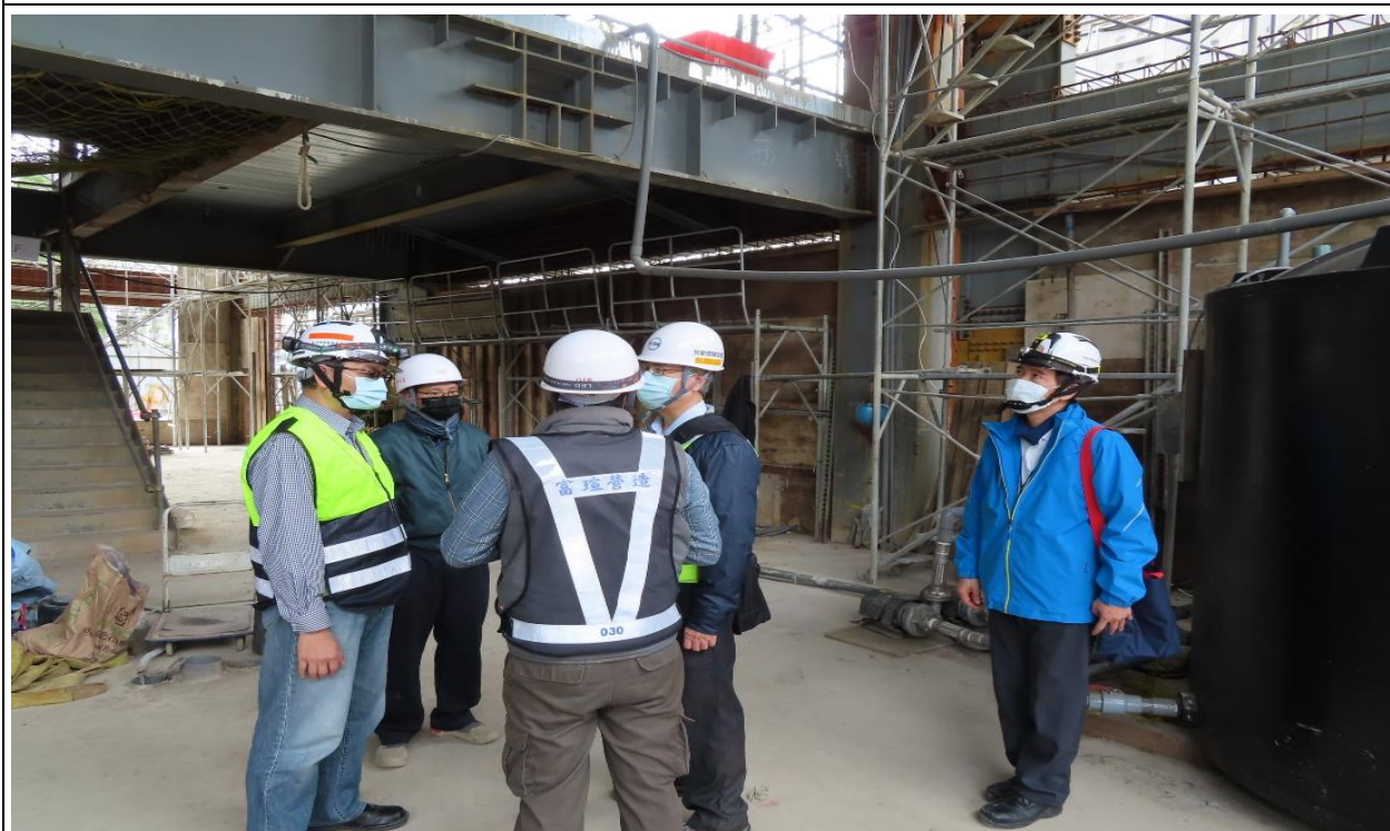
本署朱文勇組長及臺北市勞動檢查處康水順主任秘書率檢查員前往臺北市某建築工地實施勞動檢查。
