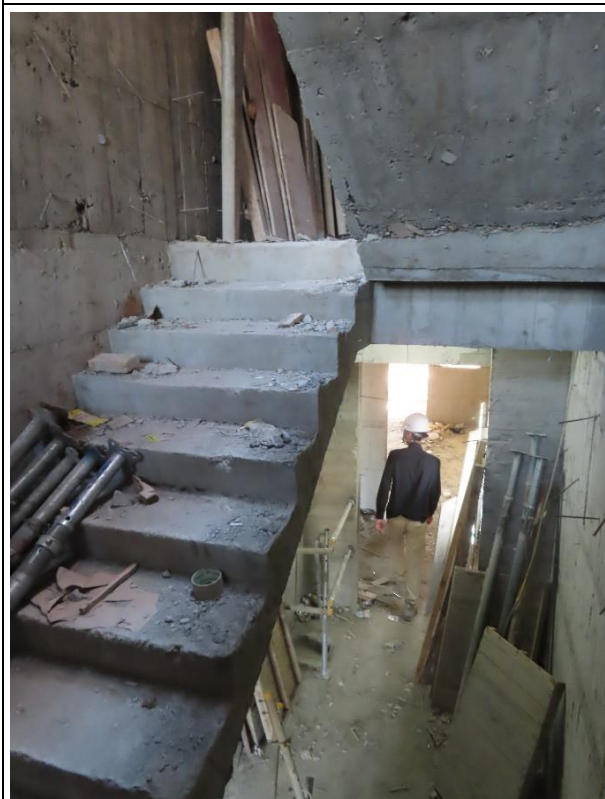
臺中市某建築工地室內樓梯及天井區施工架等開口部分未設置護欄。
