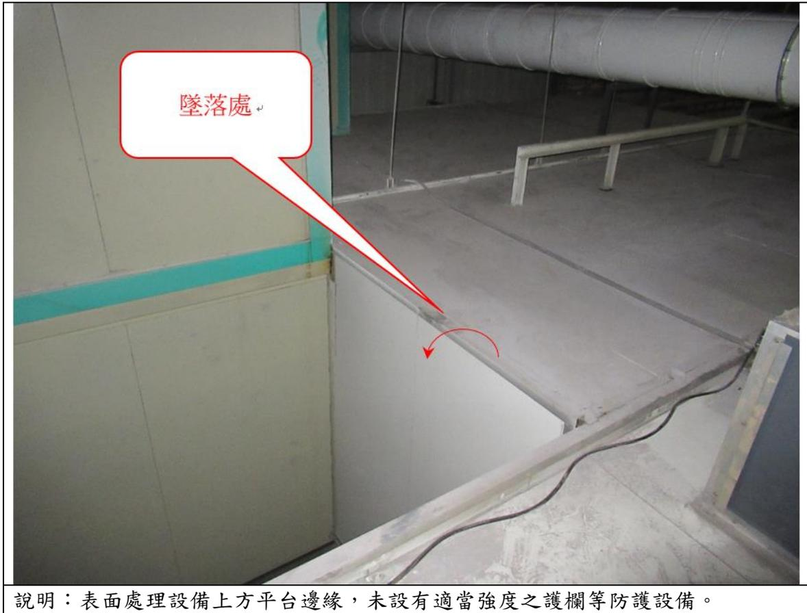
說明：表面處理設備上方平台邊緣，未設有適當強度之護欄等防護設備。
