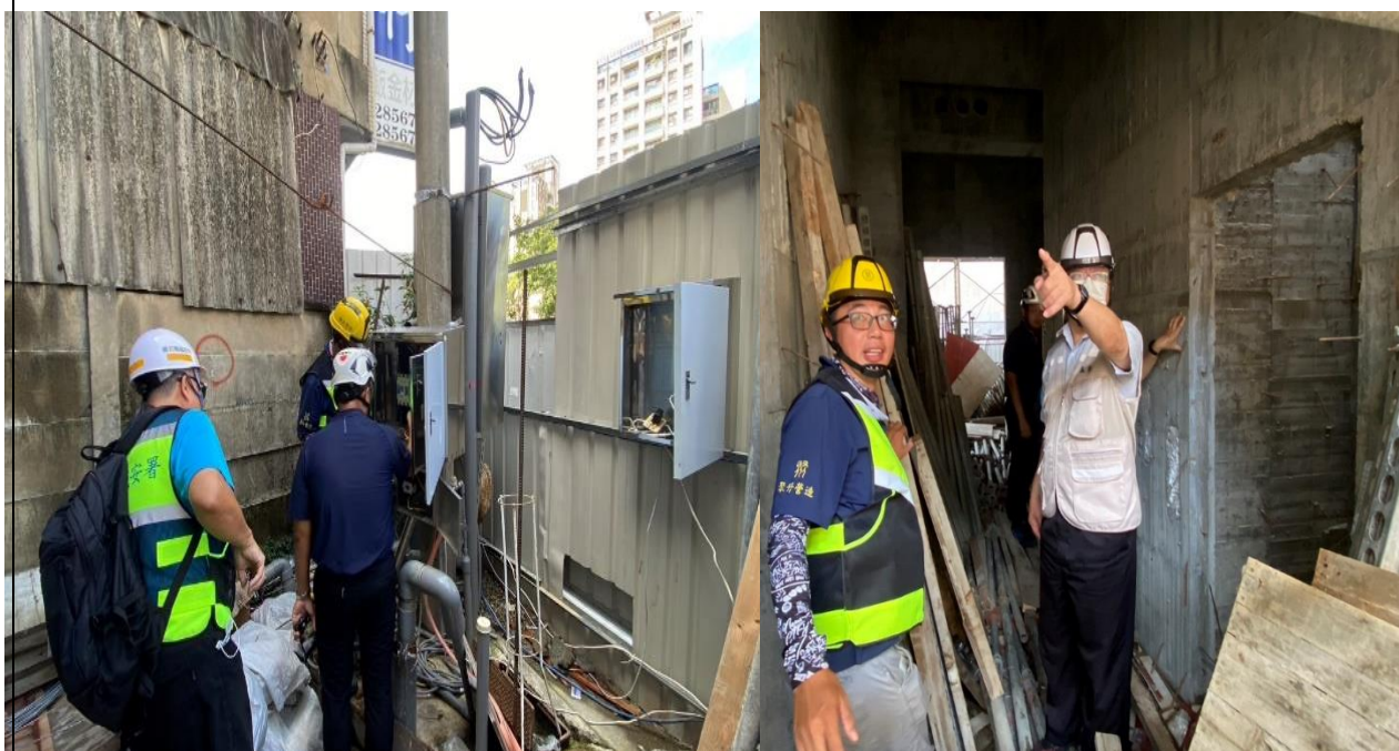
本署職業安全組林志展副組長與臺中市勞動檢查處邱怡川處長率檢查員前往臺中市某建築工程實施勞動檢查。
