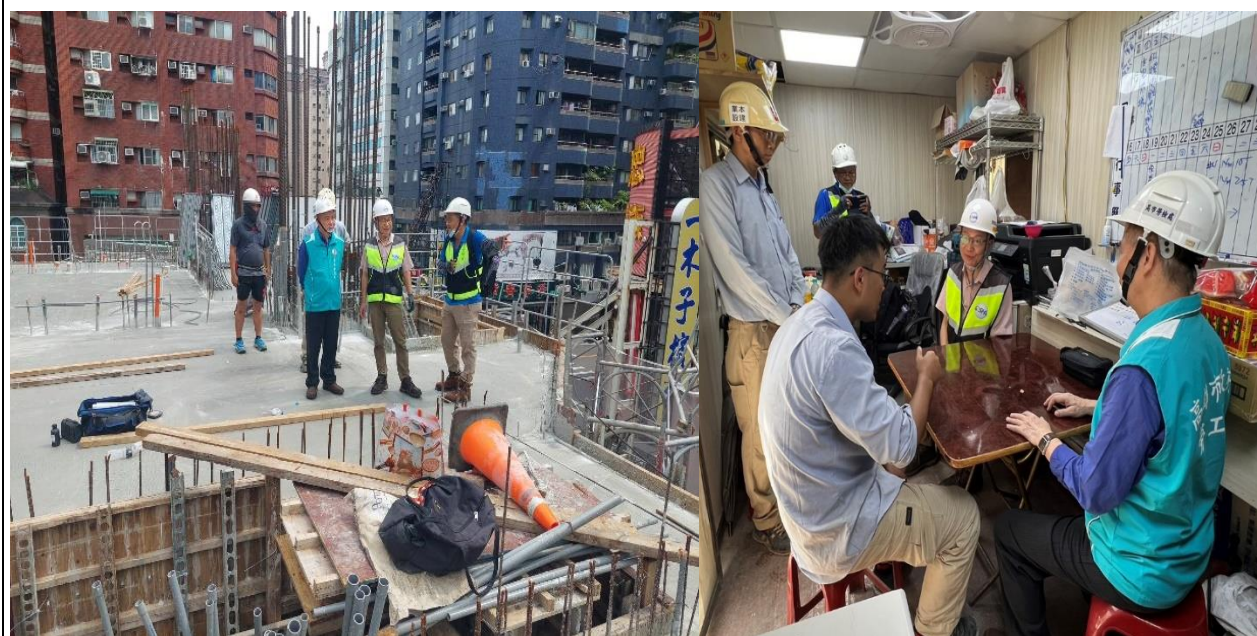
本署職業安全組陳志祺簡任技正與高雄市政府勞工局勞動檢查處林信興副處長率檢查員前往高雄市某建築工地實施勞動檢查，並於檢查後於工務所內說明本次檢查結果及督促事業單位改善。
