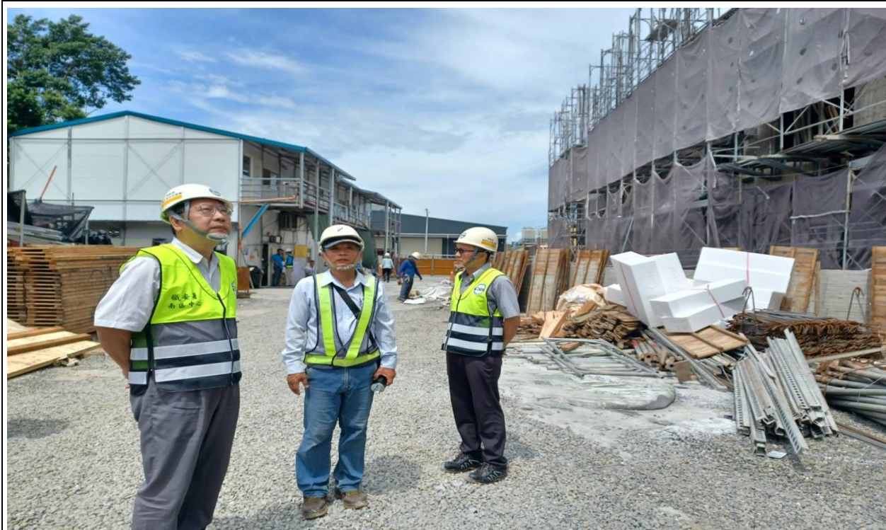
本署南區職業安全衛生中心許峯源主任率檢查員前往臺南市某建築工程實施勞動檢查。
