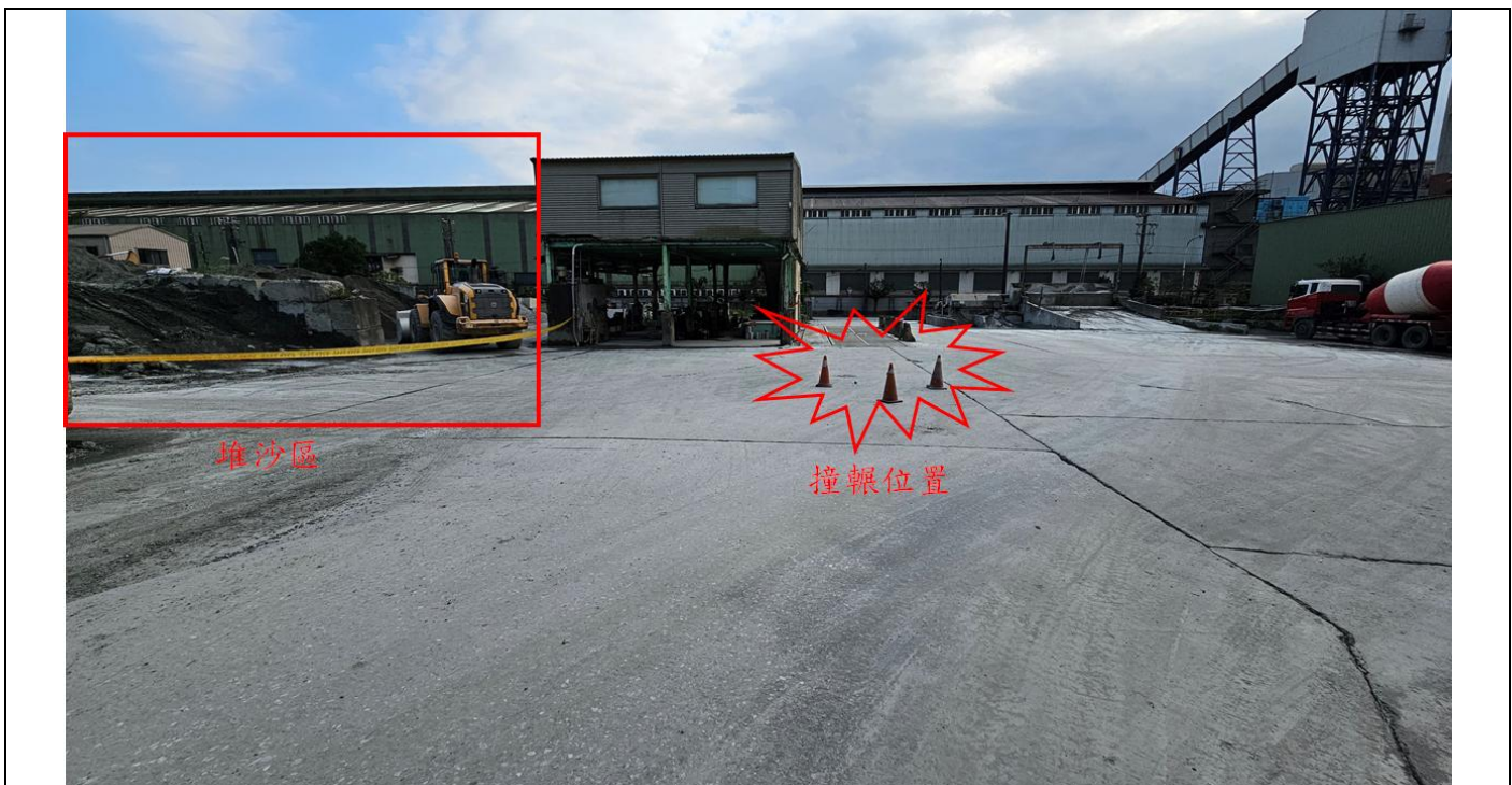
說明 2、本案災害發生現場概況。災害發生時移工范○於廠內堆砂區駕駛鏟裝機從事推砂作業，該堆砂區與廠區自設道路相連，未有明顯境界區隔或管制線，自設道路亦無規劃人行道，車道寬度約 11-14 公尺。推砂作業過程中需於廠區道路前進、後退及調整車輛角度，倒車時撞輾當時巡視廠區行經該區之副總經理李○。
