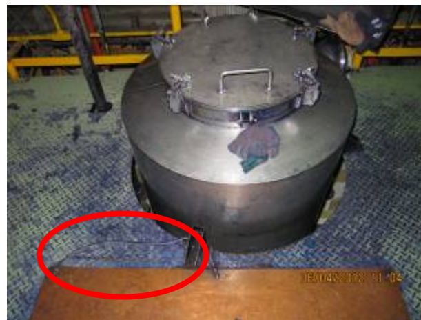
靜電消除銅板
