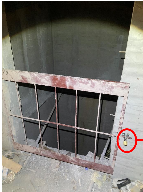
照片 1 罹災者作業之 15 樓垃圾管道電梯井，未設置警告標示。
