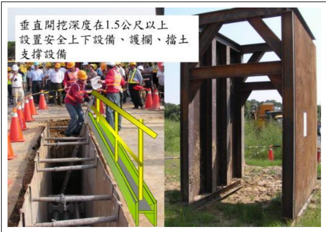
照片 18 管溝開挖深度 1.5 公尺以上，設置安全上下設備、護欄、擋土支撐設備等
