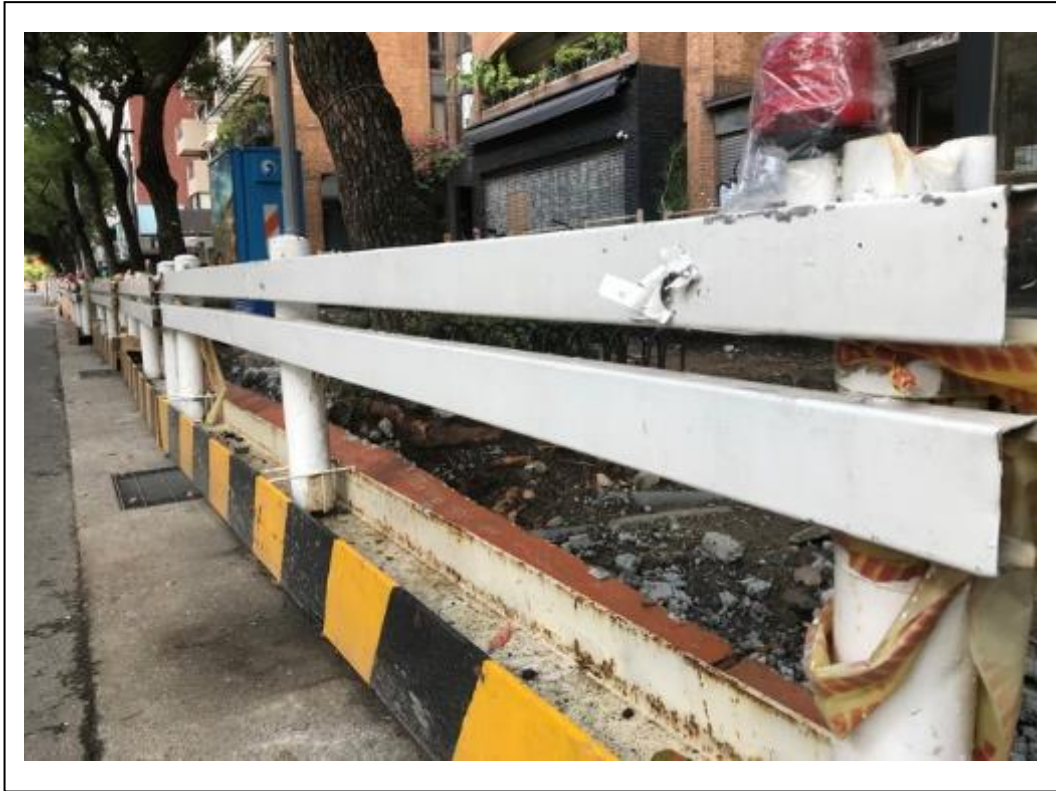
照片 17 管溝開放邊緣部分使用護欄與型鋼共構組合 參考圖
