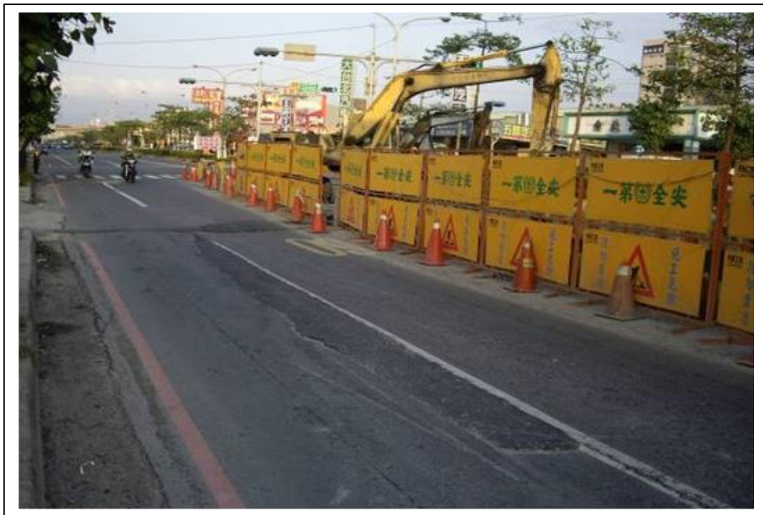
照片 02 管溝開挖工作場所周圍以移動式圍籬、交通錐等圍成警示區
