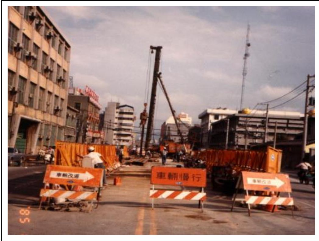
照片 03 露天開挖(打樁作業)工作場所周圍以移動式圍籬、交通標識等圈圍成警告標示
