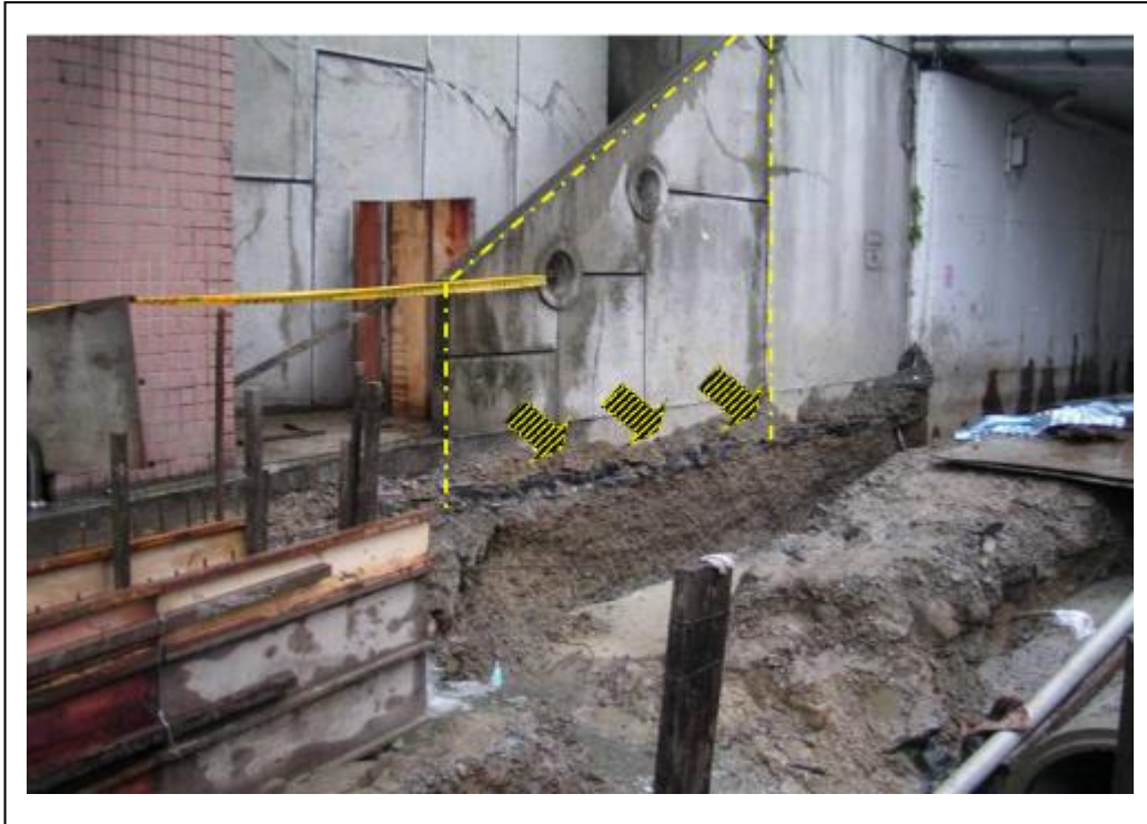
照片 13 管溝挖掘使磚壁等構造物之基礎露頭、受損、土壤鬆動等損害
