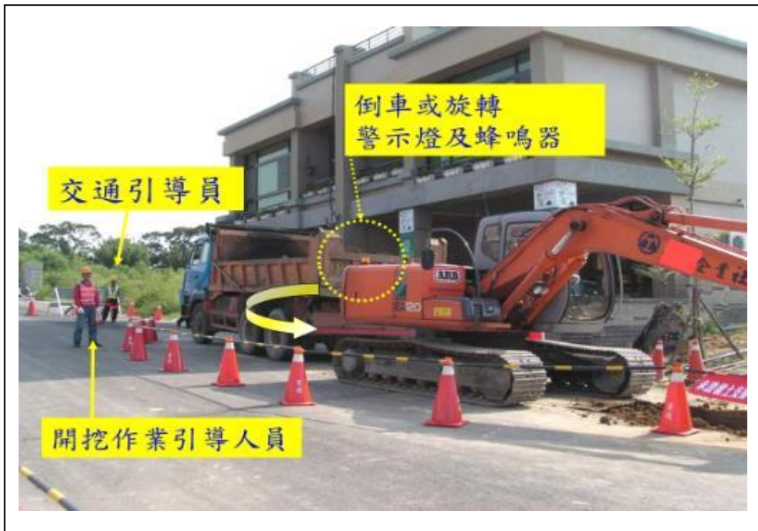
照片 08 於搬運機械作業或開挖作業時，應指派專人指揮；車輛機械應裝設倒車或旋轉警示燈及蜂鳴器
