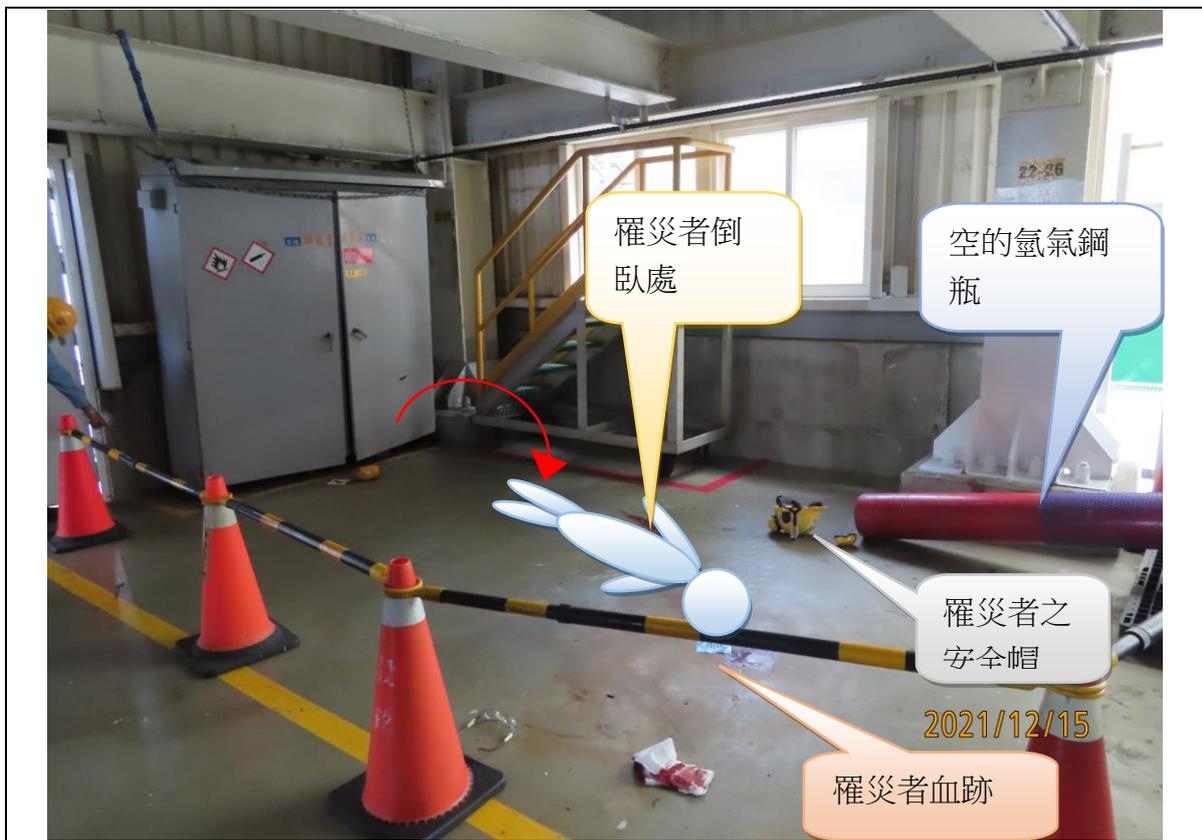
說明：罹災者倪○○倒臥處，鋼瓶櫃直接向罹災者處倒塌。
