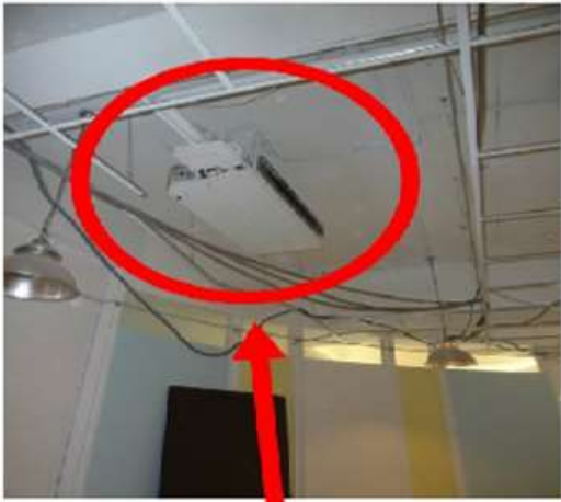
包覆冷氣（高度約 3.4 公尺），避免進行牆面油漆工程時弄髒
