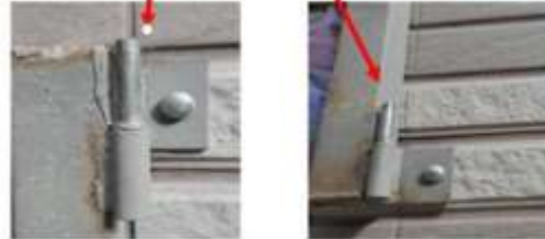
說明：經查一同掉落之鐵格柵，其鉸鏈皆完好無損，研判為勞工進行窗台鐵格柵復歸作業時，疑重心不穩，導致罹災者及鐵格柵一同從開口處墜落至地面。
