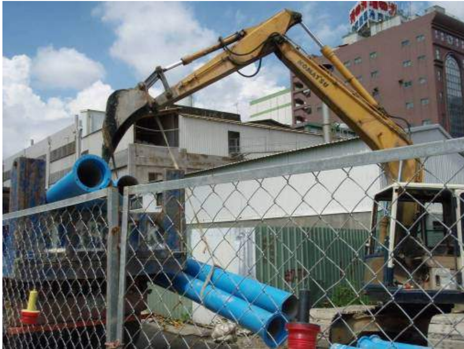
事故發生時現場之相對關係位置。
