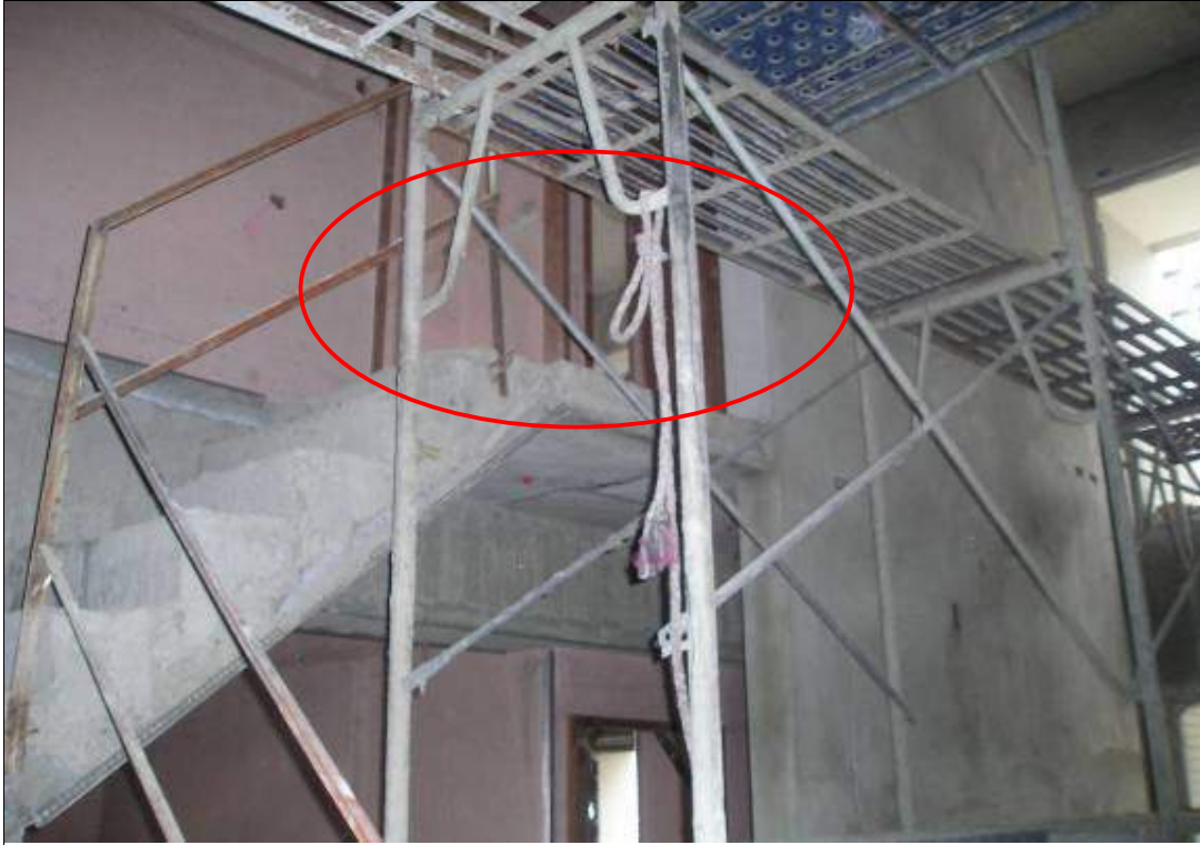
說明 附照 1 罹災者墜落處未設護欄等防墜設施
