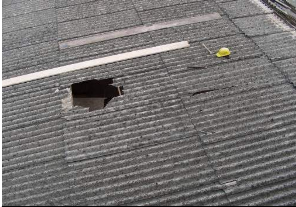
照片 溫○○從石棉瓦屋頂踩空處
