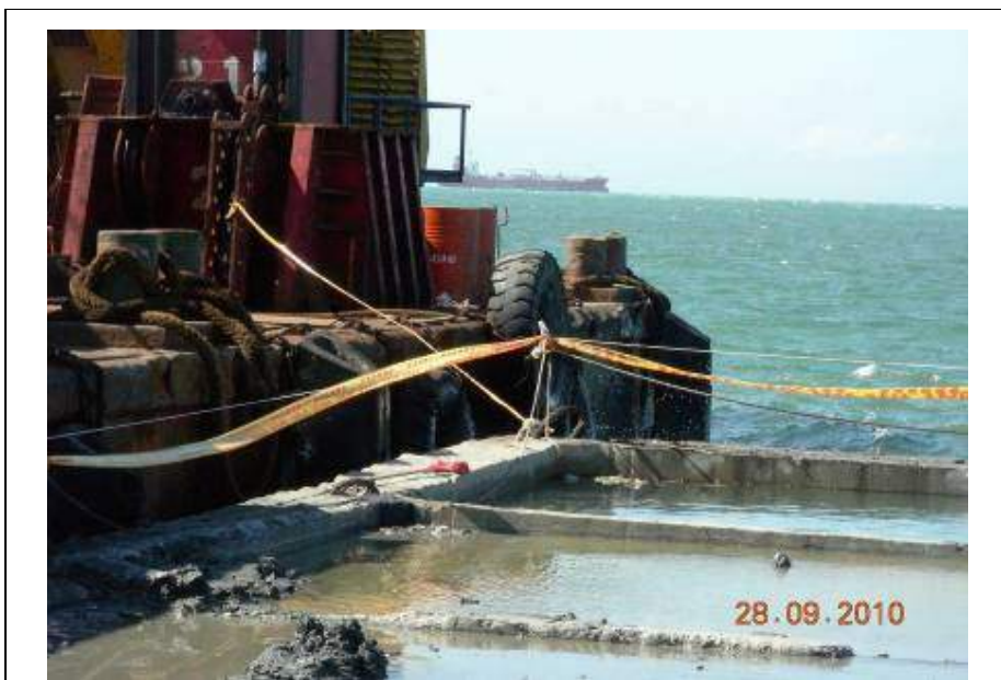
說明 照片 2 罹災者盧○○浮出水面攀於平台船旁輪胎碰墊上
