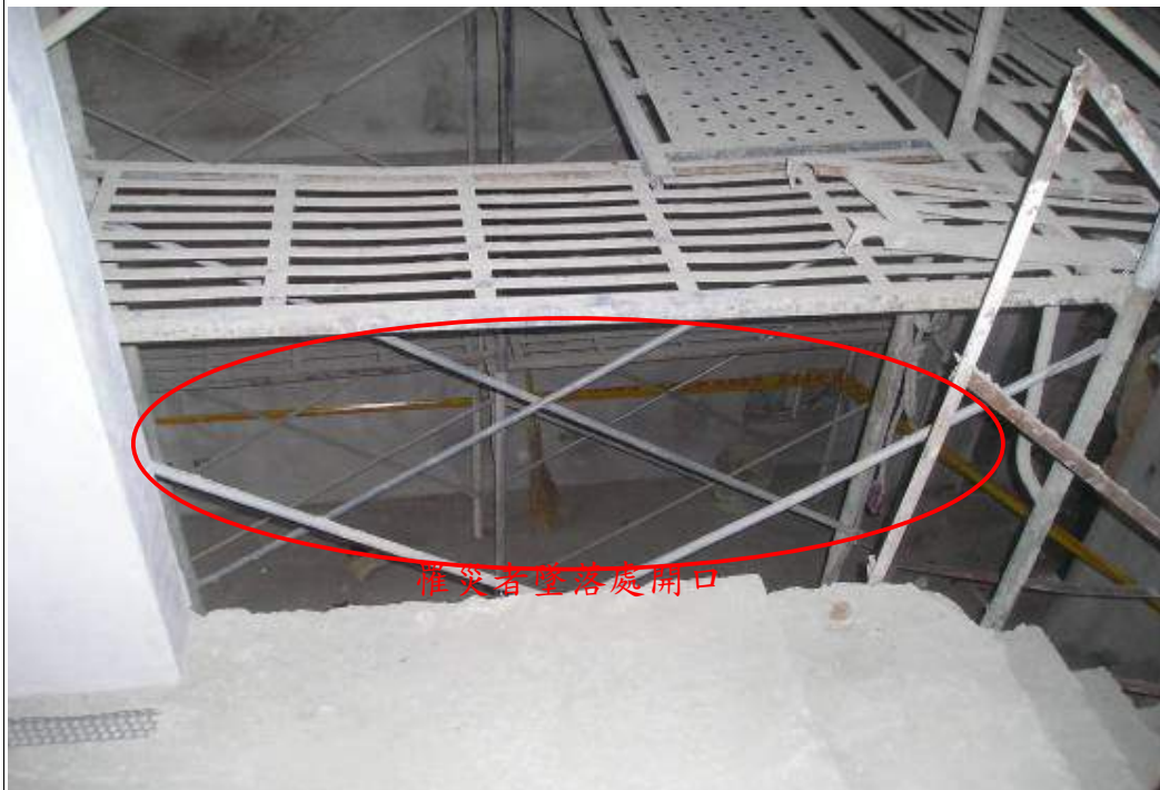
說明 附照 1 罹災者墜落處未設護欄等防墜設施
