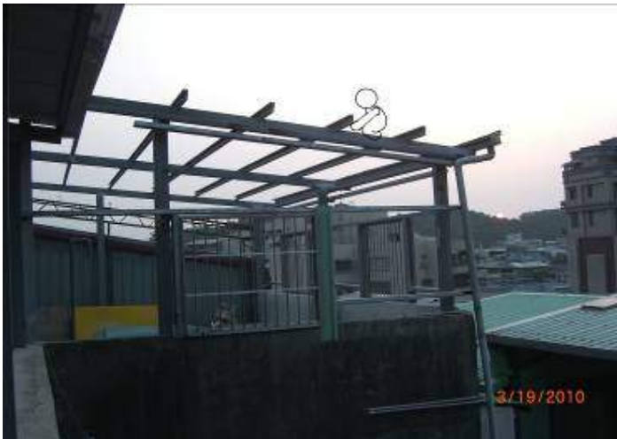
罹災者在屋頂拆除烤漆浪板示意圖。
