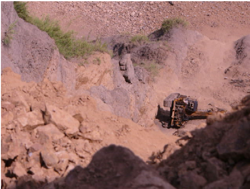
災害現場挖土機跌落大安溪溪谷，深度約 50 公尺，挖土機已變形。
