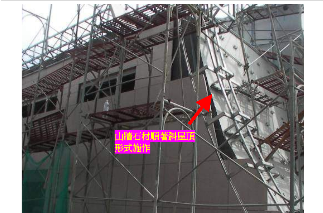
照片 2 肇災當日施工項目為配合金屬包版修改石材，山牆係順著斜屋頂形式施作
