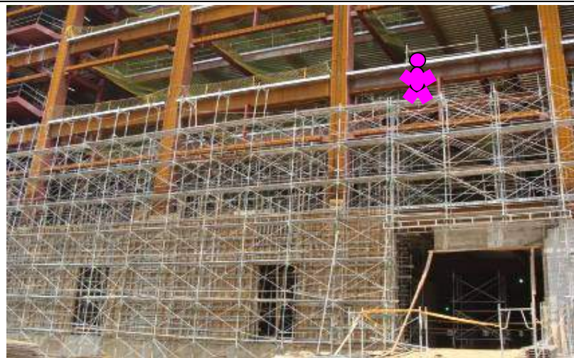
B21 棟外牆(2 樓至 3 樓間)施工架組配人員站立處(墜落離地約 12 公尺)
