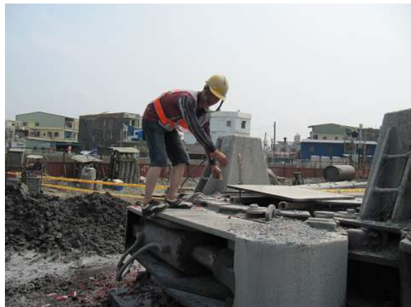
模擬災害當時罹災者側身彎腰站立於搖管機平台(鋼製)之位置
