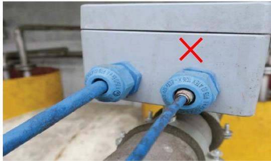
圖 6 電纜封函蓋應與電纜直徑相匹配
