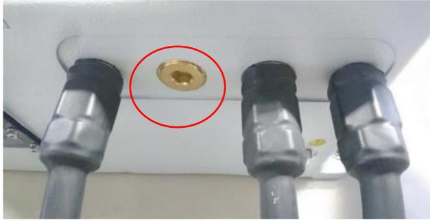
圖 7 未用開孔應以防爆盲塞封閉
