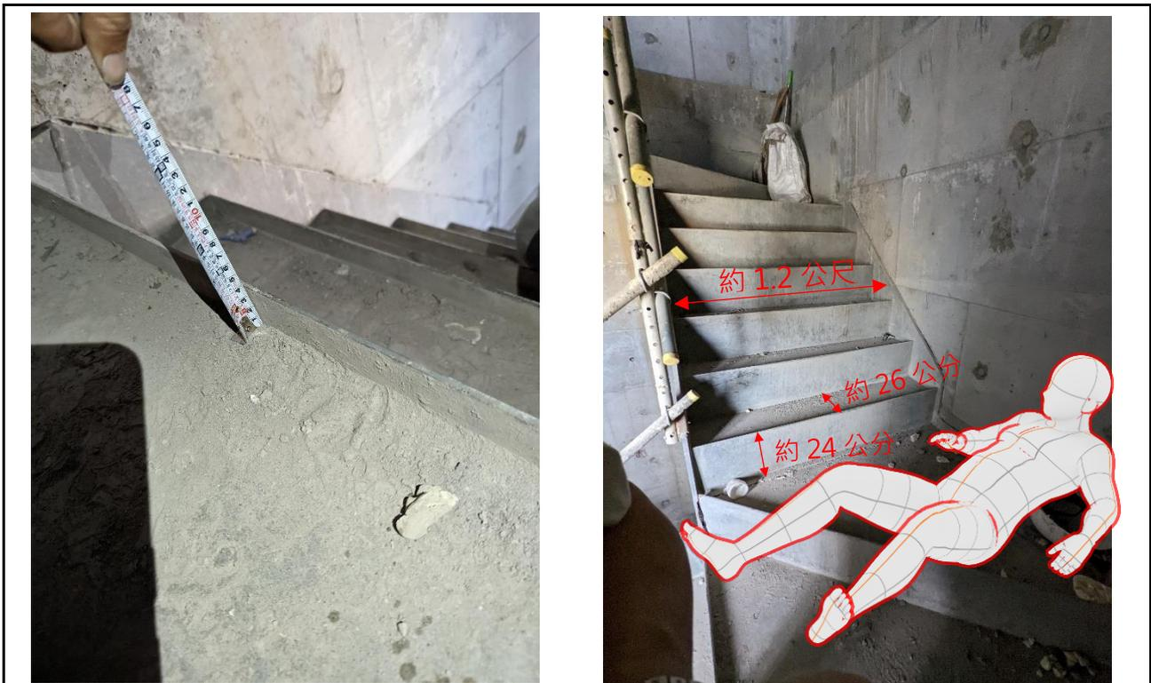
說明：鋼樓梯淨寬約1.2公尺、級深約26公分，因梯級鼻端之垂直突出鋼板造成樓梯於完成澆置水泥前之級高達24公分不利人員行走，致黃罹災者於鋼樓梯行走時遭該突出鋼板絆倒後滾落。
